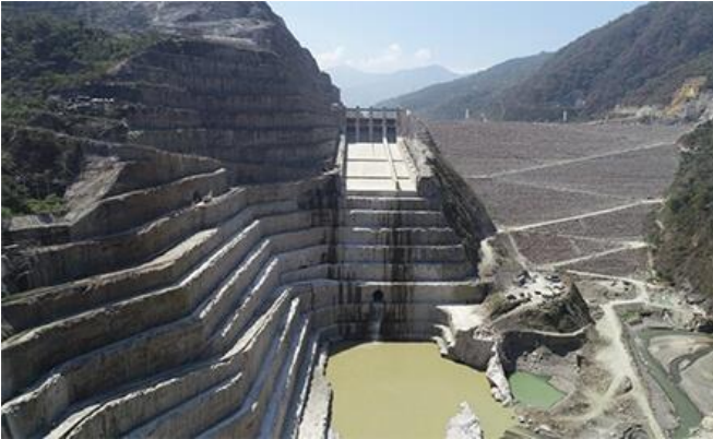
Figura 10. Cierre de la compuerta 2
