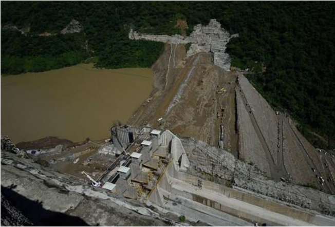
Figura 8. Taponamiento de la galería auxiliar de desviación
