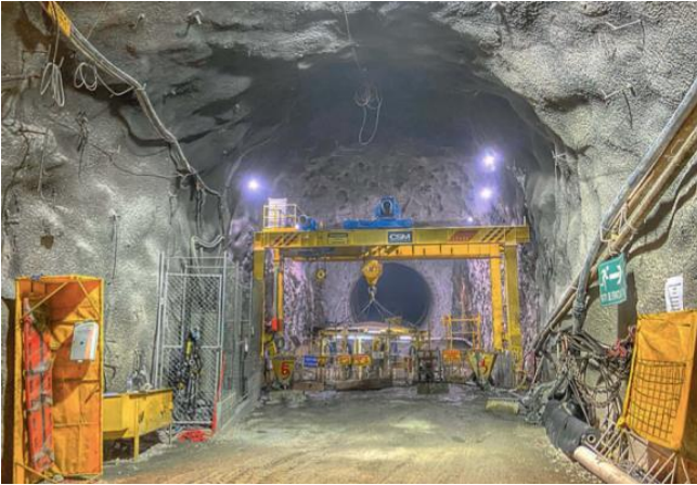
Figura 12. Taponamiento de socavón
