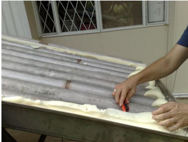
Figura 48. Aislamiento del colector solar.
