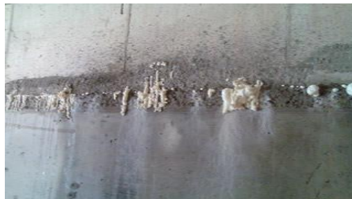
Ilustración 5 Sellado de junta fría en concreto
