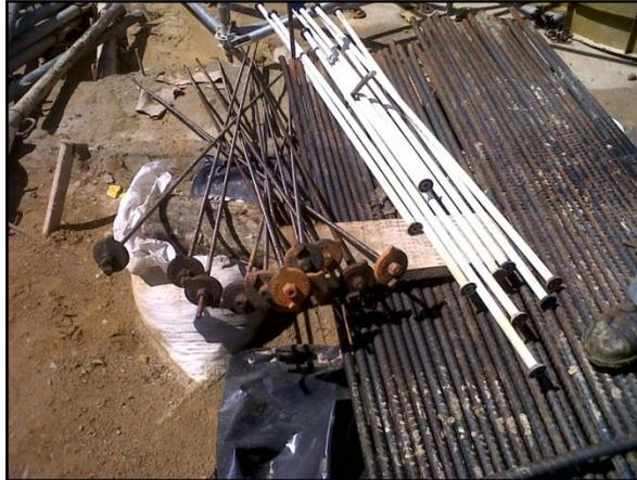
**Foto 107. Tensores para formaleta metálica.**
