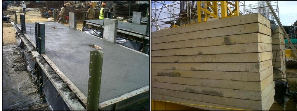
**Foto 118. Losas para torre grúa. Foto 119. Losas para torre grúa.**
