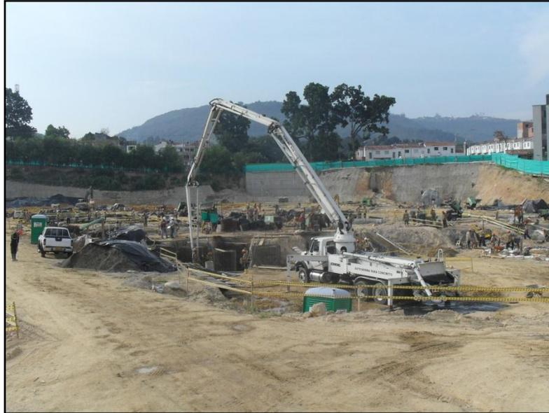
**Foto 27. Vaciado de concreto en cajones ejes C-3.**
