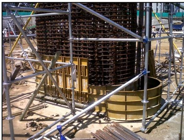
**Foto 108. Instalación formaleta metálica.**
