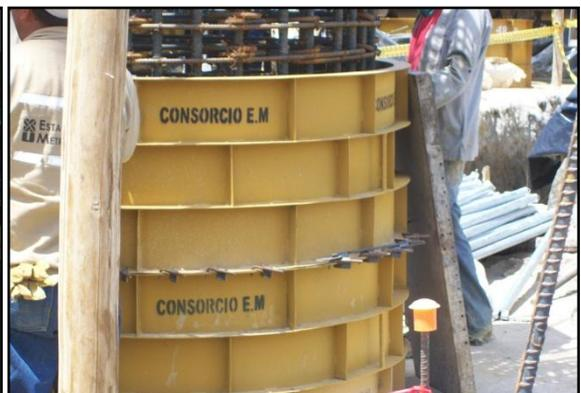
**Foto 58. Formaleta metálica columna.**
