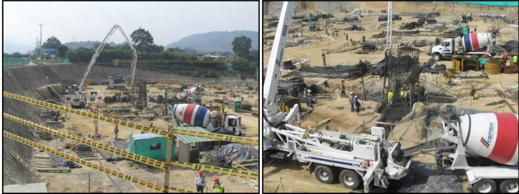
**Foto 37. Panorama vaciado concreto. Foto 38. Vaciado concreto en dado.**
