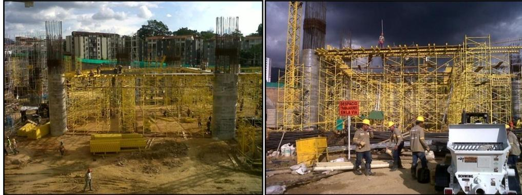
**Foto 132. Formaleta vigas y placa. Foto 133. Formaleta vigas y placa.**
