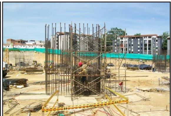
**Foto 56. Armado acero columna.**
