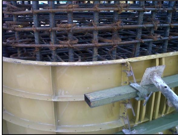
**Foto 76. Formaleta metálica para columnas.**
