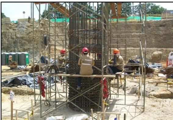
**Foto 55. Armado acero columna.**
