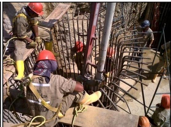
**Foto 15. Acero cajón de cimentación. Foto 16. Vaciado de concreto.**
