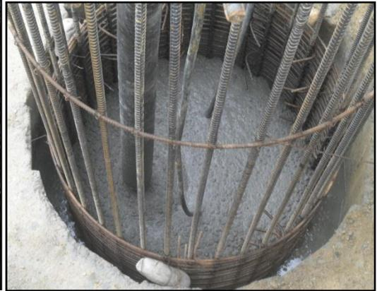
**Foto 18. Vibrado del concreto.**
