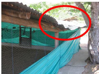
2. Las vigas que sostienen el techo del galpón No. 1 no son las adecuadas, debido que se encuentran vencidas y partidas, ocasionando un riesgo locativo (desplome) y mecánico (golpes por caída de objetos).
