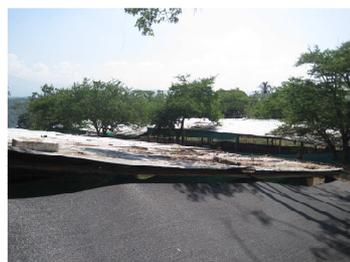
11. Las bases e los tanques de almacenamiento de agua no son las adecuadas, no cuentan con el espacio suficiente y seguro para ejecutar la labor que allí requieren lo que ocasiona un alto riesgo por caída de alturas.
