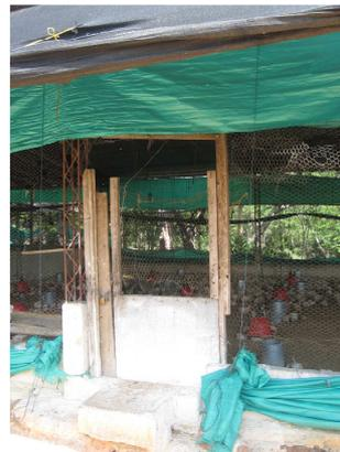
5. Los techos del galpón No. 2 se encuentran en mal estado las láminas de zinc, debido al deterioro le han colocado palos de madera para evitar que haya un riesgo de desplome. Las vigas que sostienen el techo de los galpones no son adecuadas, estas son en madera, se encuentran agrietadas, vencidas y partidas, ocasionando un riesgo locativo (desplome) y mecánico (golpe por caídas de objetos).
