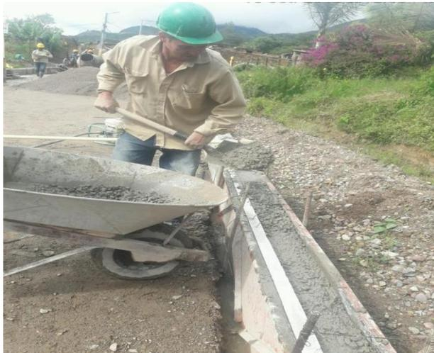
*Imagen 14 Instalación del Concreto de 3000 PSI*
