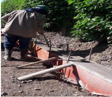
*Imagen 15 Vibrado del Concreto*
