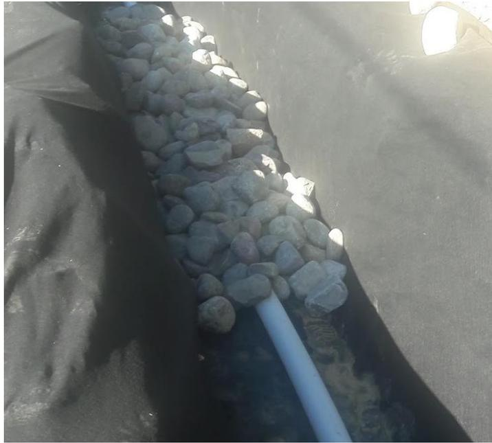
*Imagen 49 Instalación de material granulado*
