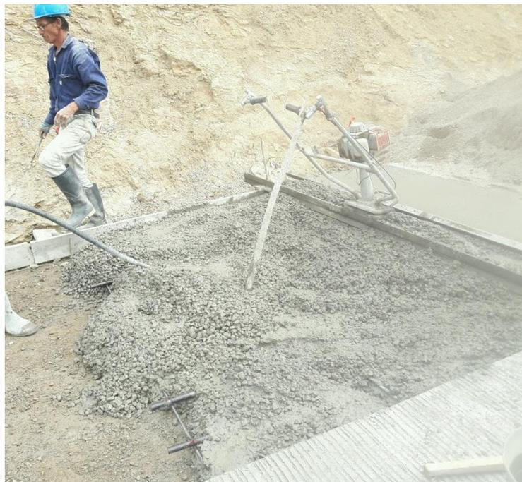
*Imagen 52 Vaciado de Concreto e Instalación de Acero de Transferencia*
