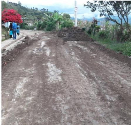
*Imagen 51 Excavación de la Subrasante*
