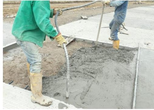
*Imagen 18 Vibrado del Concreto*
