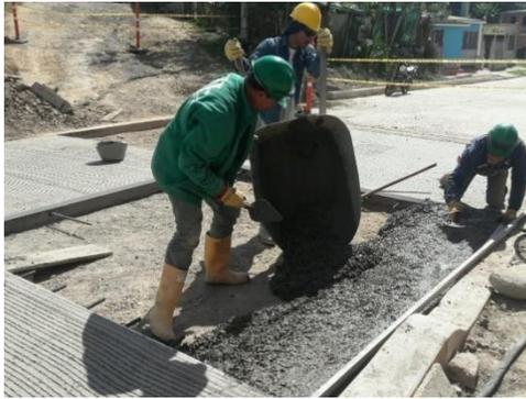
*Imagen 17 Vaciado del Concreto*
