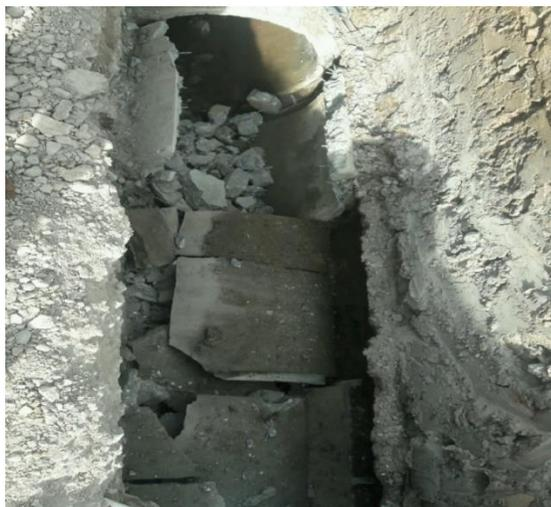
*Imagen 43 Demolición de Tubo en Concreto*
