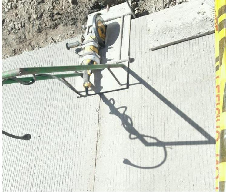
*Imagen 55 Corte de Juntas de Transferencia*
