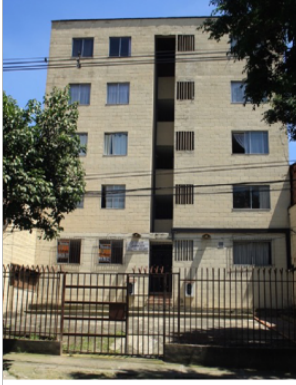
Figura 7. Edificio, presencia de vanos estandarizados. Barrio San Javier, Medellín (2017).
