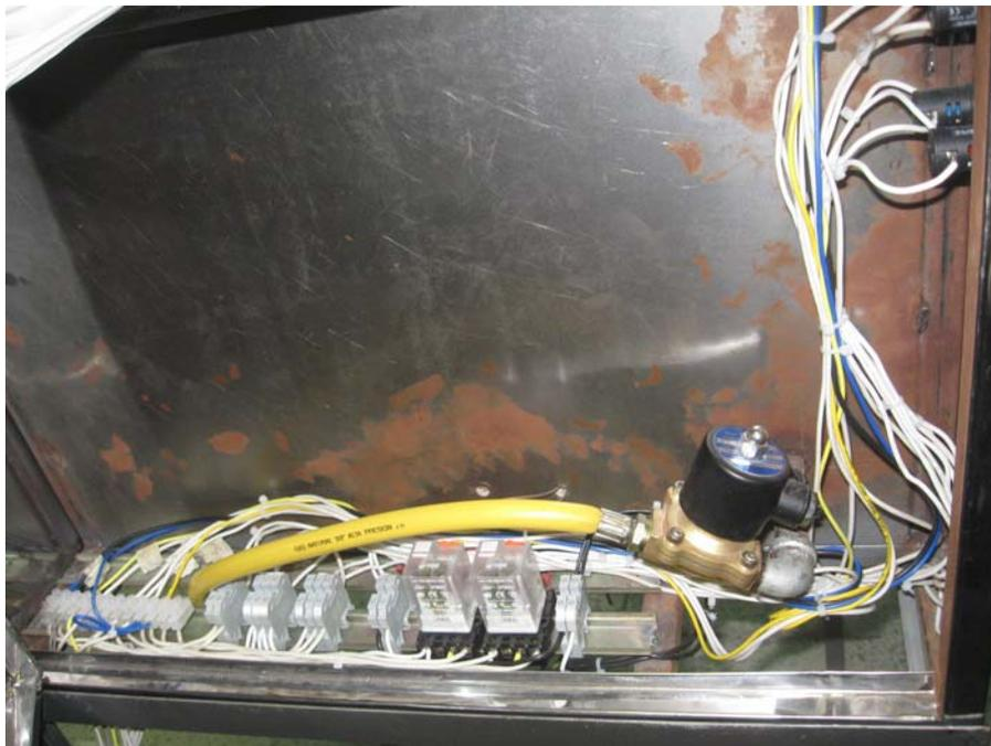
Figura 34. Conexiones internas de los elementos de control.
