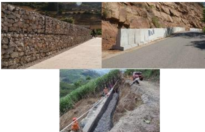
Imagen 6. Obras de protección en vías en las que interviene CDGRD.
