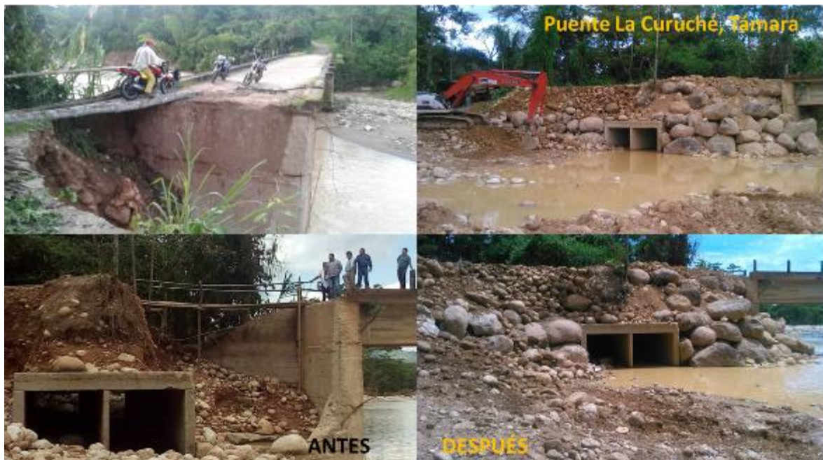
Imagen 8. Obras de protección a puentes en las que interviene CDGRD
