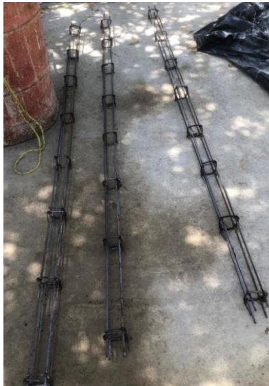
Imagen 1 Acero de refuerzo para postes de Concreto.
