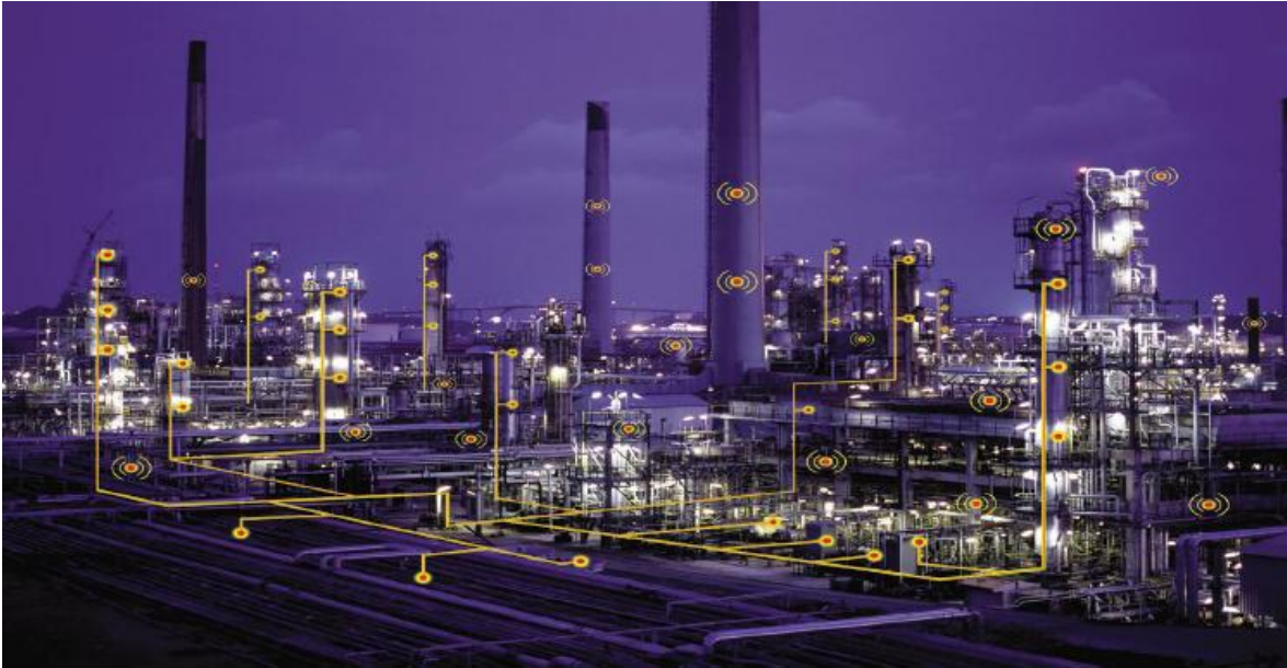
Figura 13. Diagrama de ubicación de señores y demás elementos de acuerdo a estructura funcional para el diseño de una planta de red inalámbrica (WPN)
