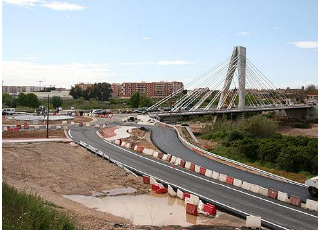
Figura 20 Puente vehicular en Madrid,
