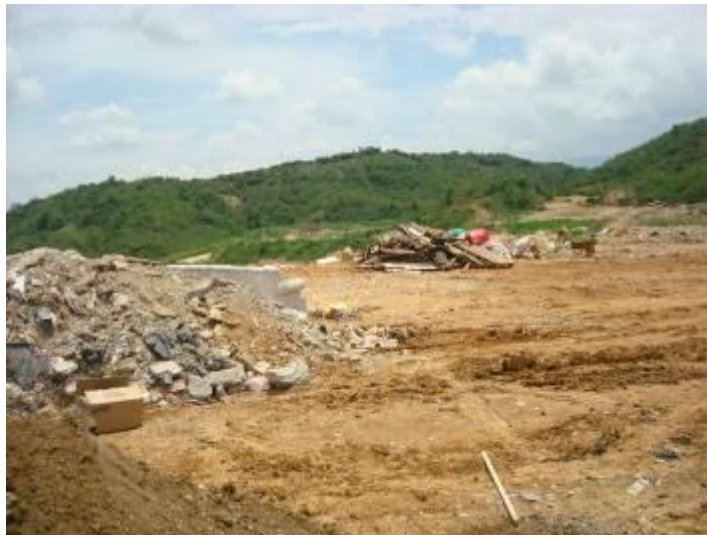
Figura 10. Terreno nivelado con maquinaria
