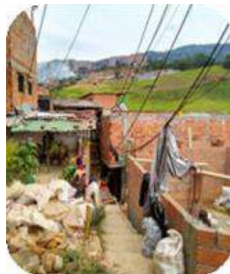
Fotografía 22 – Escombros Elaboración propia.
