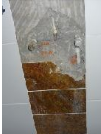
Fig. 21 Demolición de cenefa de mármol
