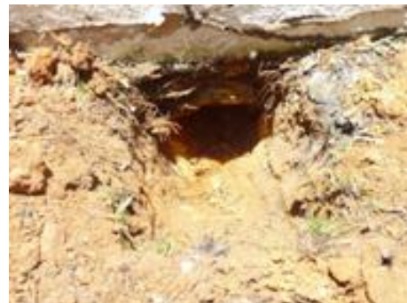
Fig. 82 Apique en casa Cra 40 # 48-58
