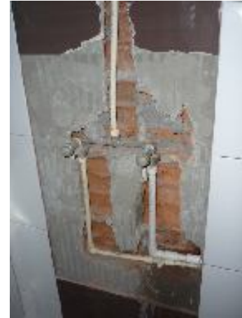
Fig. 22 Demolición de cenefa de cerámica
