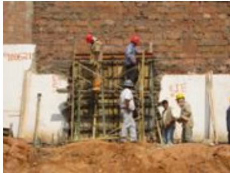
Fig. 118 Armada de muros
