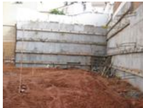
Fig. 134 Vista panorámica pantallas ancladas
