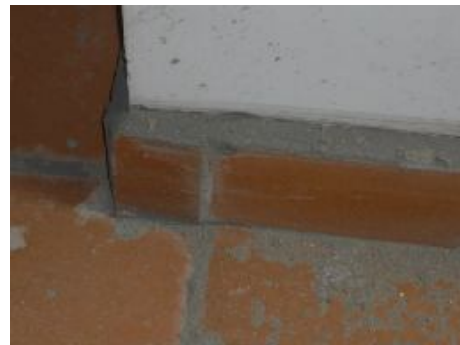
Fig. 6. Guarda escoba torcido
