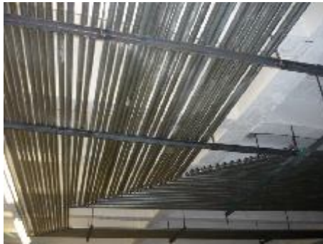
Fig. 26 Red de gas de distribución
