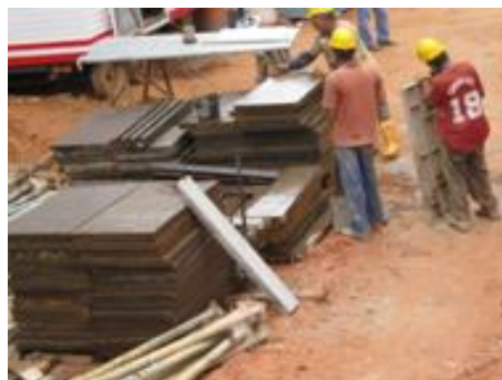
Fig. 130 Limpieza de formaleta
