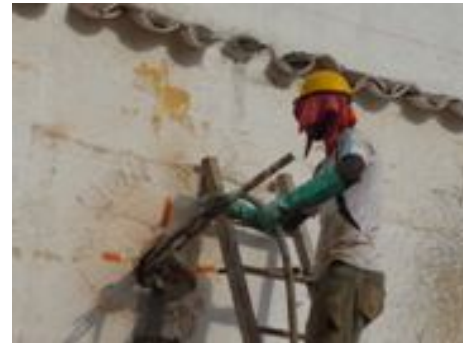
Fig. 112 Inyección de anclajes
