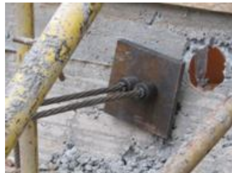
Fig. 125 Sistema completo para tensionar
