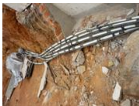
Fig. 107 Torones de anclaje
