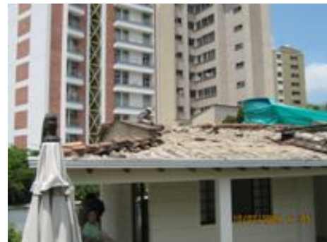
Fig. 73 Inicio de obra
