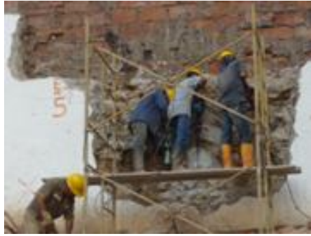
Fig. 115 Demolición de muro de cerramiento Fig. 116 Revisión de hierros en muro armado
