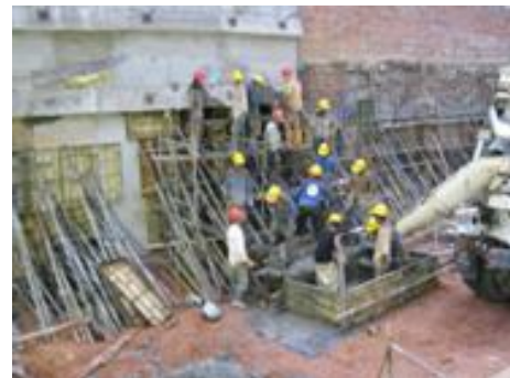
Fig. 121 Fundida de muro
