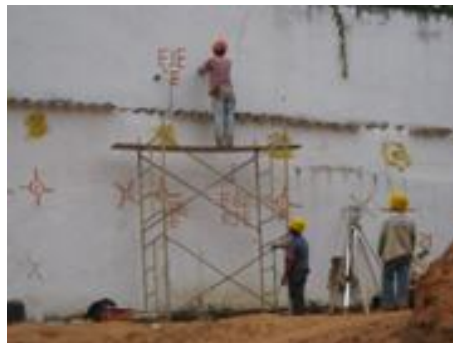
Fig. 101 Ubicación de anclajes
