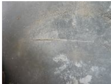
Fig. 47 Corte de disco en alfajía
