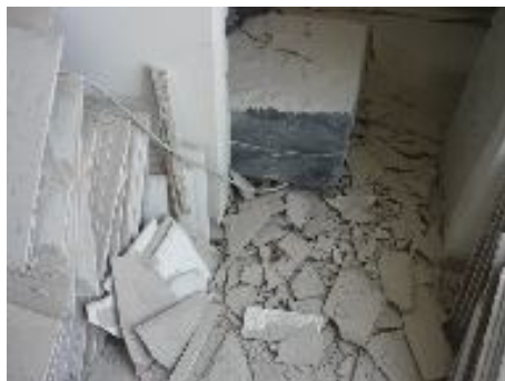
Fig. 15 Demolición de baños
