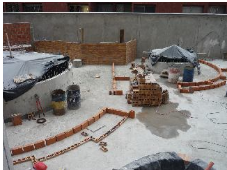
Fig. 31 Replanteo de jardineras e inicio de obra
