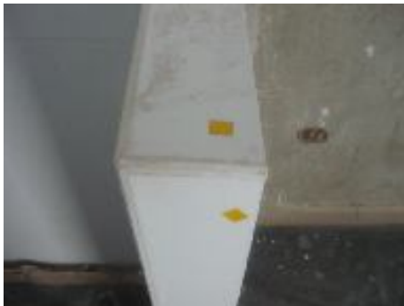
Fig. 18 Muro descuadrado
