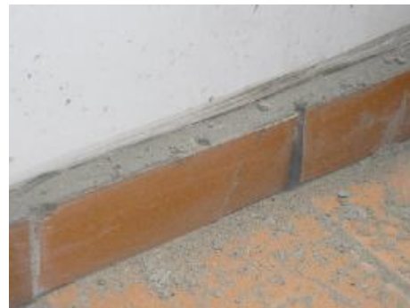
Fig. 4. Guarda escoba Roto
