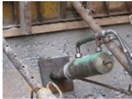
Fig. 127 Pistón de tensionamiento
