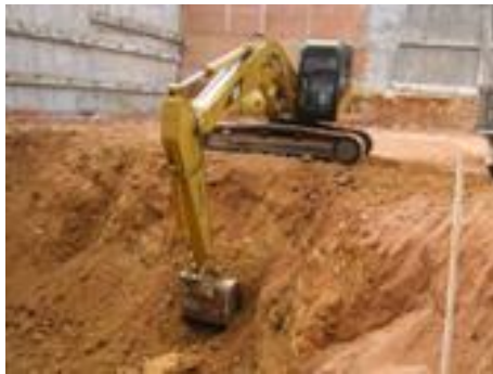
Fig. 131 Excavación 3 de terreno
