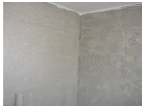
Fig. 16 Demolición de Baños
