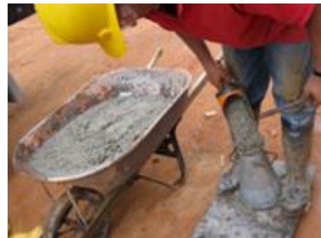
Fig. 87 Llenada 2da capa concreto
