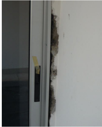
Fig. 32 Instalación incorrecta
