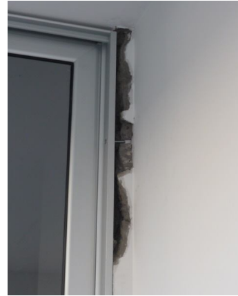
Fig. 33 Instalación incorrecta
