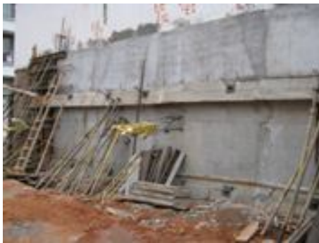
Fig. 128 Desencofrado de muros
