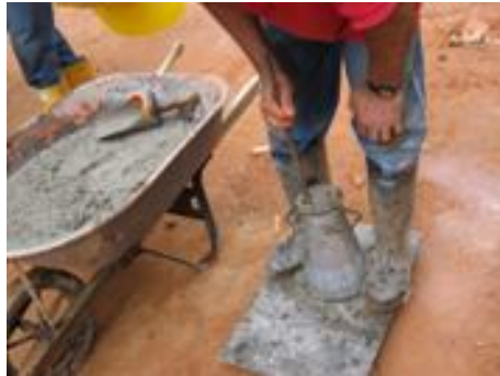
Fig. 88 Último nivel de concreto
