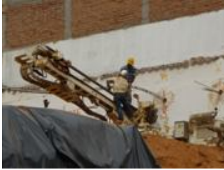
Fig. 108 Instalación de Torones
