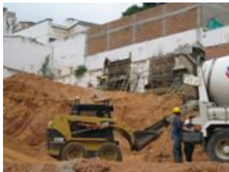
Fig. 120 Transporte de concreto
