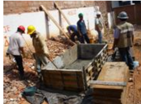
Fig. 119 Cajón de concreto
