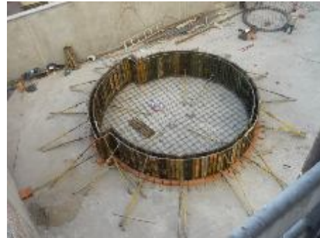
Fig. 30 Formaleta terminada de piscina
