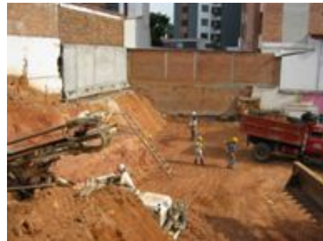
Fig. 132 Vista de perfil terreno nivel 2
