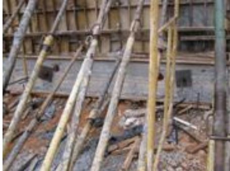
Fig. 122 Viga libre para tensionar
