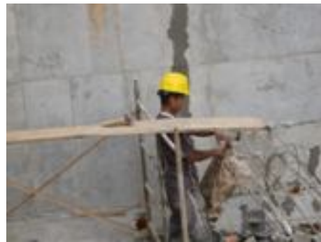
Fig. 129 Resane y detalle de muros
