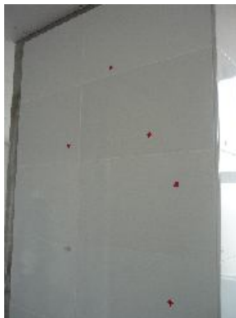
Fig. 12 Identificación de losas
