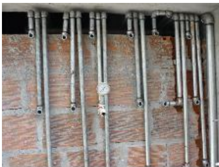
Fig. 27 Ensayo de hermeticidad
