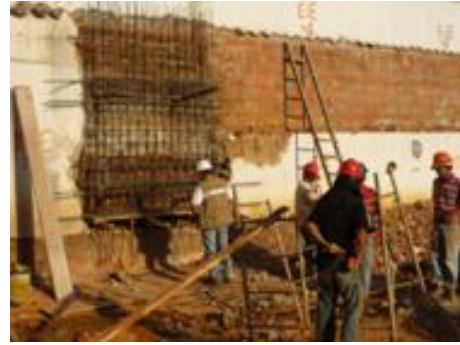
Fig. 115 Demolición de muro de cerramiento Fig. 116 Revisión de hierros en muro armado
