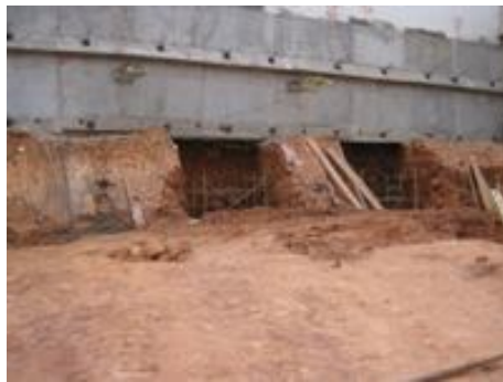
Fig. 133 Excavación por trincheras
