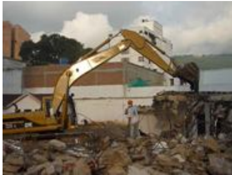
Fig. 83 Inicio de demolición de la casa
