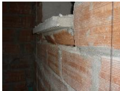
Fig. 43 Ladrillo descuadrado
