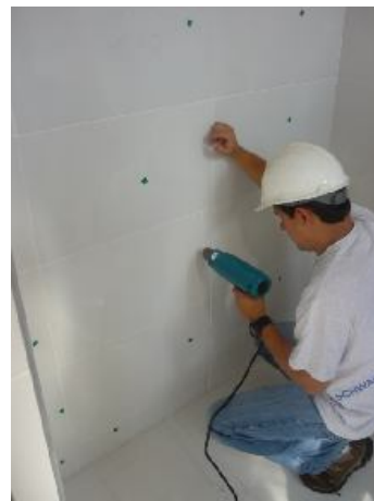
Fig. 14 Secado de muros
