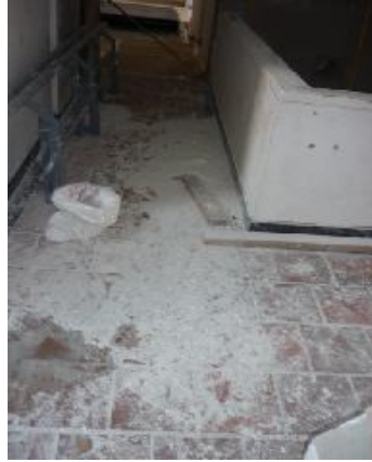
Fig. 49 Desaseo Torre A
