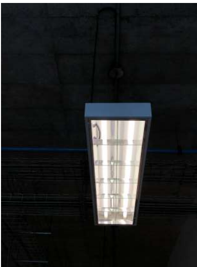
Figura 16: Sistema de iluminación. Fuente Autor.
