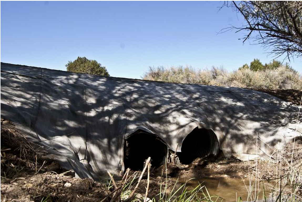
Fotografía 16. Revestimiento en alcantarillas con Manto de Hormigón
