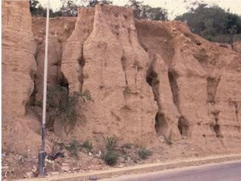
Fotografía 5. Erosión Interna
