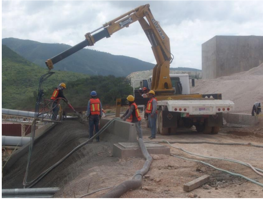
Fotografía 12. Concreto Lanzado en Talud
