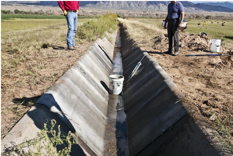
Fotografía 14. Revestimiento de Zanjias y Canales con Manto de Hormigón
