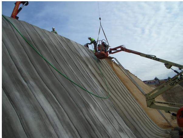
Fotografía 9. Protección de taludes con rollo de manta de hormigón.
