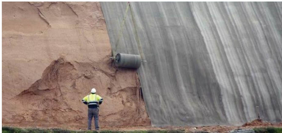
Fotografía 10. Protección de taludes con rollo de manta de hormigón
