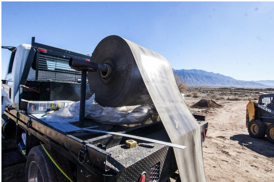
Fotografía 8. Rollo de manta de Hormigón
