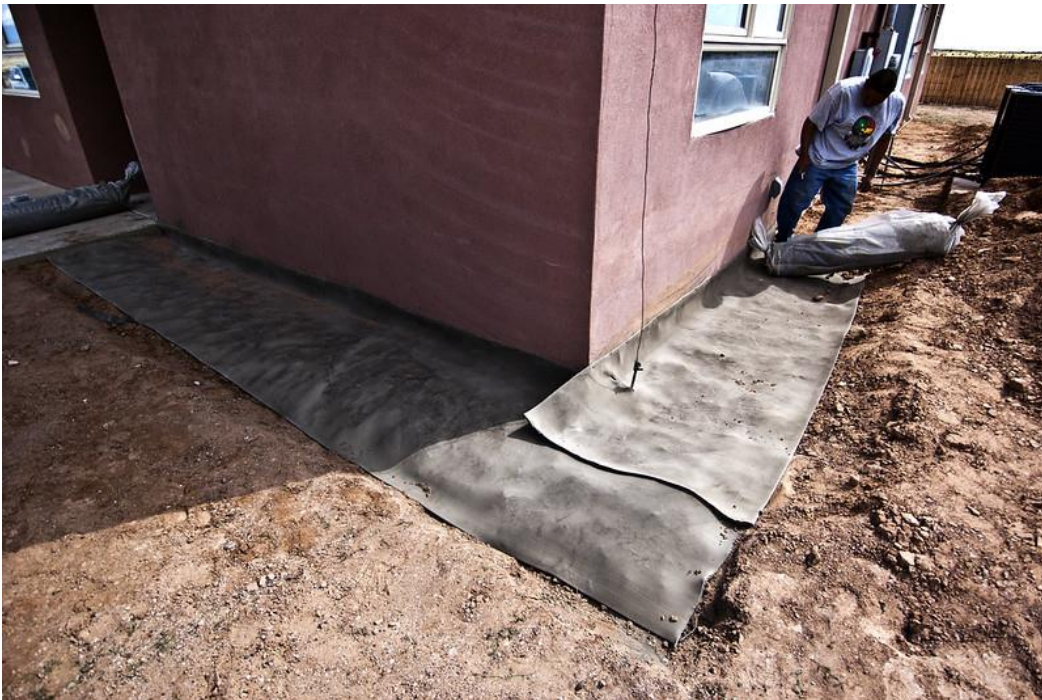
Fotografía 15. Revestimiento de Casa para su Protección
