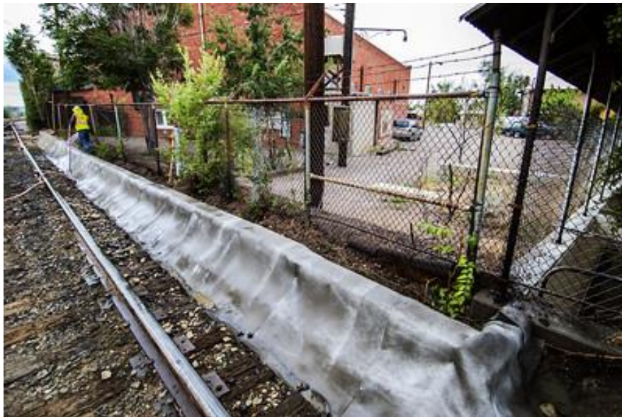
Fotografía 17. Supresión de la Maleza empleando el Manto de Hormigón
