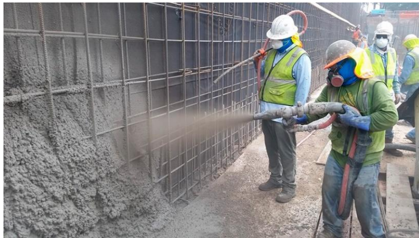
Fotografía 11. Concreto Lanzado Vía Húmeda
