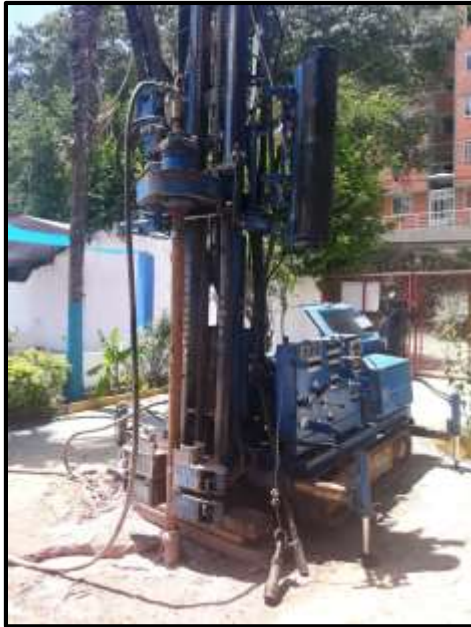
Fotografía 11. Sondeo 1 - Puerto Madero
