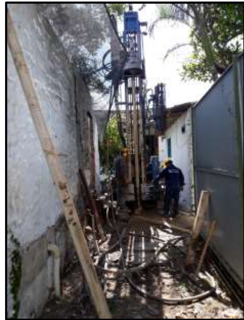
Fotografía 10. Sondeo 2 - Puerto Madero
