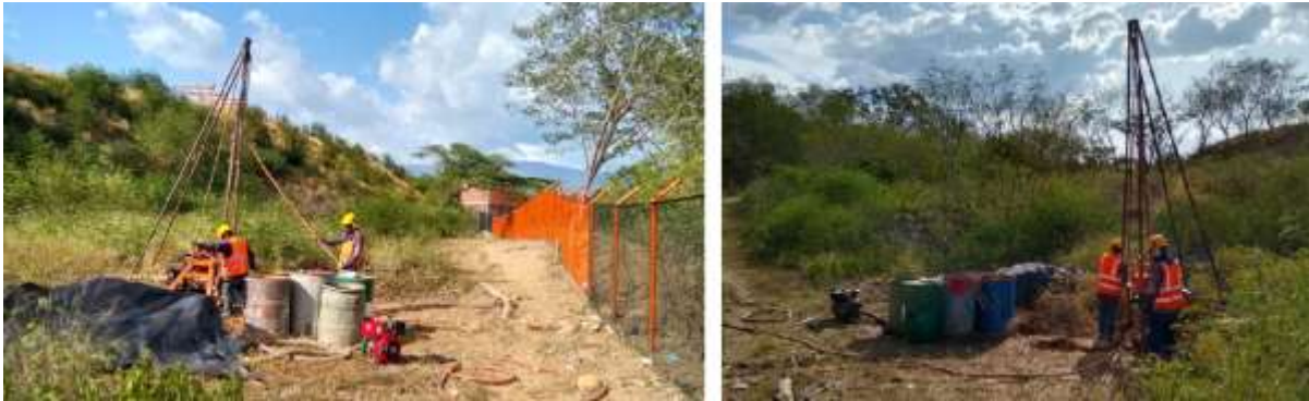
Fotografía 14. Sondeo 1 - Aeropuerto Cúcuta
