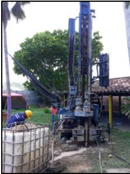
Fotografía 12. Sondeo 3 - Puerto Madero
