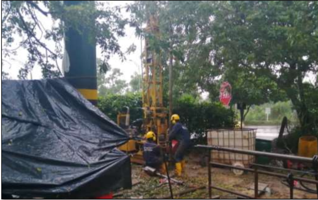
Fotografía 5. Sondeo 3 - Valla Santo Tomás
