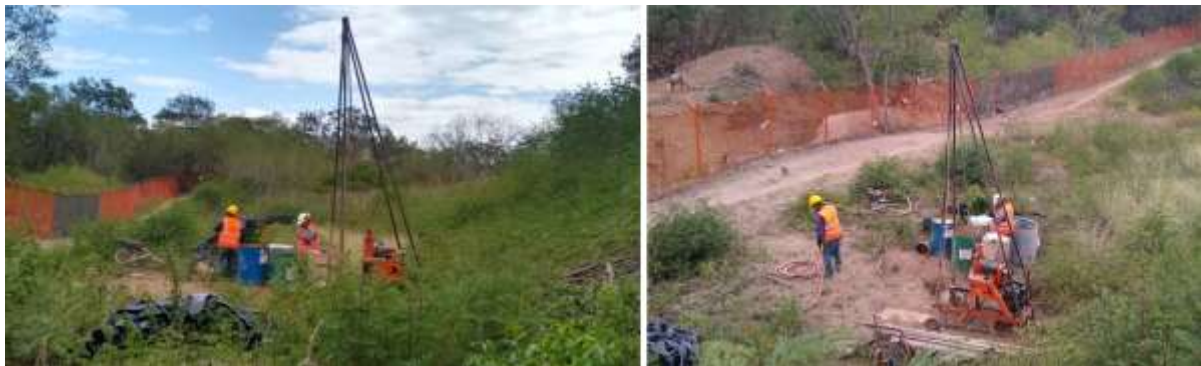
Fotografía 15. Sondeo 2 - Aeropuerto Cúcuta
