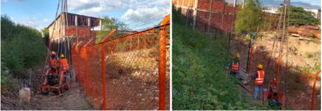
Fotografía 17. Sondeo 4 - Aeropuerto Cúcuta
