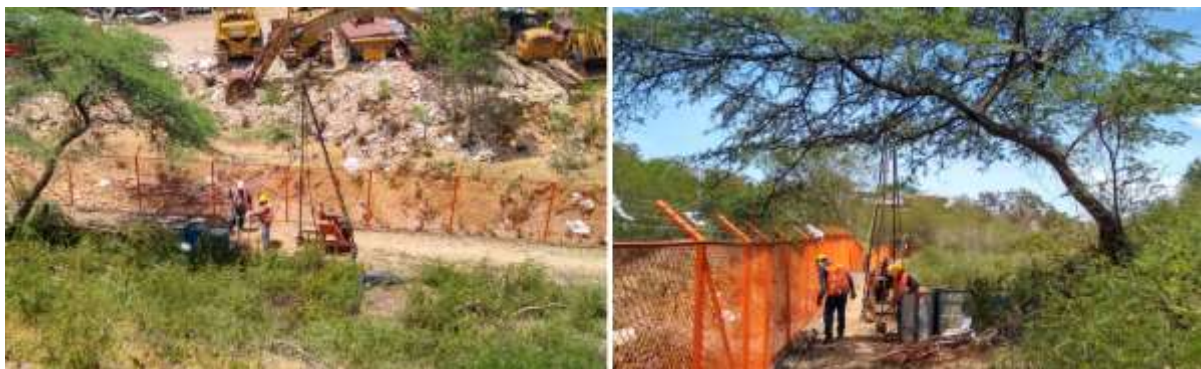
Fotografía 16. Sondeo 3 - Aeropuerto Cúcuta
