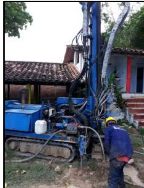
Fotografía 13. Sondeo 4 - Puerto Madero
