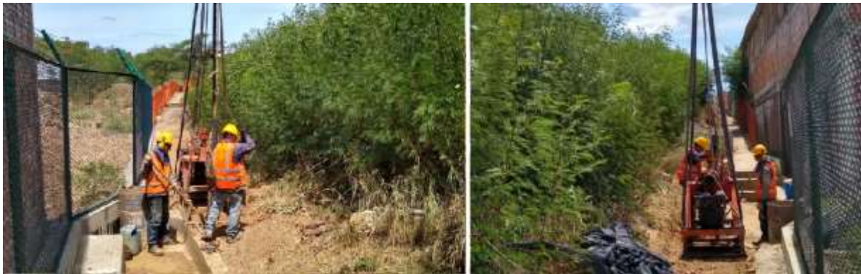
Fotografía 18. Sondeo 5 - Aeropuerto Cúcuta
