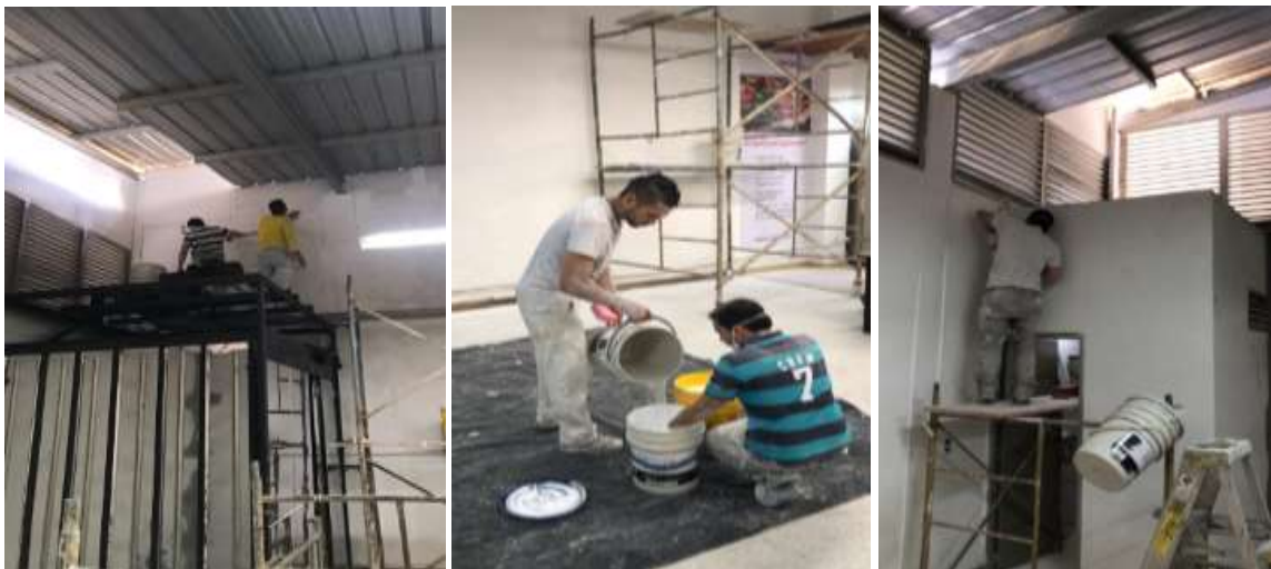
Imagen 16. Trabajos segundo piso Pintura Frío y calor
