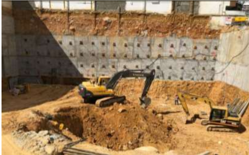
Imagen 44. Pantalla activa con anclajes
