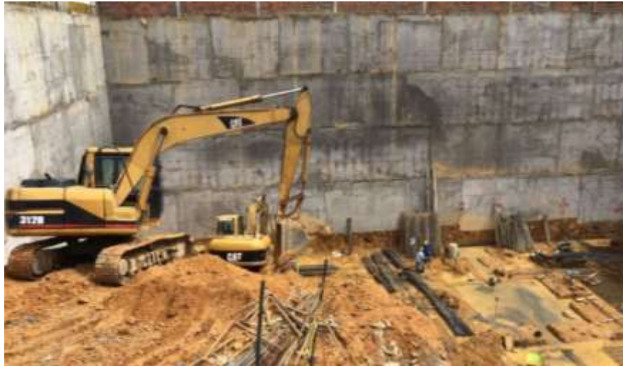
Imagen 40. Pantalla pasiva con pernos
