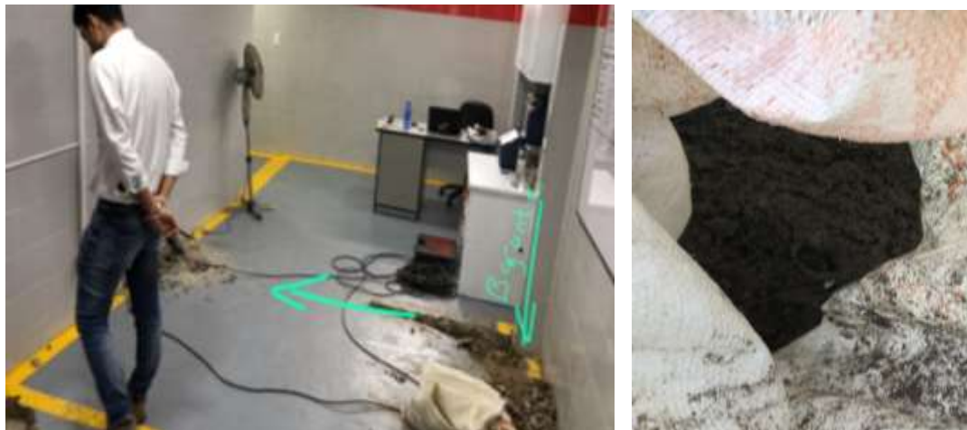
Imagen 21. Destape de bajantes Honda
