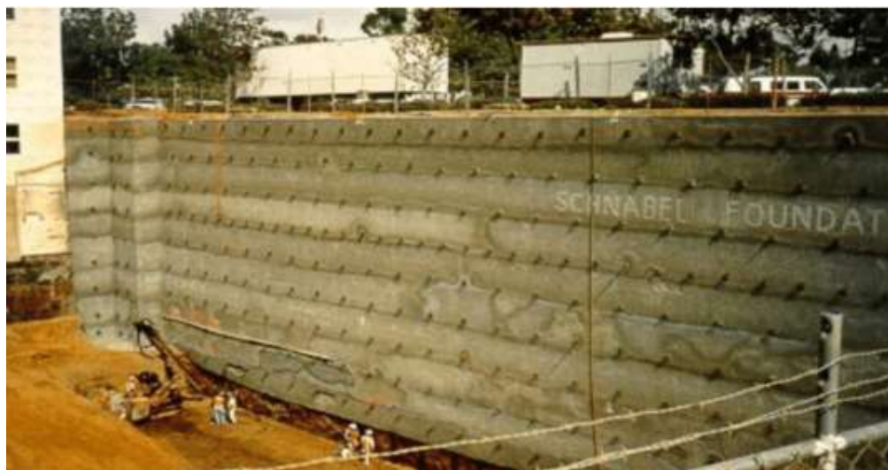
Imagen 47. Pantallas activas con pernos y concreto lanzado
