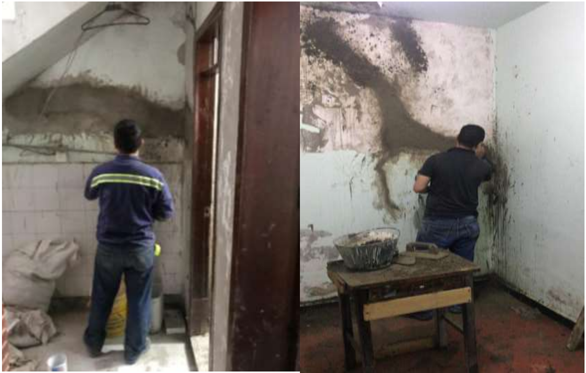
Imagen 28. Arreglo de grietas casa tapetes
