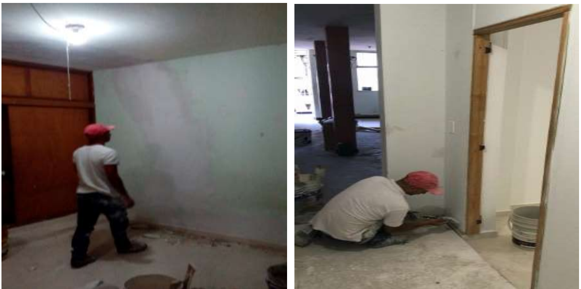
Imagen 32. Pintura paredes y losa
