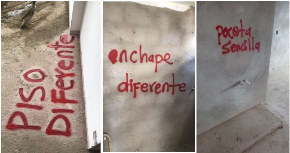
Imagen 37. Señalización en obra de cambios de apartamentos
