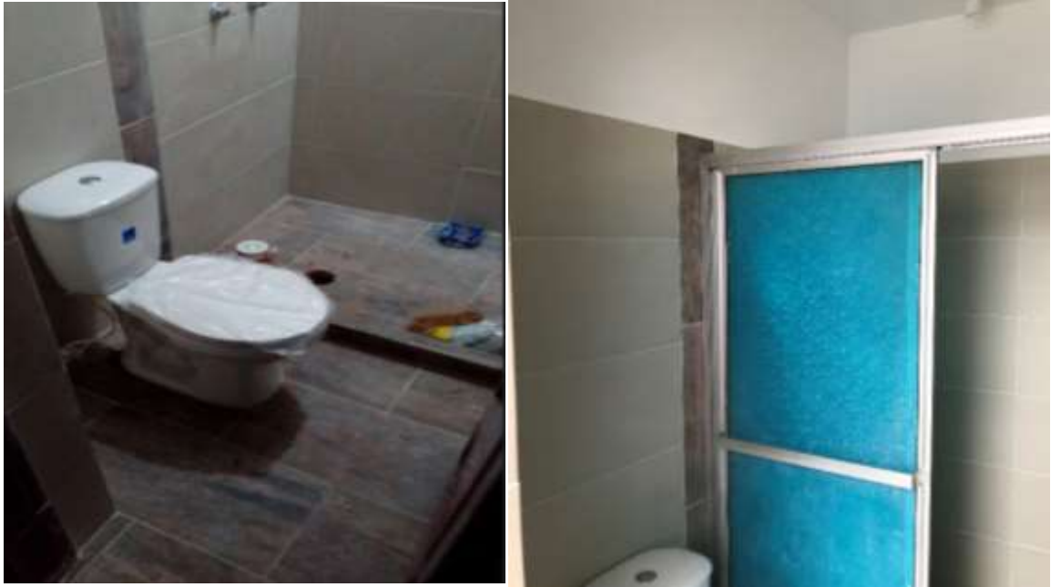
Imagen 33. Instalación de sanitario y división de baño
