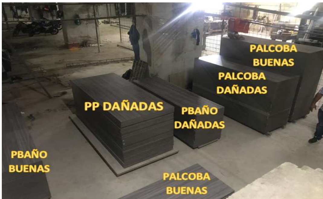
Imagen 48. Separación puertas dañadas y útiles
