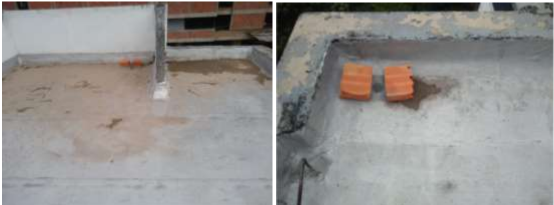
Imagen 24. Resultados trabajos Torres de Vallarta
