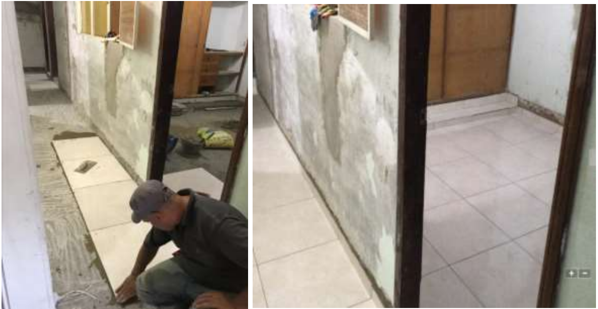
Imagen 31. Enchape nuevo del piso
