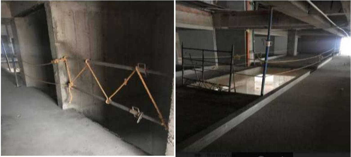
Imagen 4. Lazos de seguridad en la obra
