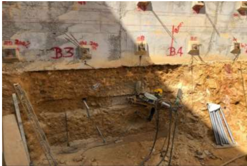
Imagen 45. Diferenciación pantallas activas con anclajes
