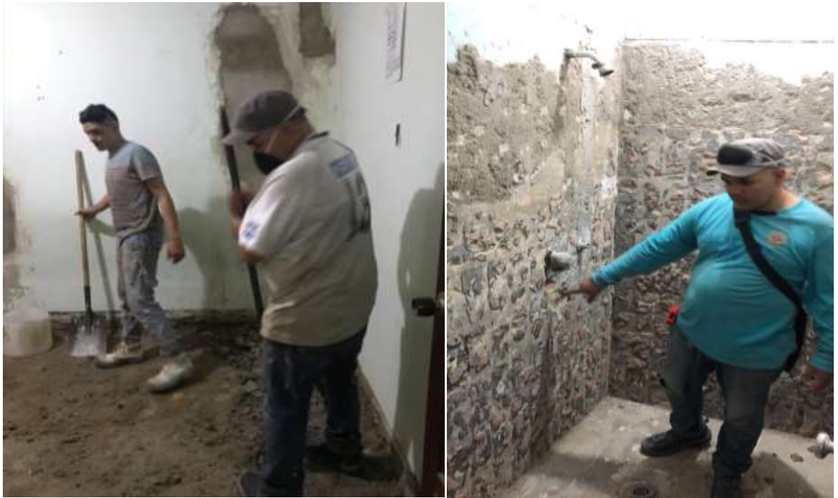
Imagen 29. Demolición de enchape
