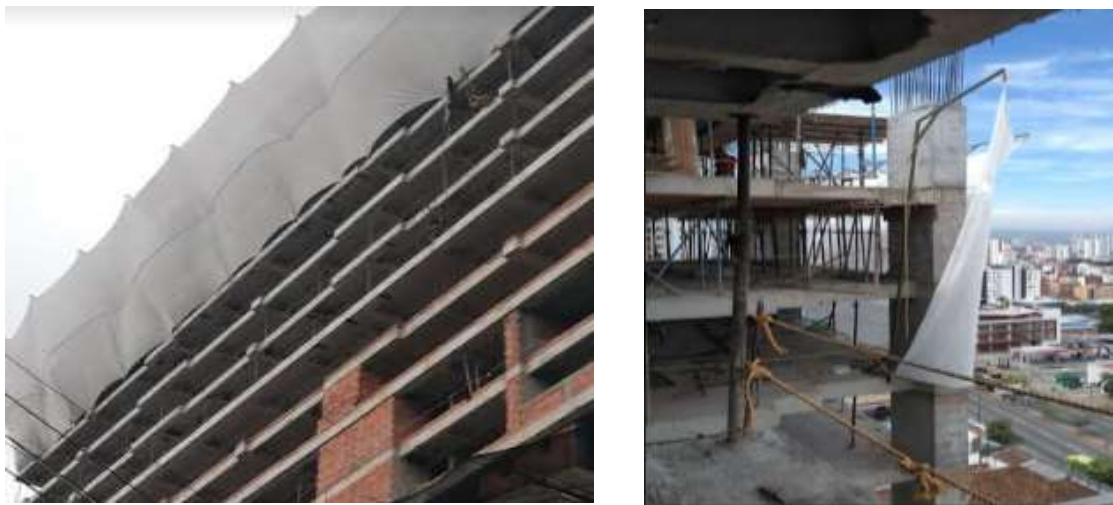
Imagen 5. Malla de protección anticaídas
