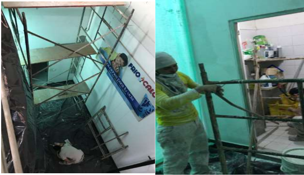
Imagen 17. Trabajos Ascensor de carga Frio y calor
