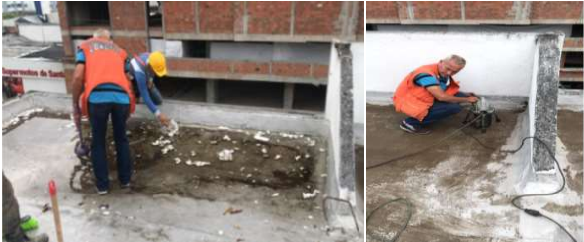
Imagen 23. Destape con gualla eléctrica Torres de vallarta
