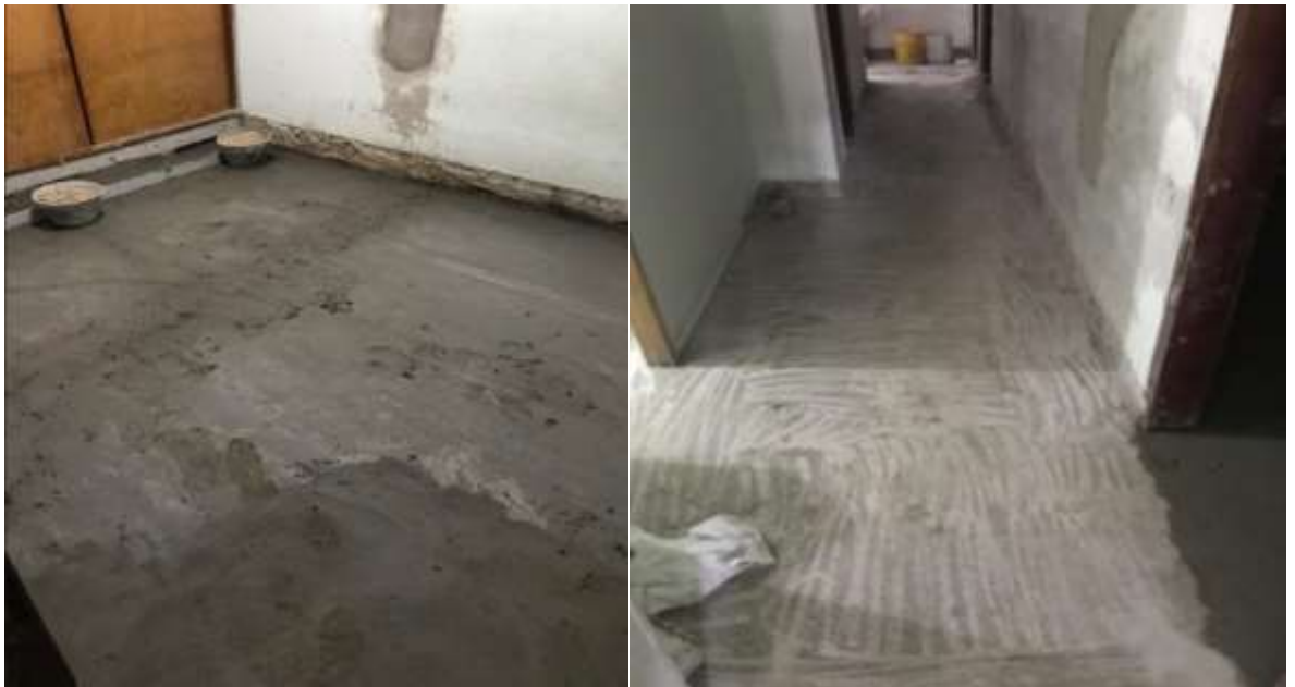
Imagen 30. mortero de piso
