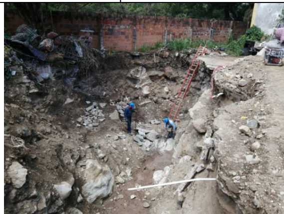
Fotografía 4. Retiro de bolos de roca sector PCH Zaragoza Fuente: Propia – amb S.A. E.S.P.
