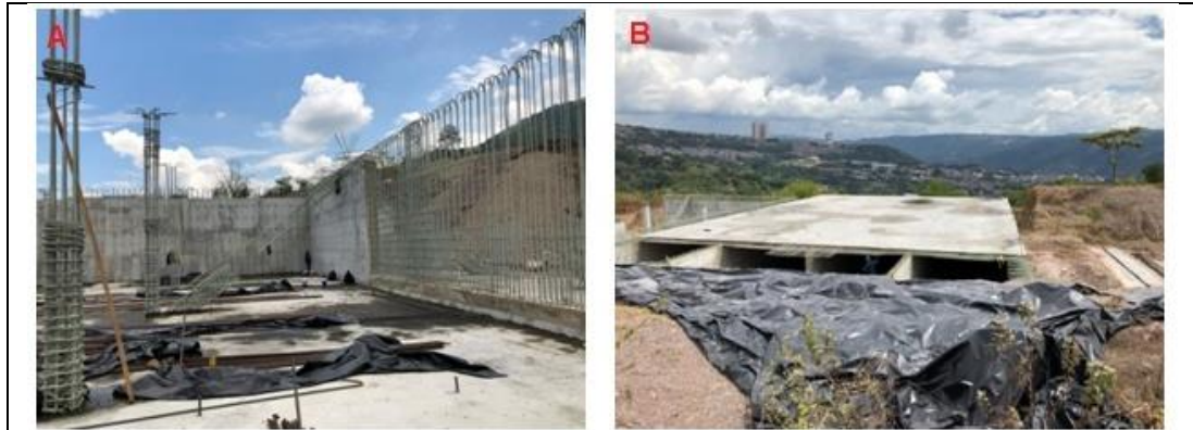
Fotografía 11. Trabajo de protección de estructuras
