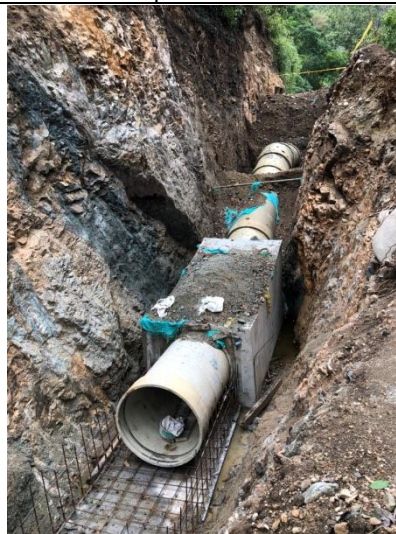
Fotografía 9. Anclajes en concreto Fuente: Propia – amb S.A. E.S.P.
