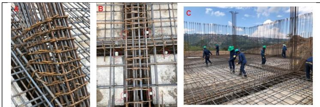
Fotografía 12. Procedimiento de armado del acero para placas y columnas
