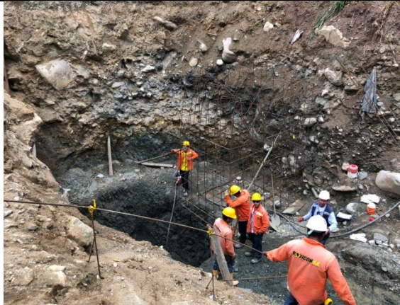
Fotografía 8. Refuerzo de acero para anclajes en concreto Fuente: Propia – amb S.A. E.S.P.
