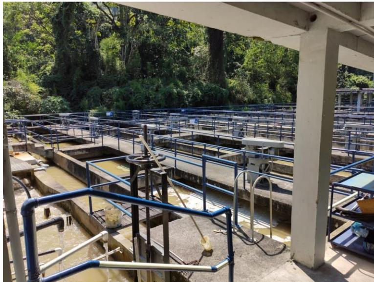
*Figura 4 Mezcla Rápida y Floculadores*
