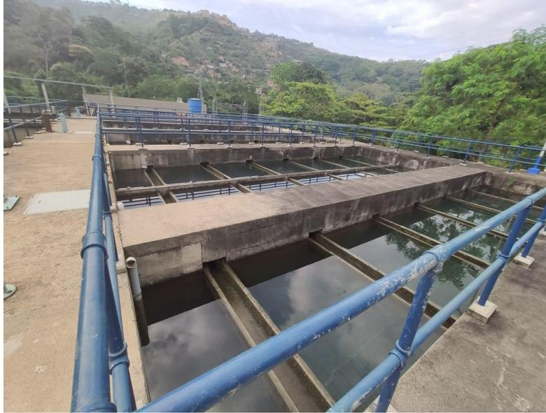
*Figura 5 Sedimentador 4*
