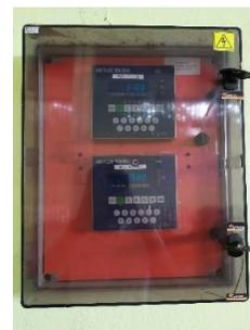
*Ilustración 8. Báscula electrónica de contenedores de cloro actualmente.*
