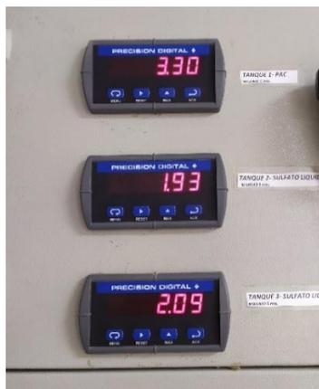
Ilustración 11. Panel de control nivel de coagulante.
