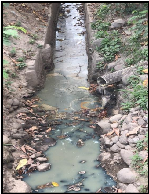
Foto 7. Canal aguas lluvias antes.
