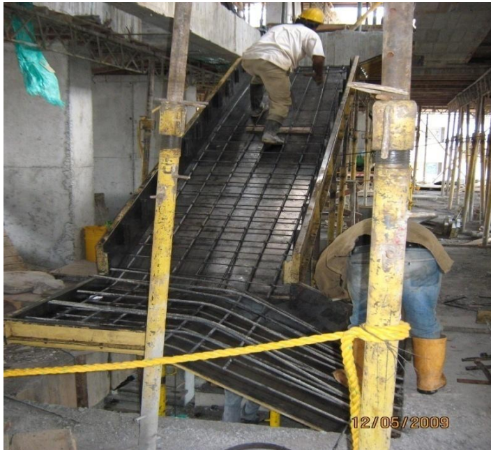
Foto 34. Encofrado y proceso armado del acero escaleras.
