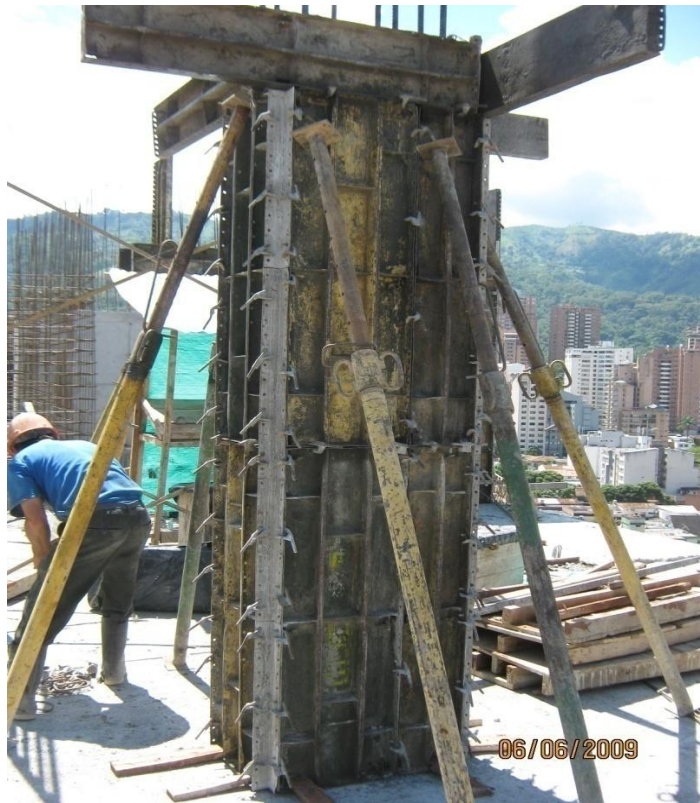
Foto 8. Apuntalamiento en columnas y aplomado
