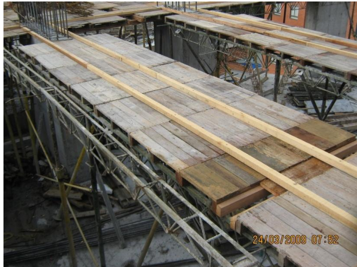
Foto 20. Entablero de las vigas.
