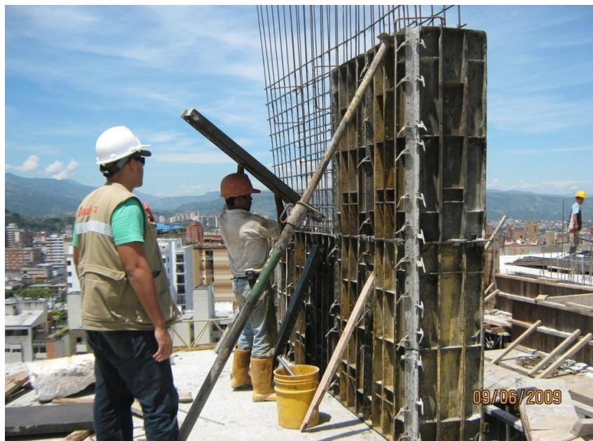
Foto No 6. Encofrado metálico para pantallas y columnas.
