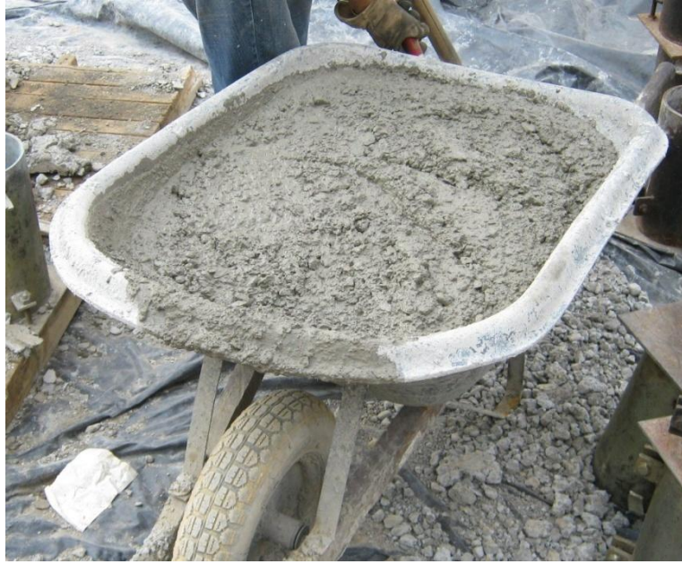
Foto 42. Carreta con muestra de concreto fresco.
