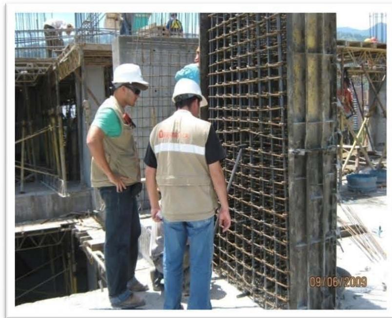
Foto No. Revisando varillas, traslapos, armado y amarre del acero
