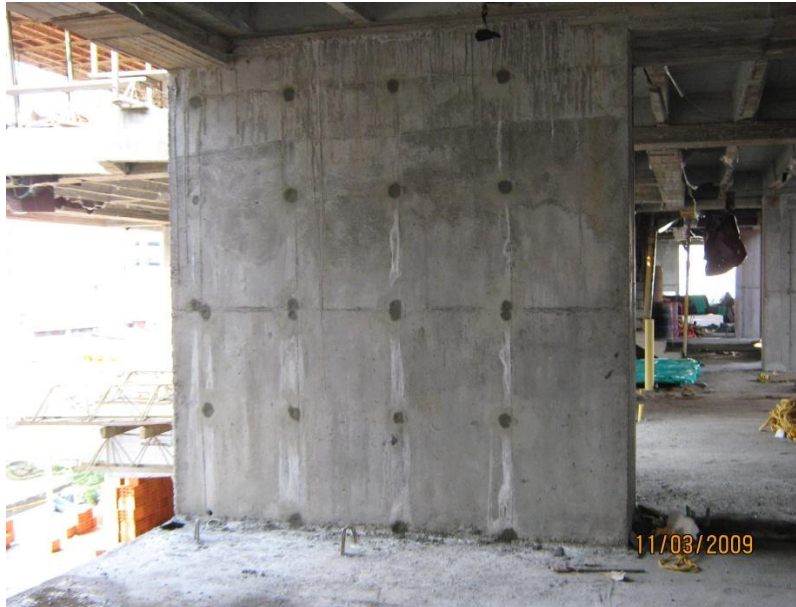
Foto No 10. Tapado de los huecos de las corbatas o tensores.
