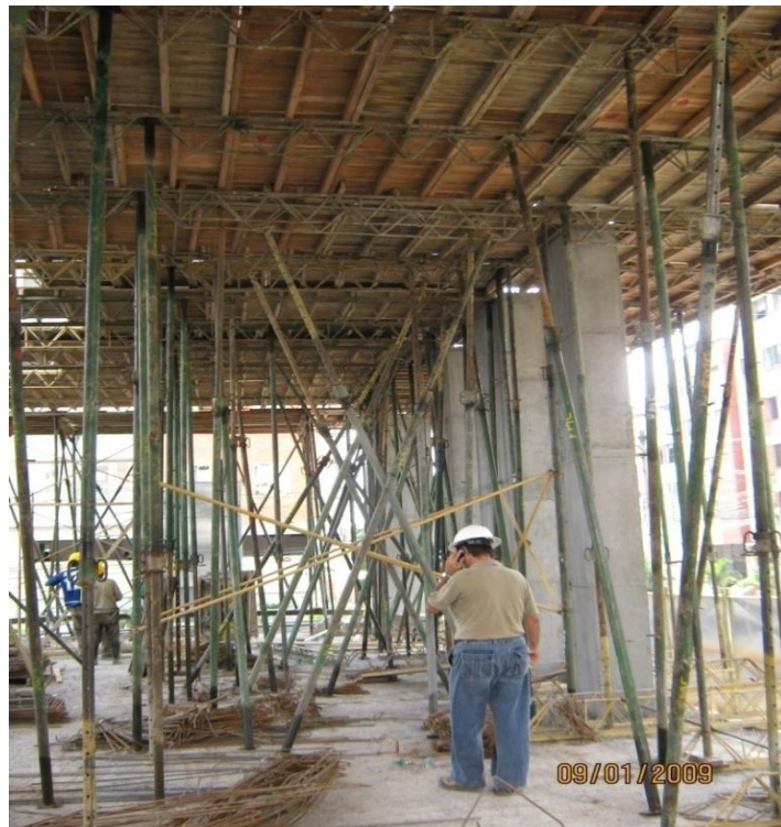
Foto 21. Arriostamiento y entablero de la placa aligerada.
