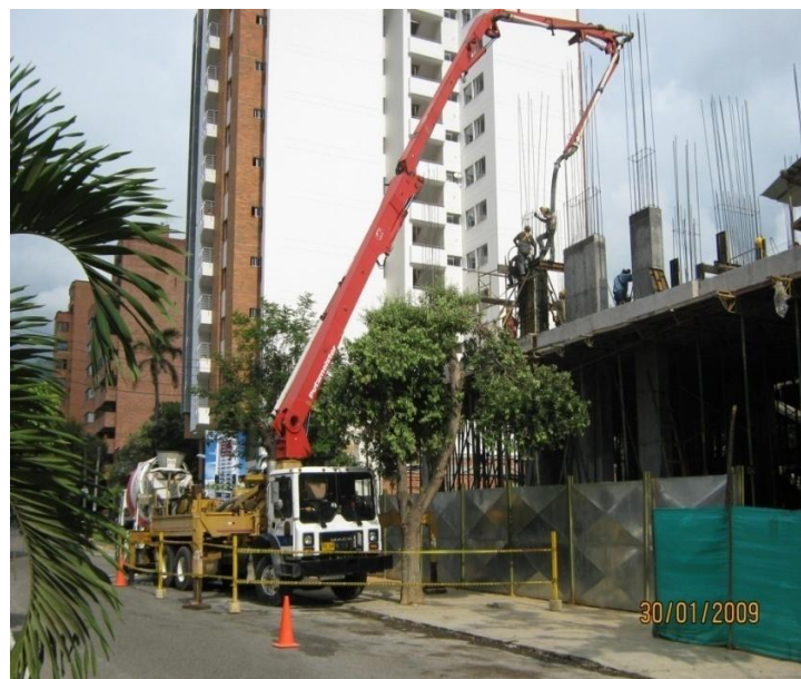
Foto 9. Vaciado del concreto con autobomba en columnas.
