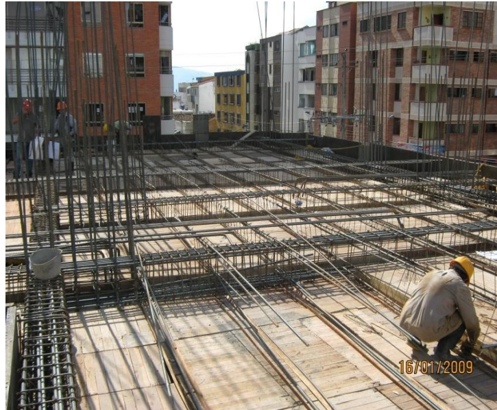
Fotos 24. Armado de acero para viguetas.
