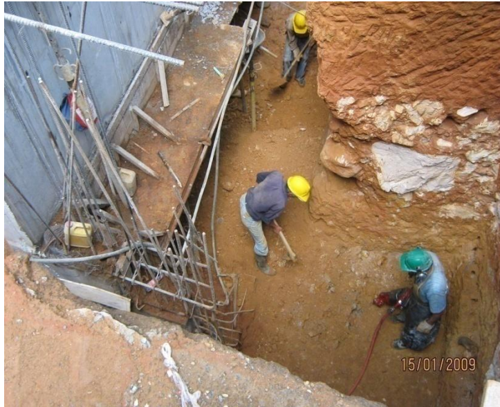
Foto 1. Excavación a mano y compresor con martillo, zapata H24.
