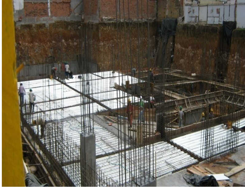
Foto 16. Vista aérea de la placa steel deck lista para fundir.
