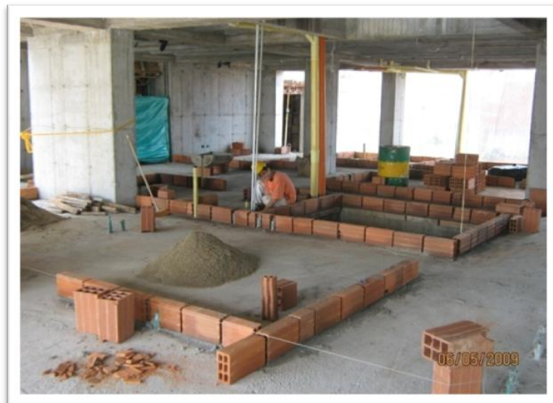
Foto 47. Replanteo y medidas para mampostería interior.
