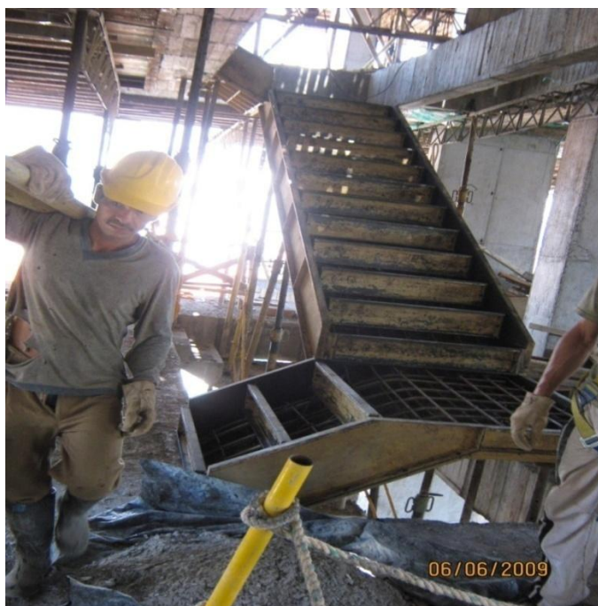
Foto 35. Escalera lista para el vaciado del concreto.
