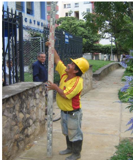
Foto 45. Extendido de la mira para comprobar la estabilidad y verticalidad.
