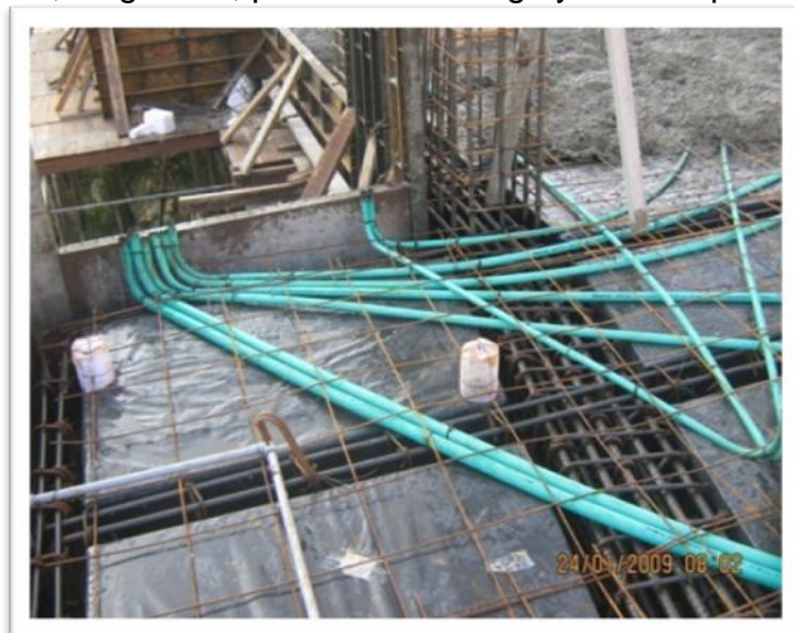
Foto 28. Instalación eléctrica en placa.
