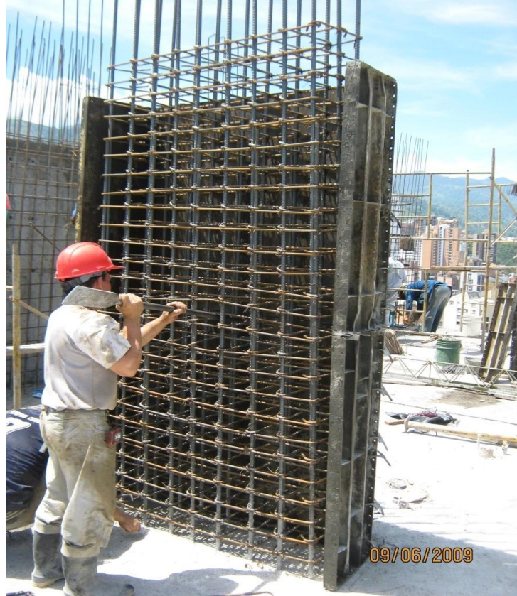
Foto 5. Armado y amarrado del acero para columnas.
