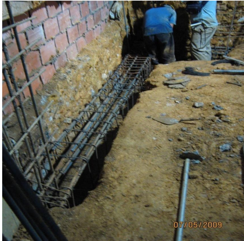
Foto 2. Excavación y armado del acero de la viga de amarre. Sótano -3.
