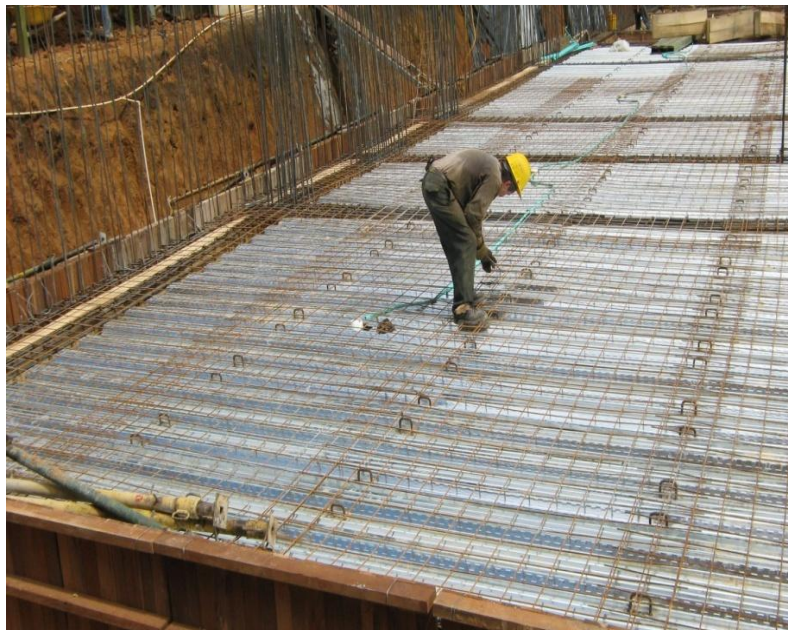
Foto 15. Instalación de conectores, malla electro-soldada, instalaciones eléctricas, negativos y separadores.
