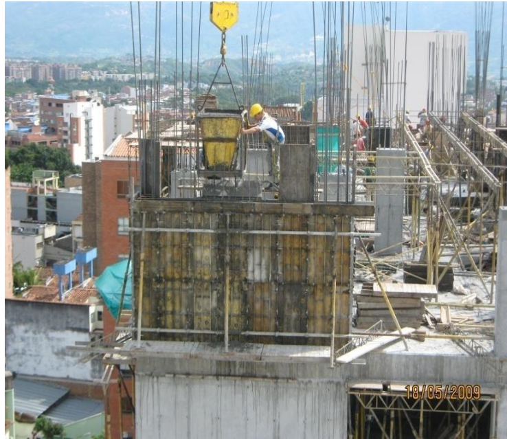
Foto 10. Vaciado del concreto con torregrua y góndola.
