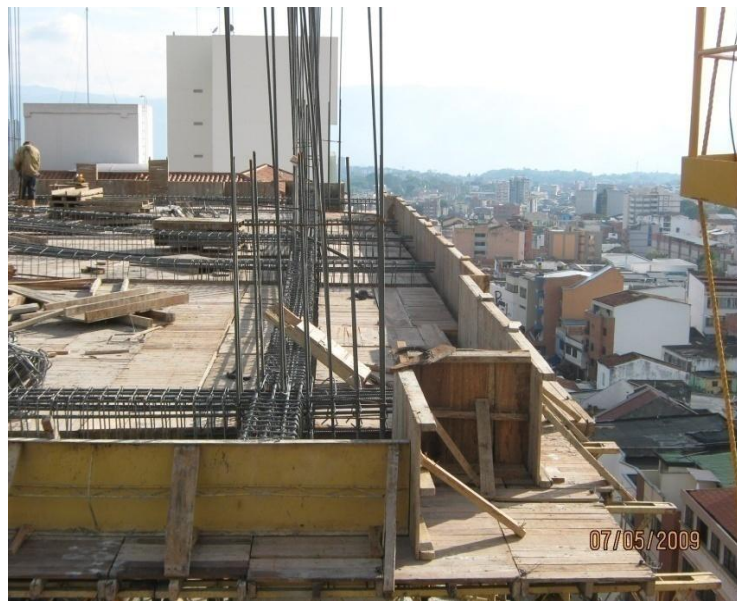
Foto No.23. Embandado de placa.
