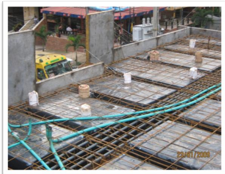
Foto No. 27. Pases para la tubería sanitaria.
