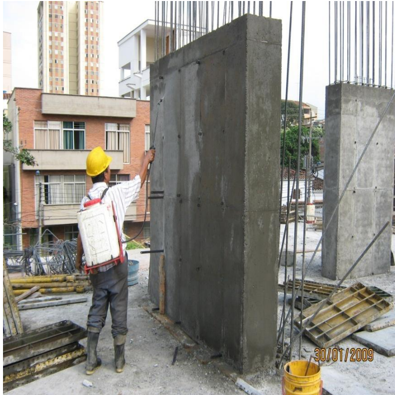
Foto 12. Curado de las columnas con fumigadora y curasil o antisol.
