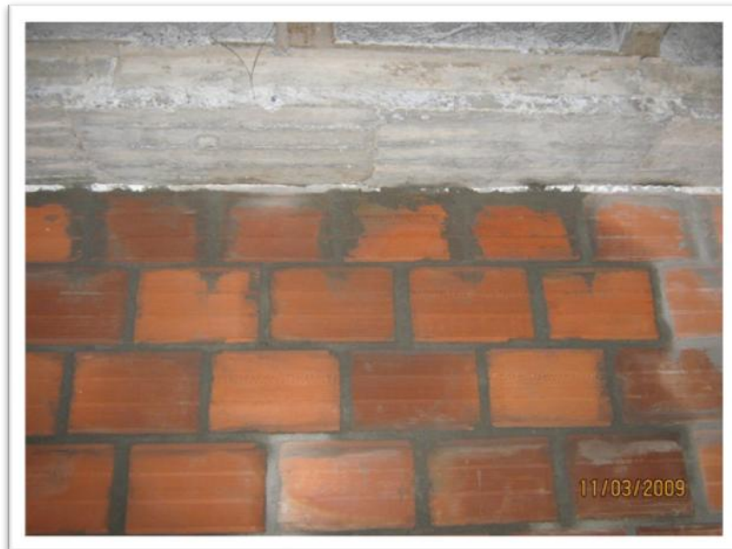
Foto 49. Alineamiento y calidad de la brecha.
