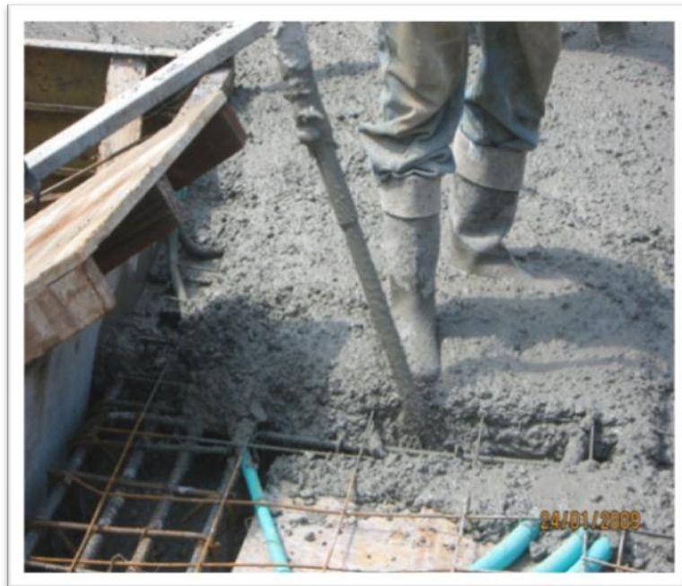
Foto No.32. Vibrado del concreto en placa.
