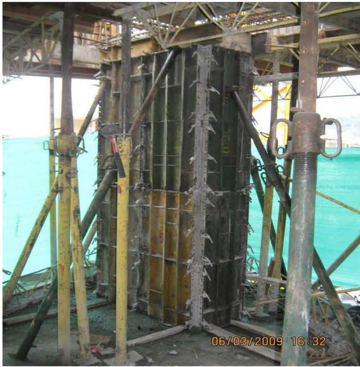
Foto No. Fundidas una semana después de demolidas las columnas.
