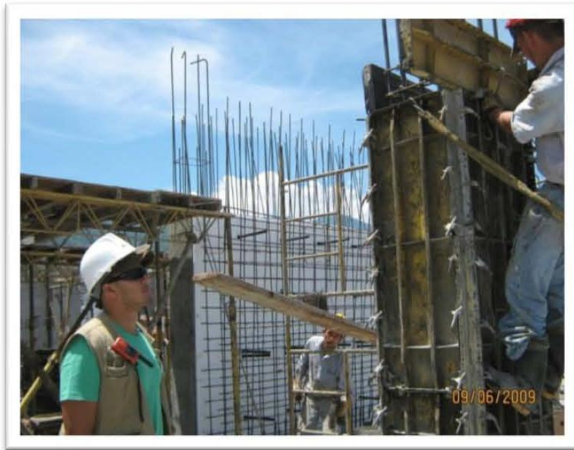
Foto No. Revisando grapas, tensores y encofrado general.
