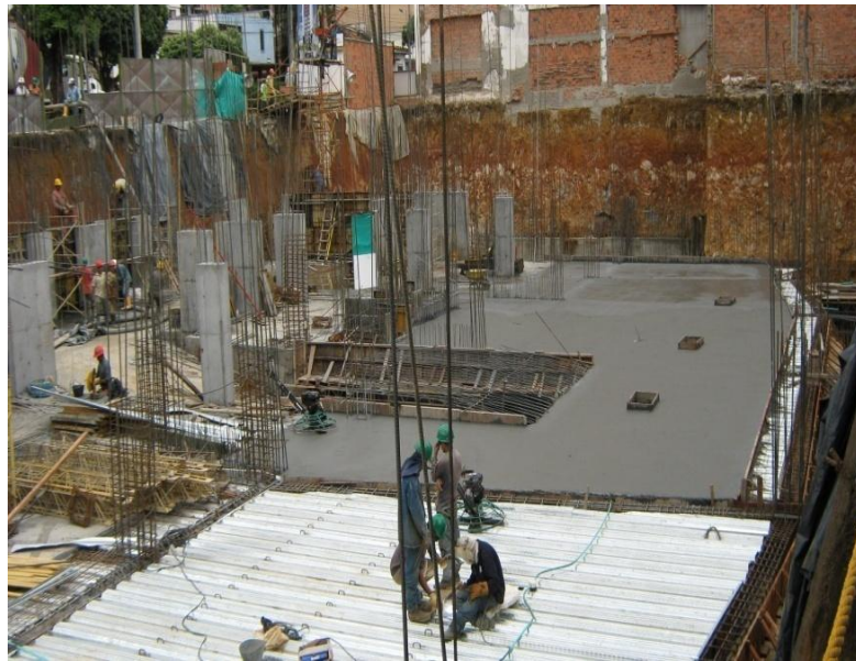
Foto 17. Placa en steel deck fundida en concreto de 3000 Psi.
