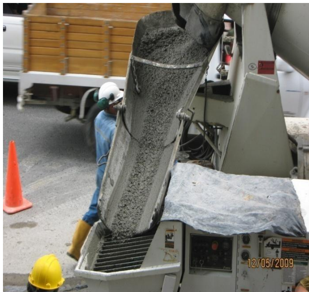
Foto 37. Mezcla homogénea del concreto.
