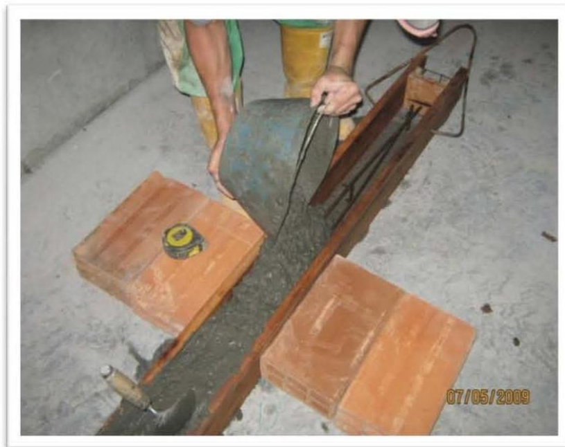
Foto No. Vaciado de concreto con balde para topellantes.
