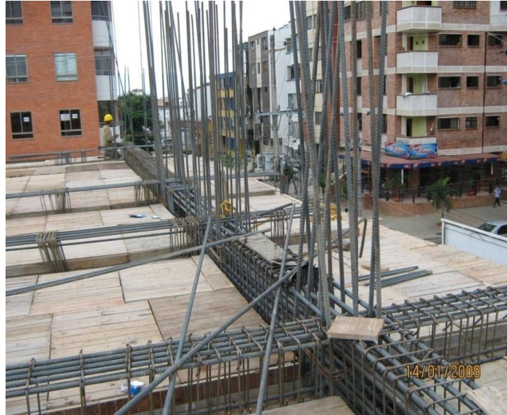
Foto 22. Armado de acero para vigas principales.
