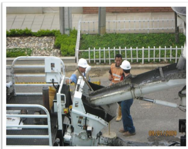
Foto 30. Vaciado y bombeado del concreto.
