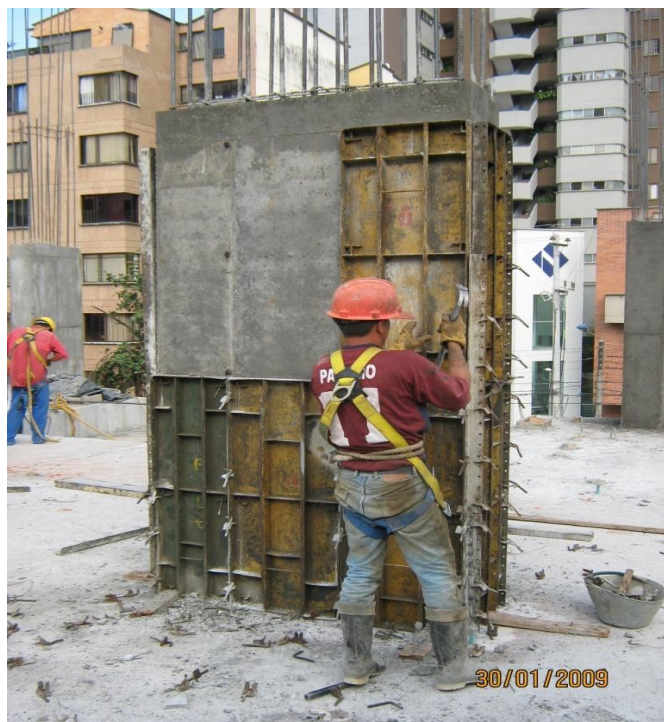
Foto 11. Desencofrado de columnas al día siguiente de fundidas las columnas.
