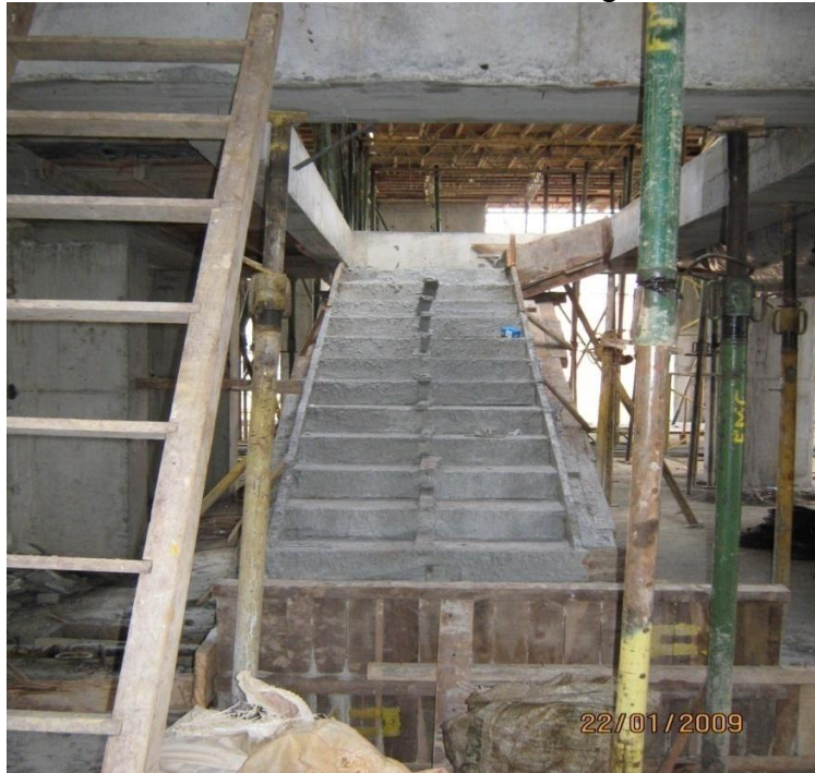
Foto 36. Escalera fundida y desencofrada.
