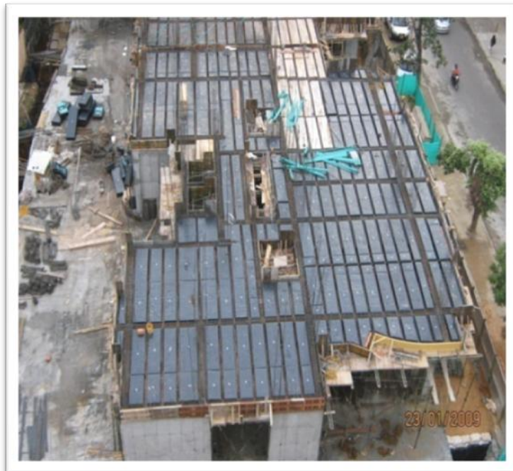
Foto No. 25. Ubicación de los casetones. Vista aérea de la placa.
