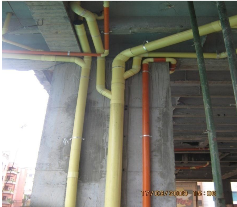
Foto No.46. Bajantes tubería sanitaria. Para prueba de estanqueidad.
