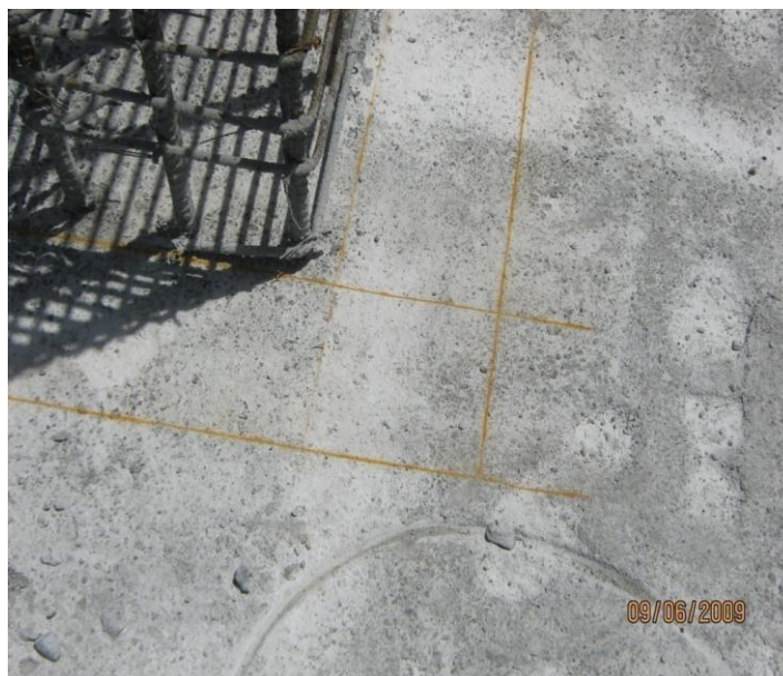
Foto No.4. Marcación de ejes para columnas.
