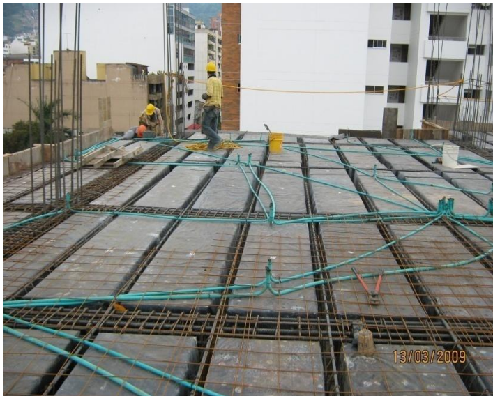
Foto 19. Placa aligerada en casetones de madera o icopor sintético.
