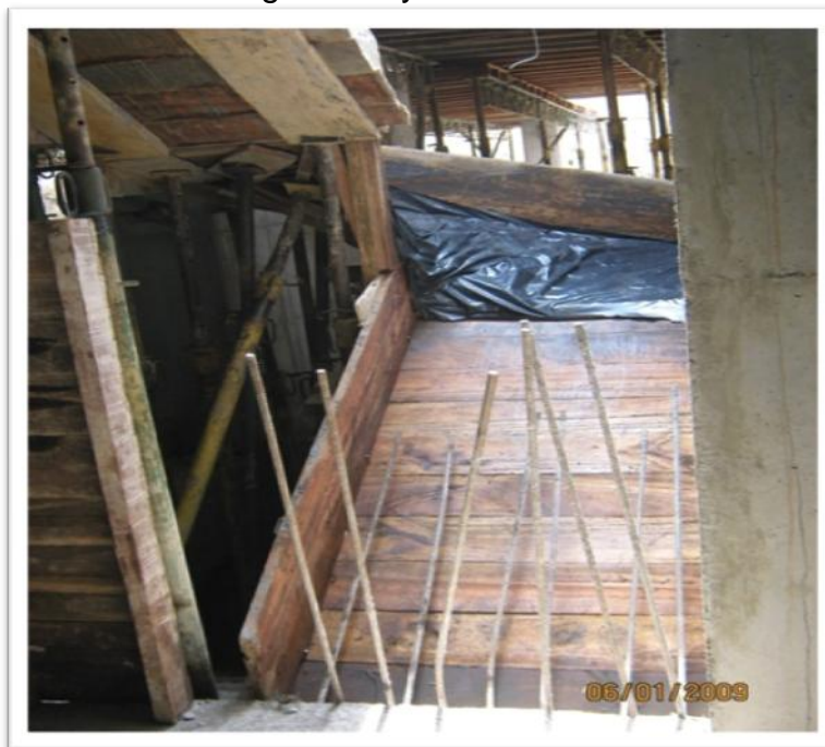
Foto 33. Entablado de las escaleras sótanos hasta piso 5.
