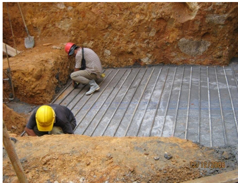
Foto 3. Armado de la parrilla en acero para la zapata.
