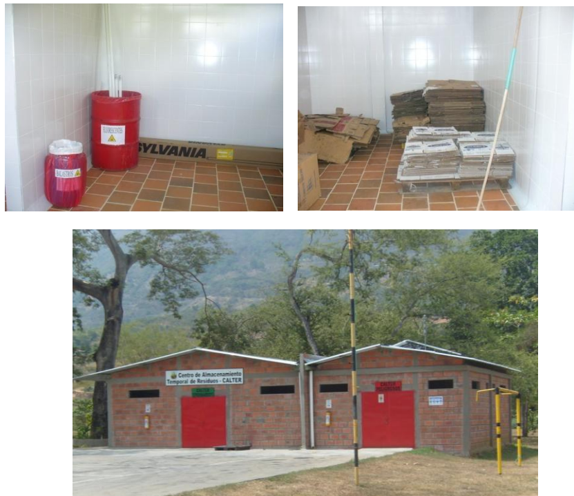
Figura 10. Señalización y adecuación Centro de Almacenamiento Temporal de Residuos- CALTER.
