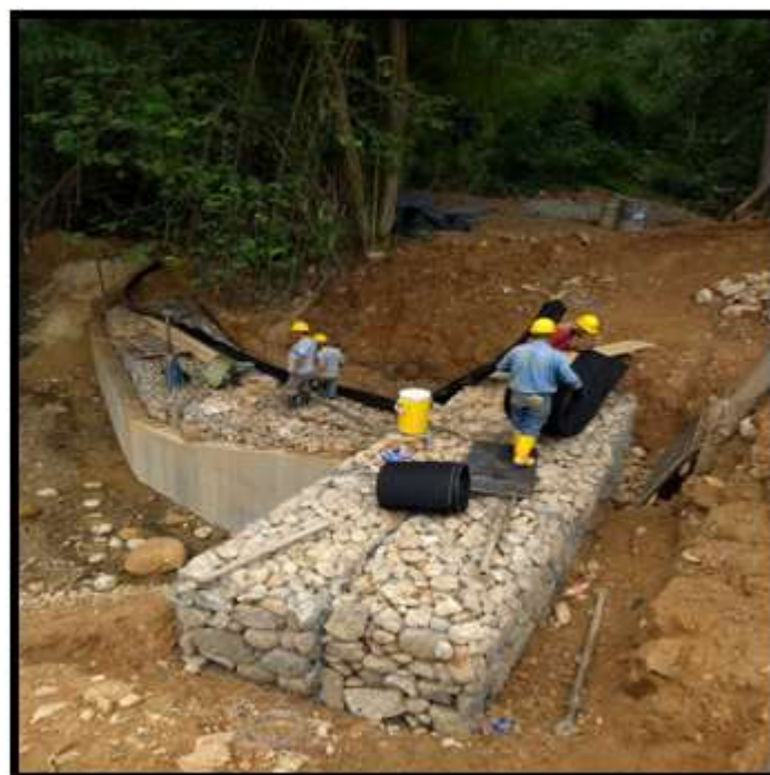
Figura 36. Instalación geodren vial y geomembrana
