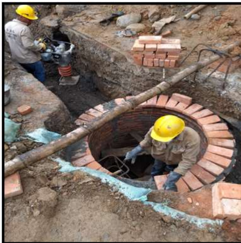
Figura 6. Construcción pozo de inspección
