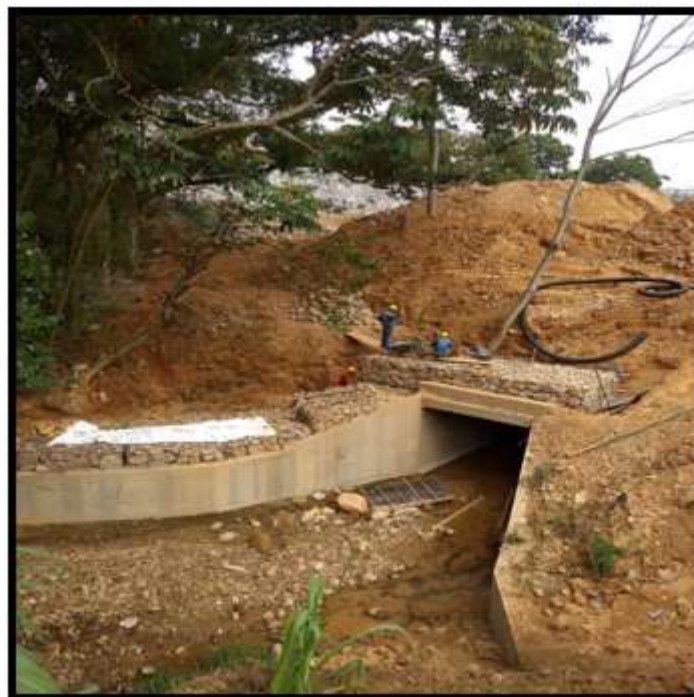
Figura 33. Primer registro, zona entrada box culvert, gaviones
