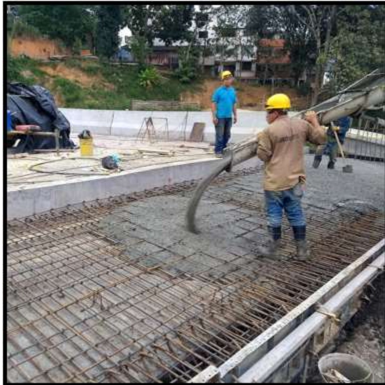
Figura 19. Descargue de concreto para losa de aproximación
