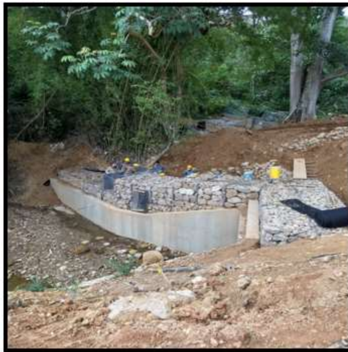
Figura 39. Gaviones y geodren vial entrada box culvert
