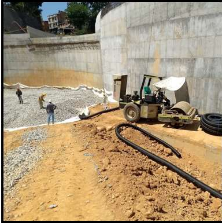
Figura 15. Capa de filtro y geodren vial
