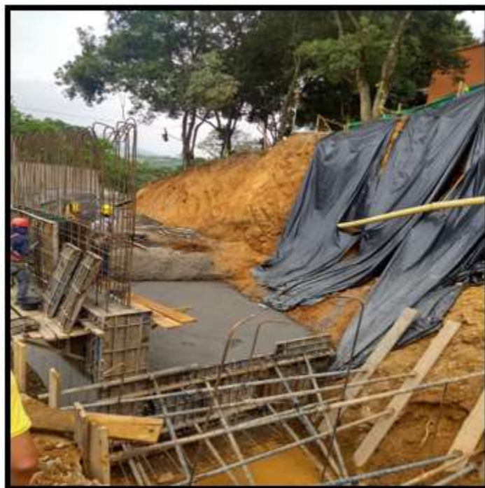
Figura 48. Muros externos, fundida de zapata
