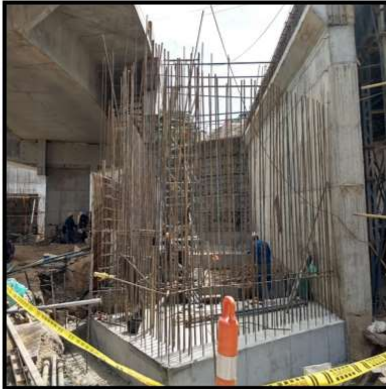
Figura 11. Construcción muros de contención, puente Sur
