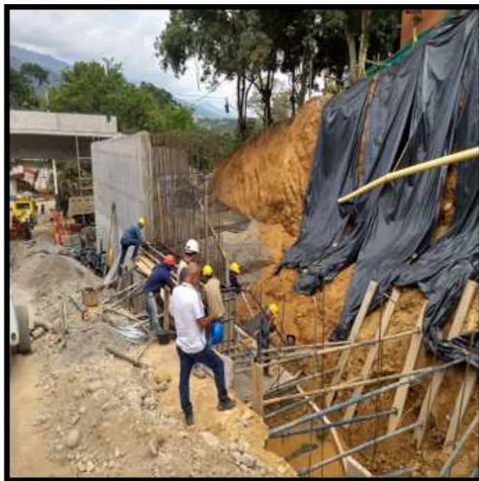
Figura 34. Primer registro, muros puente Norte- occidente
