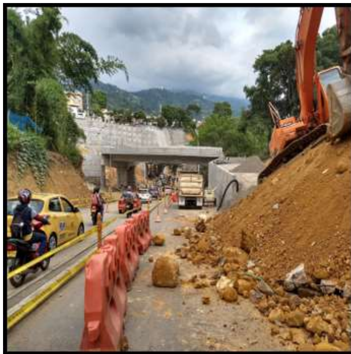
Figura 45. Corte de talud junto a casas Alto Viento II
