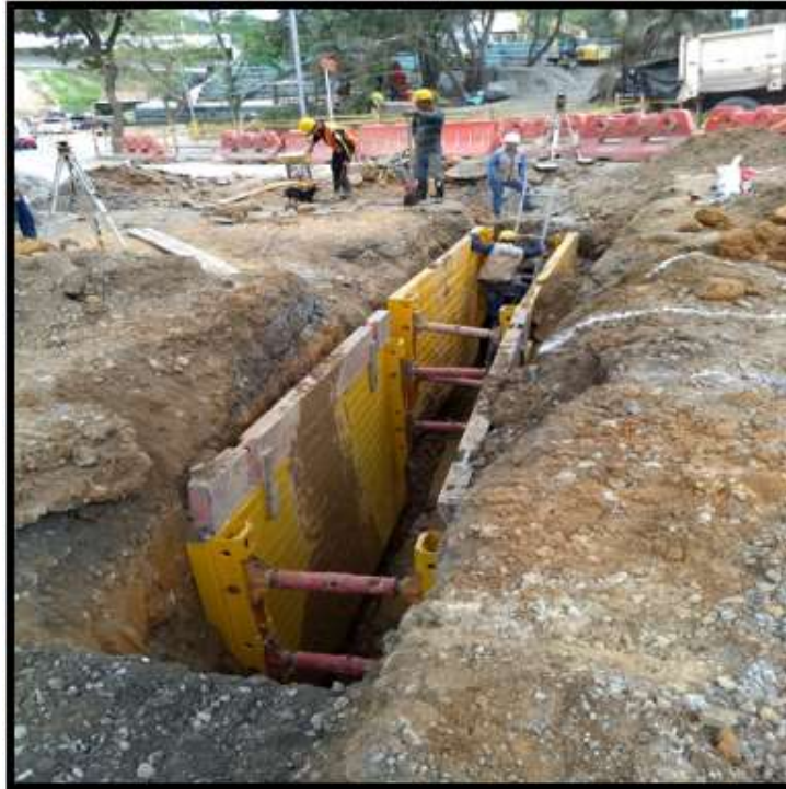
Figura 9. Pantallas entibadoras para protección en zona de zanja
