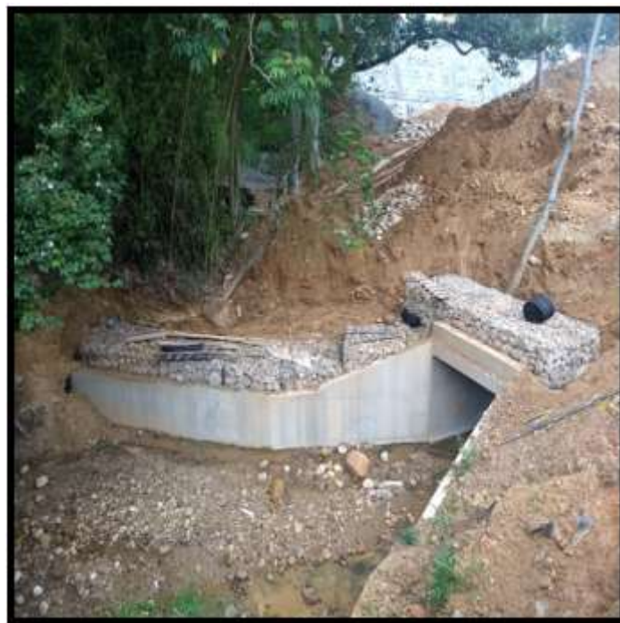
Figura 38. Gaviones y geodren vial entrada box culvert, Quebrada LAS MOJARRAS
