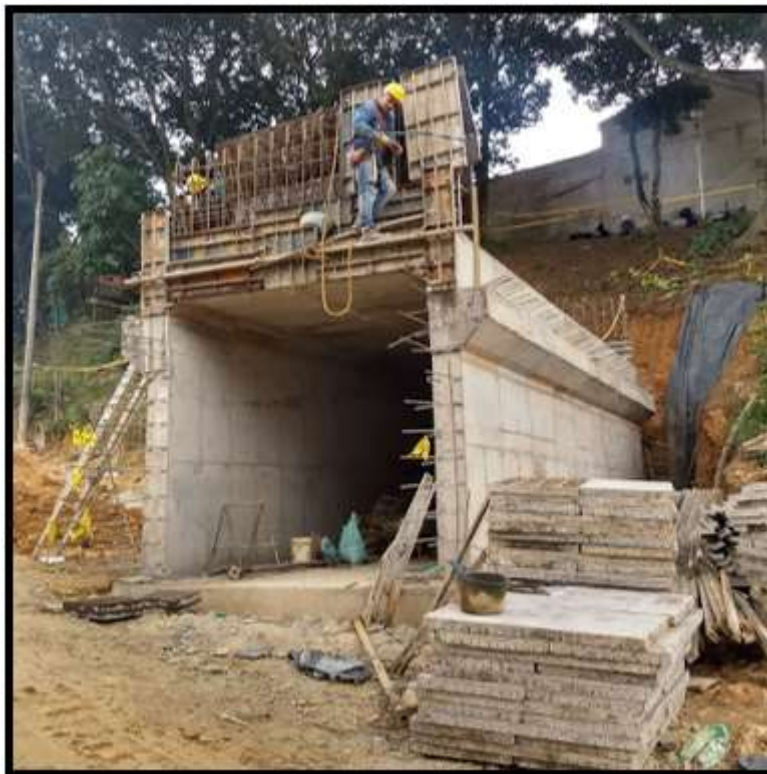
Figura 25. Desencofrado túnel peatonal
