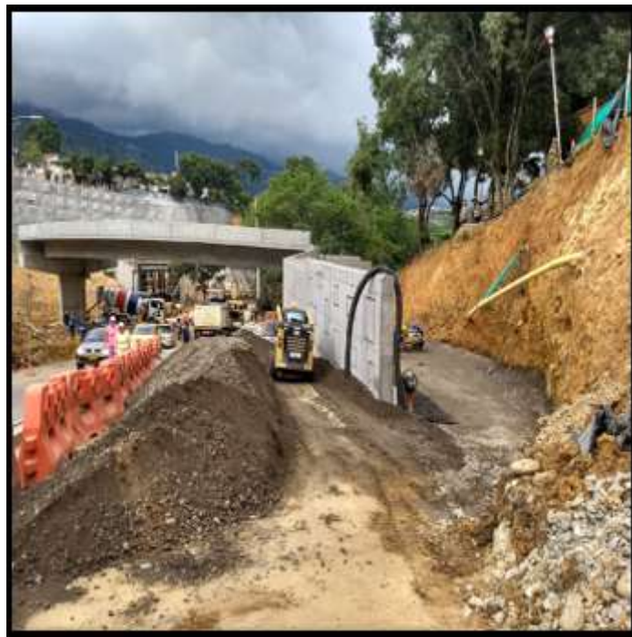
Figura 50. Muros Norte-Occidente para vía de acceso a glorieta elevada
