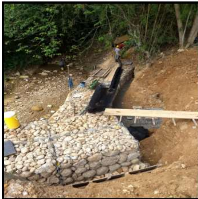
Figura 35. Instalación geodren vial
