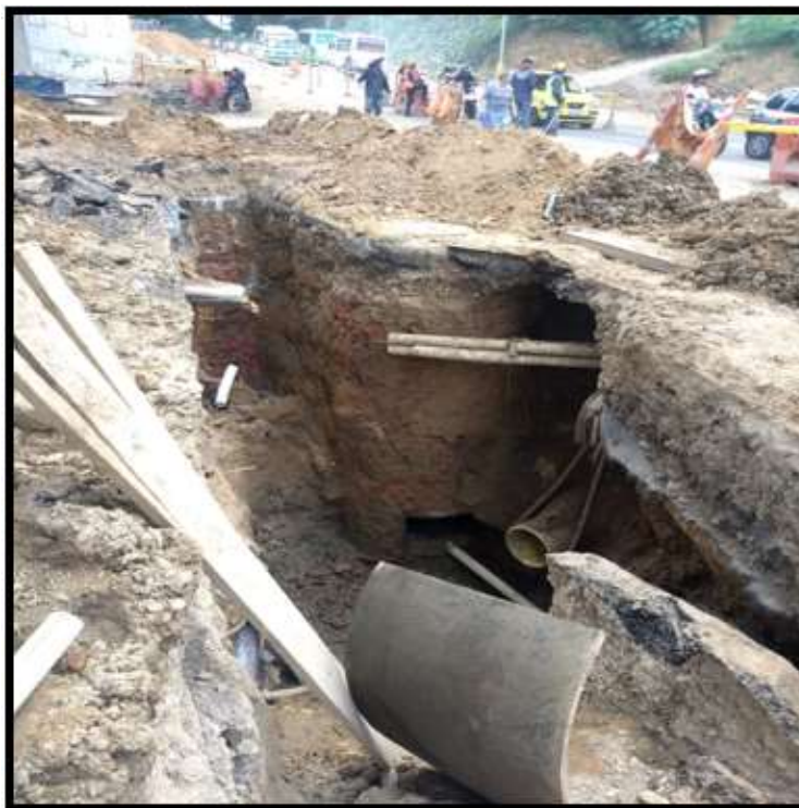
Figura 7. Excavación zanja para tubería alcantarillado
