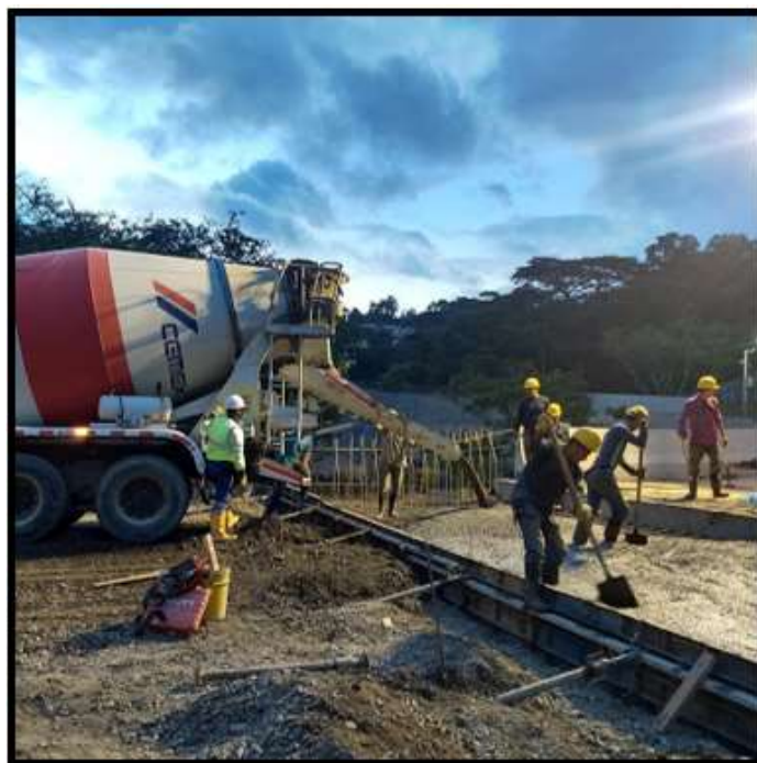
Figura 21. Distribución homogénea del concreto
