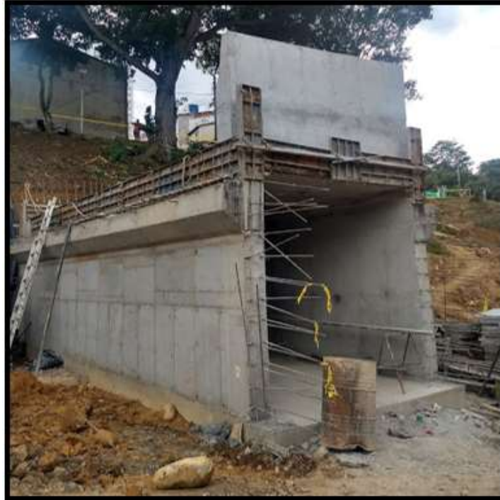
Figura 27. Túnel peatonal y New Jersey vehicular
