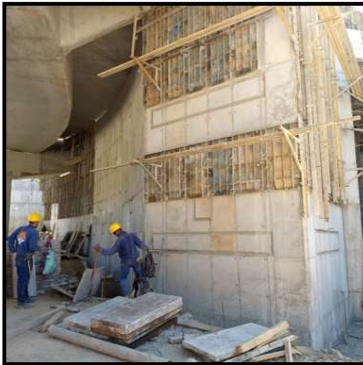
Figura 13. Desencofrado muros puente Sur
