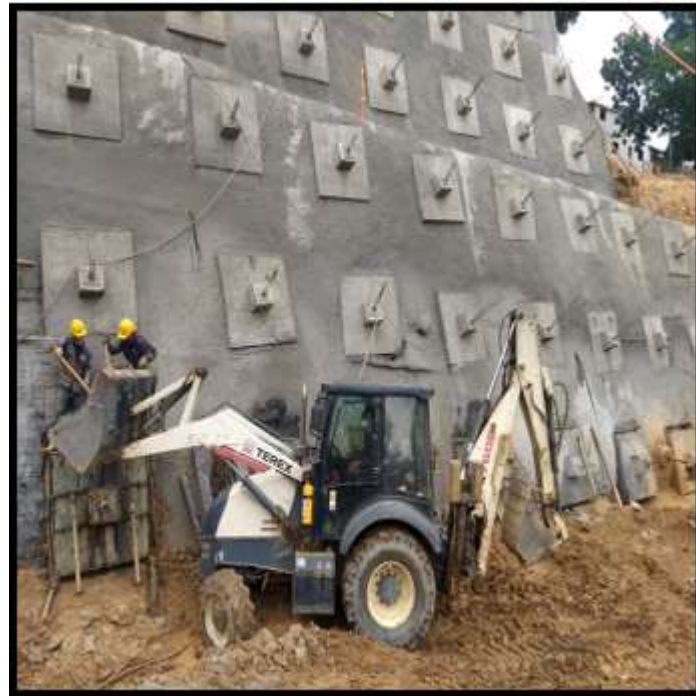
Figura 42. Fundida dados para anclajes
