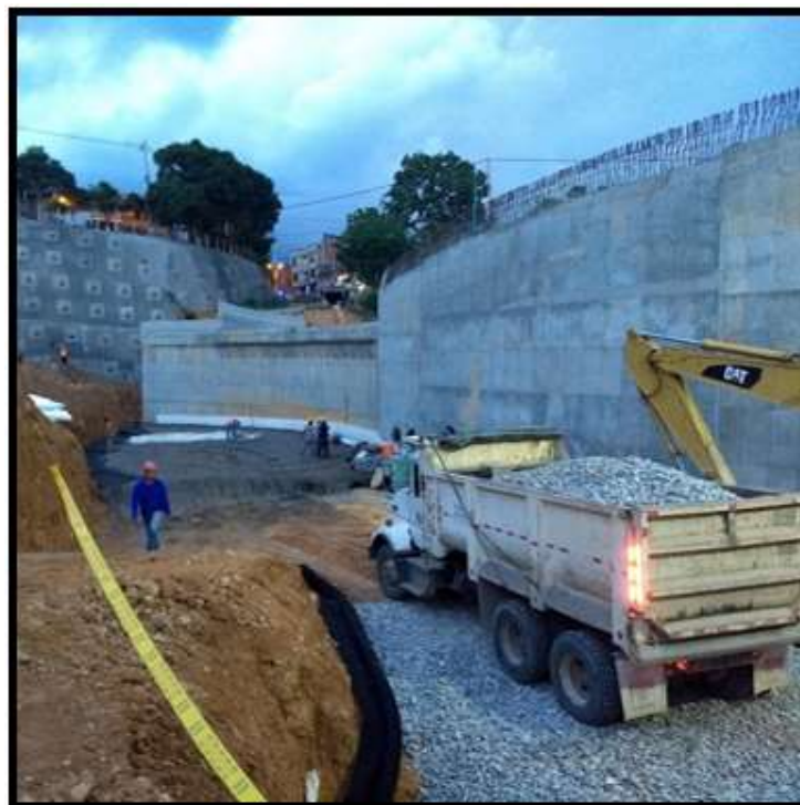
Figura 17. Descargue de grava para capa de filtro
