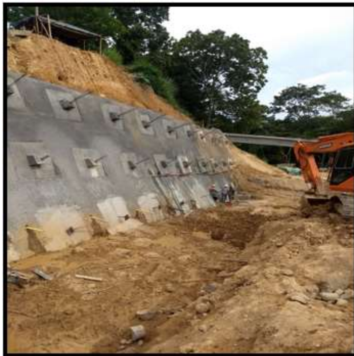
Figura 32. Primer registro, relleno en tierra armada, zona SUR- occidente
