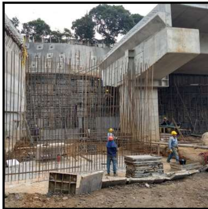
Figura 12. Construcción muros de contención puente Sur
