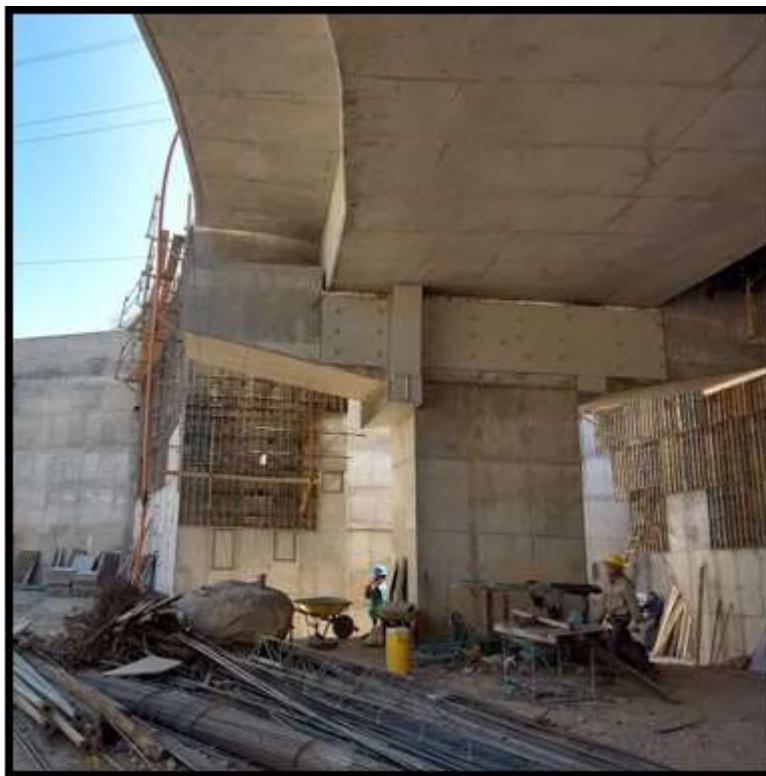
Figura 14. Muros de contención puente Sur
