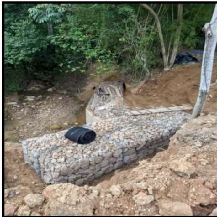
Figura 37. Instalación geodren vial y geomembrana
