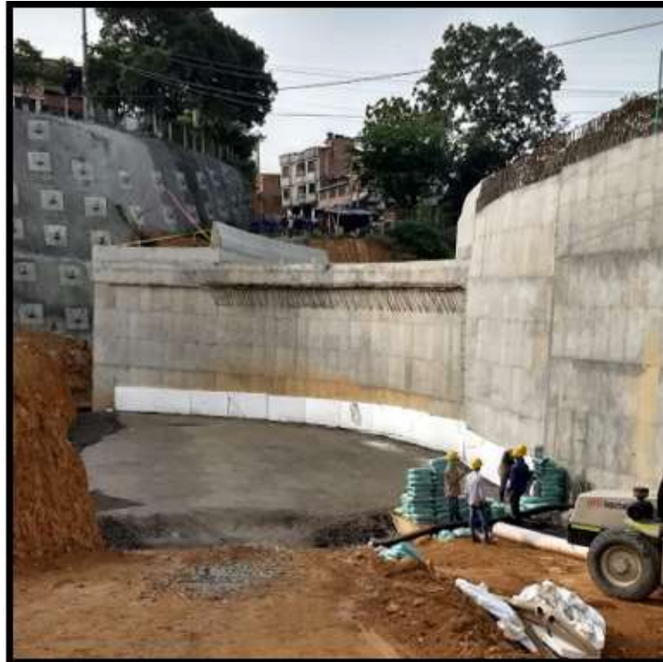
Figura 16. Primeras capas de sub-base y refuerzo geotextil
