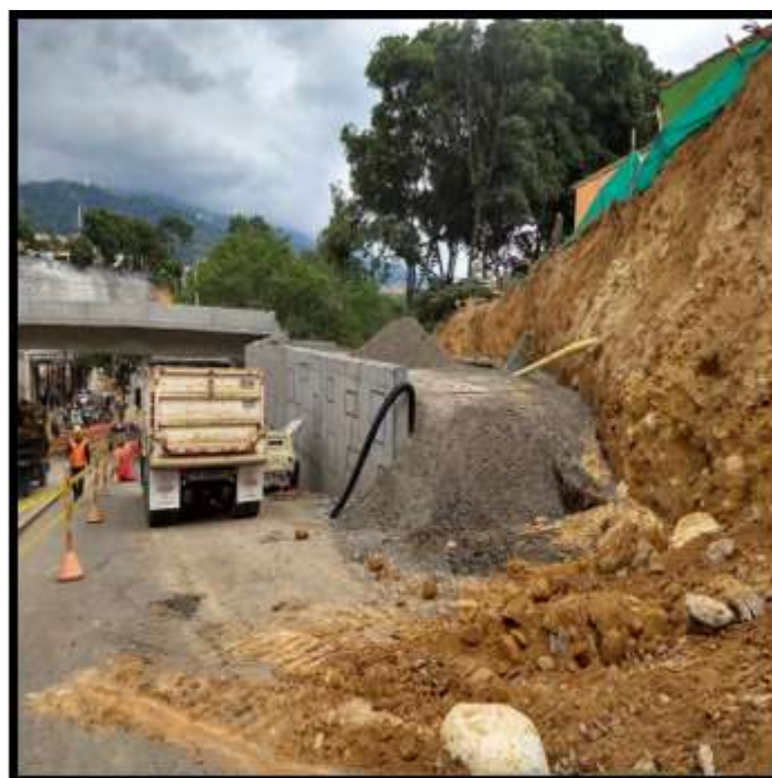
Figura 46. Corte de talud, casas Alto Viento II
