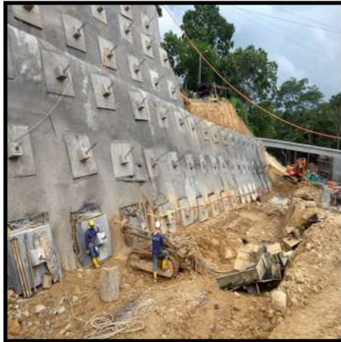
Figura 40. perforación e instalación de geodrenes
