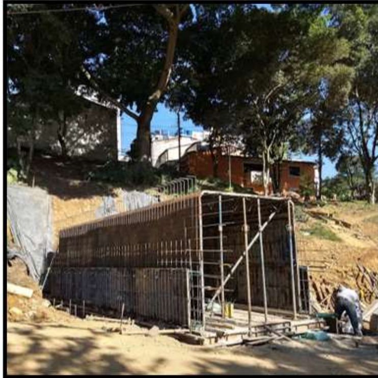
Figura 24. Armado de formaletas para box peatonal
