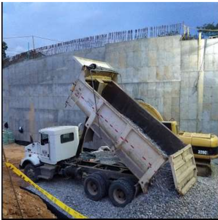
Figura 18. Descargue de grava proveniente de Pescadero
