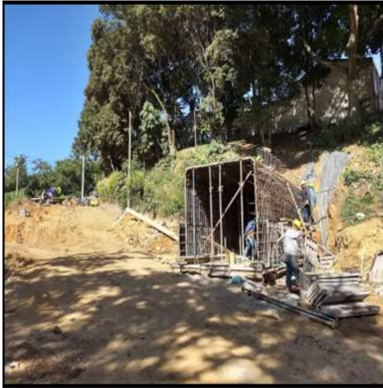
Figura 23. Construcción box culvert peatonal
