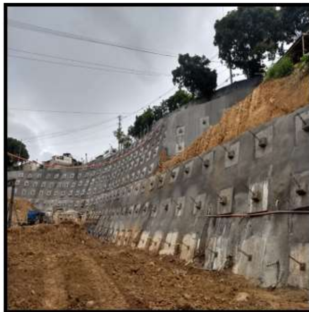
Figura 41. Anclajes y concreto lanzado, zona oriental
