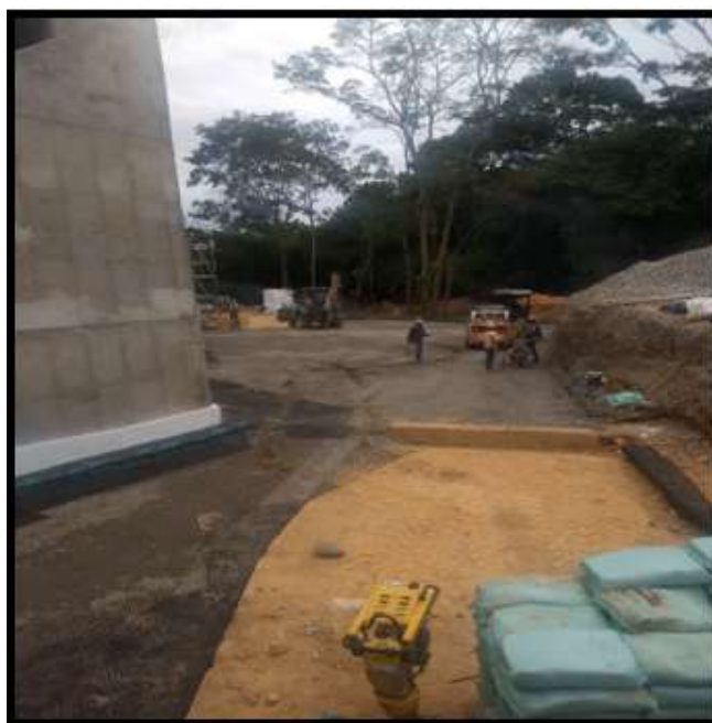
Figura 29. Primer registro, relleno en tierra armada, zona
