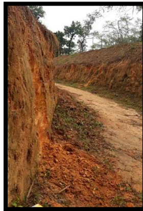
Ilustración 55. Talud analizado UPB Bucaramanga
