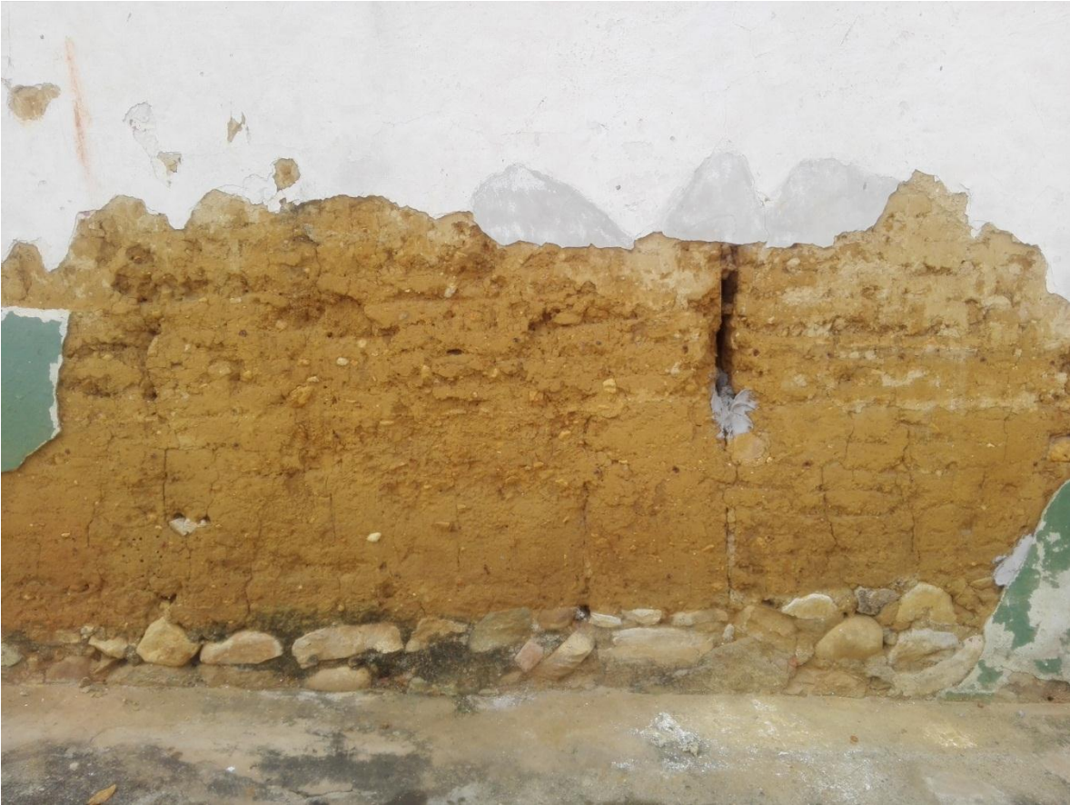
Muro en tierra de casa del barrio la concordia
