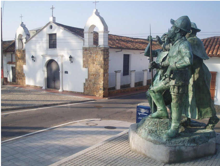
Ilustración 1. Capilla de nuestra Señora de los Dolores, construcción en tapia en la ciudad de Bucaramanga.
