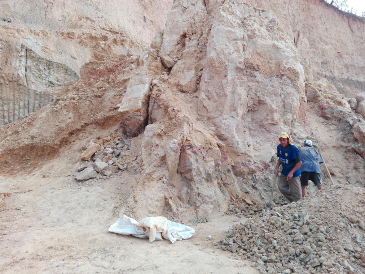
Extracción del material
