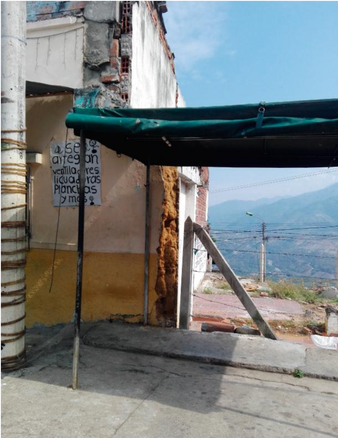
Muros en tierra comprimida del sector
