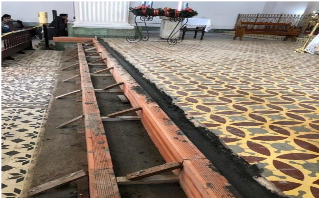
Figura 4. Fundición segunda grada nave central Fuente- Autoría propia
