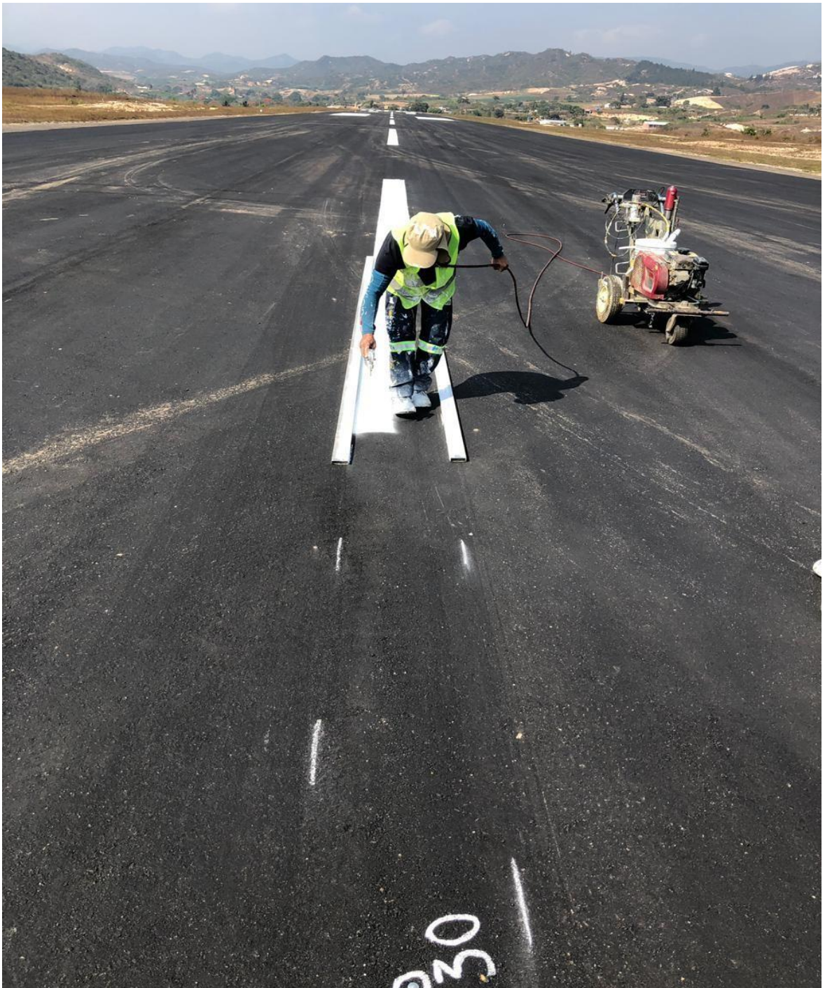
Figura 11. Instalación de señalización Fuente- Autoría propia
