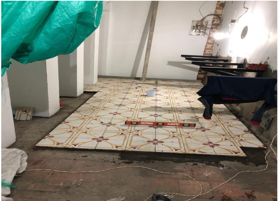
Figura 9. Acabado final del enchape instalado Fuente: Autoría propia.
