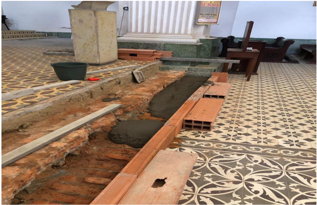
Figura 3. Fundición de concreto Fuente- Autoría propia
