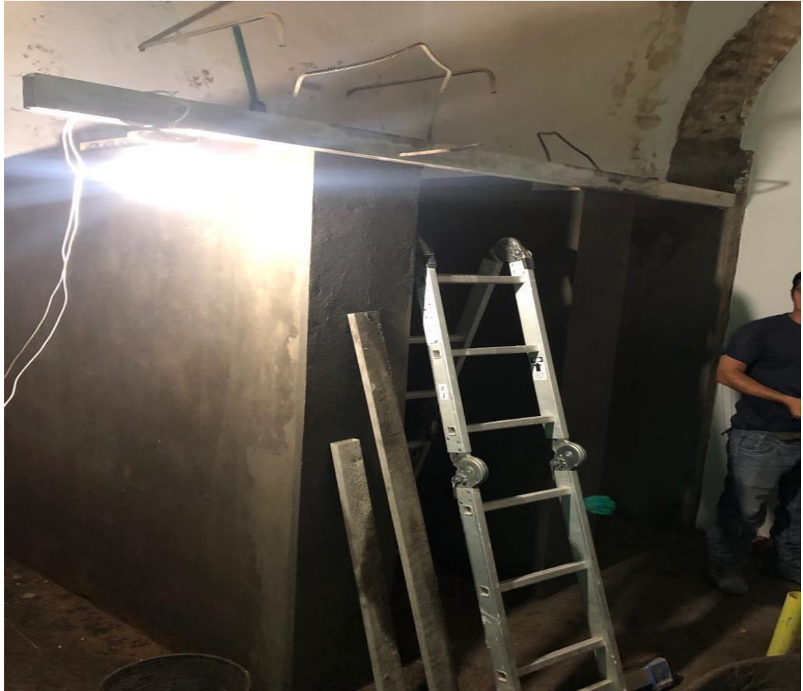
Figura 8. Empañetado de muros divisorios vista 3 Fuente: Autoría propia
