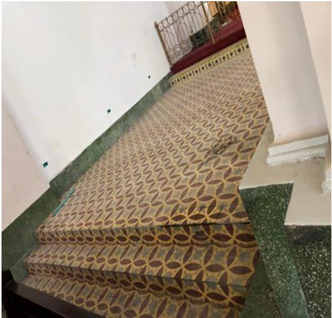
Figura 5. Instalación final de baldosas para las gradas, nave izquierda. Fuente: Autoría propia.
