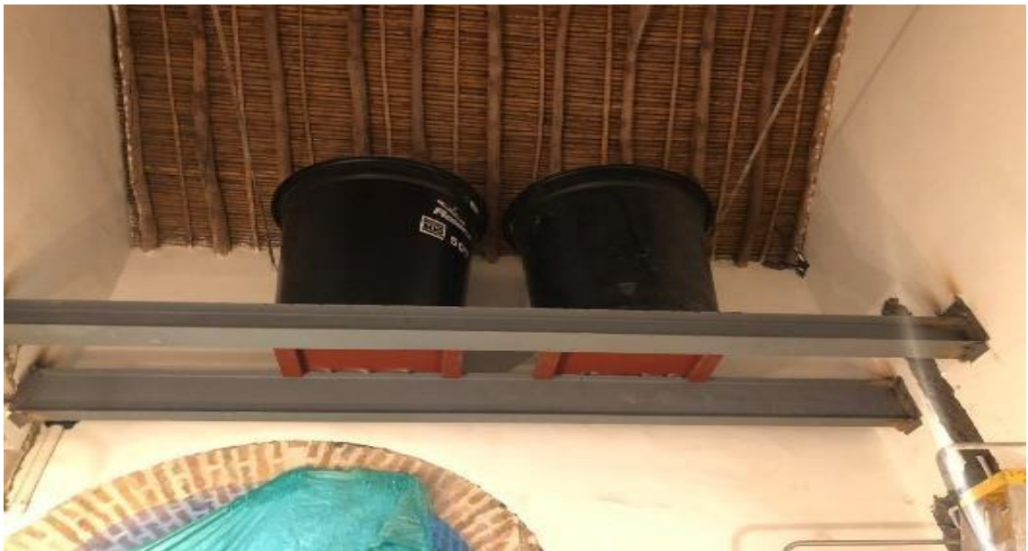
Figura 13. Instalación de tanques Fuente- Autoría propia
