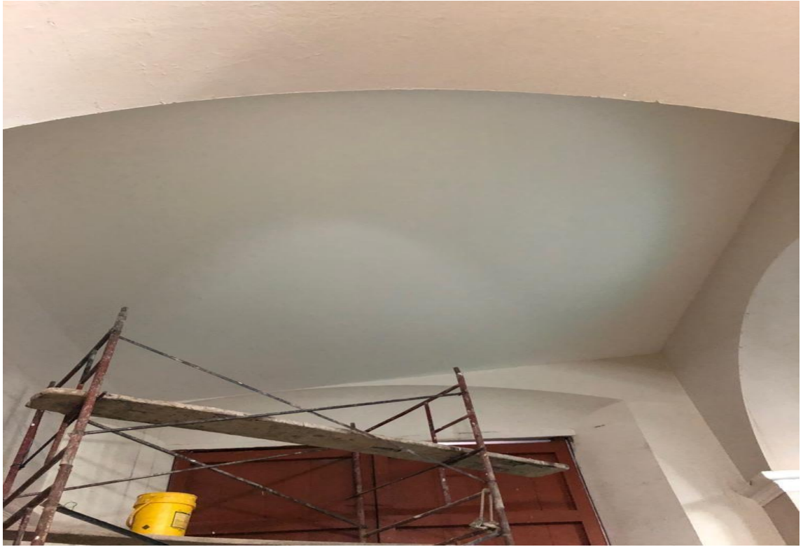
Figura 7. Acabado Final Drywall nave derecha Fuente: Autoría propia.
