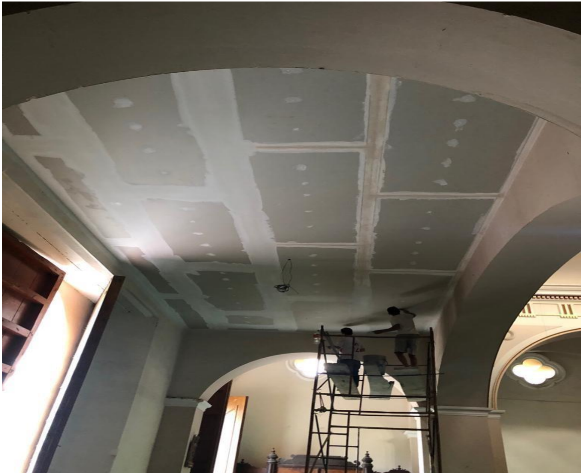
Figura 6. Instalación Drywall nave central Fuente: Autoría propia.
