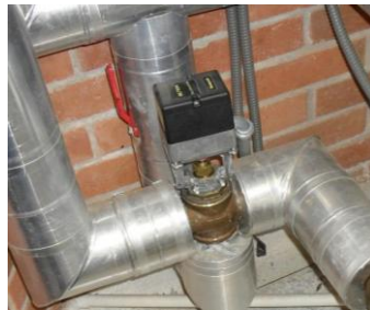
Figura 13 Válvula proporcional
