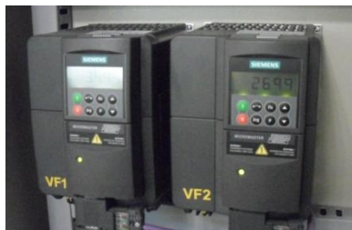
Figura 14 Variador de frecuencia MICROMASTER 420 de SIEMENS
