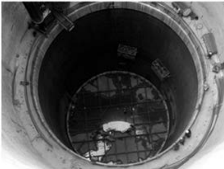
Figura 10. Estructura para la losa (izq.) e instalación de tubería para el colado de concreto (der.)
