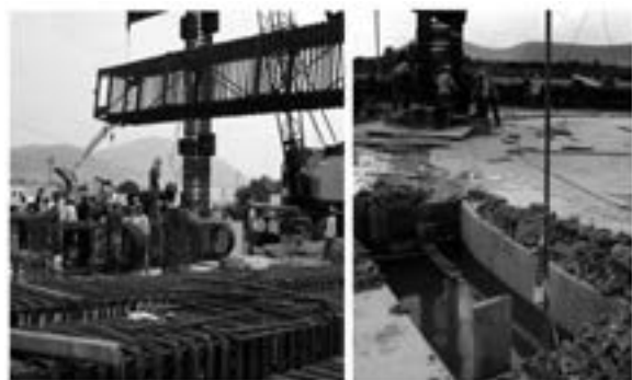
Figura 7. Trabajos necesarios para la construcción de los muros Milán
