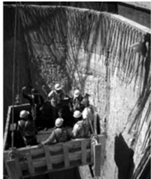
Figura 8. Personal descendiendo con el uso de canastillas improvisadas
