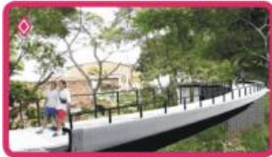
Puente Peatonal Carrera 48ª - Quebrada Juan Bobo
