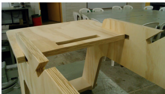
Fig. 6. Ensamble tipo ranura. Fuente: archivo Grupo de Investigación de Estudios en Diseño -GED- de la Facultad de Diseño Industrial de la Universidad Pontificia Bolivariana.
