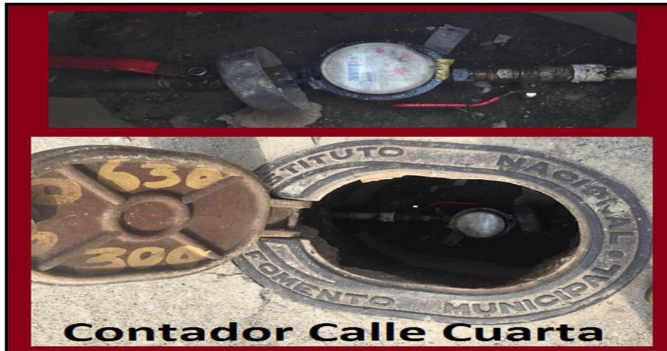
En la imagen 4 se observa un contador análogo ELSTER de 1" hacia una línea hidráulica diferente en tubería PVC tipo pesado de 1" que lleva agua del acueducto hacia las áreas externas del proceso (PTAR, pasillos de la planta, patio #1, etc.).
