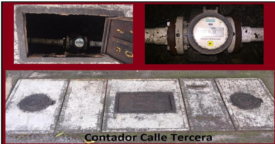
En la imagen 3 se observa la tubería en PVC tipo pesado de 1" donde llega el agua del acueducto y a la cual en la Calle Tercera se le instaló un contador
