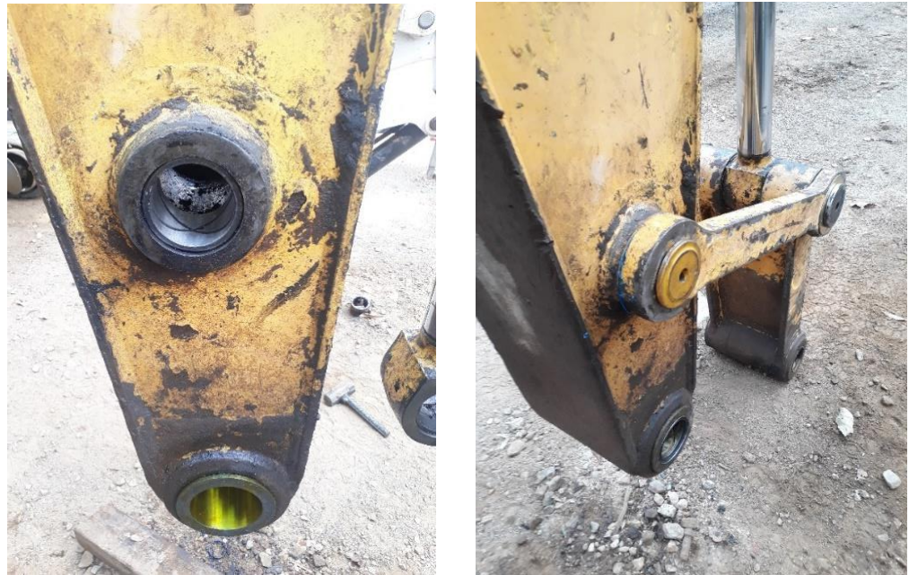
Figura 39. Porta bujes, bujes y pasadores de las excavadoras Kobelco SK210 y New Holland E215B instalados.
