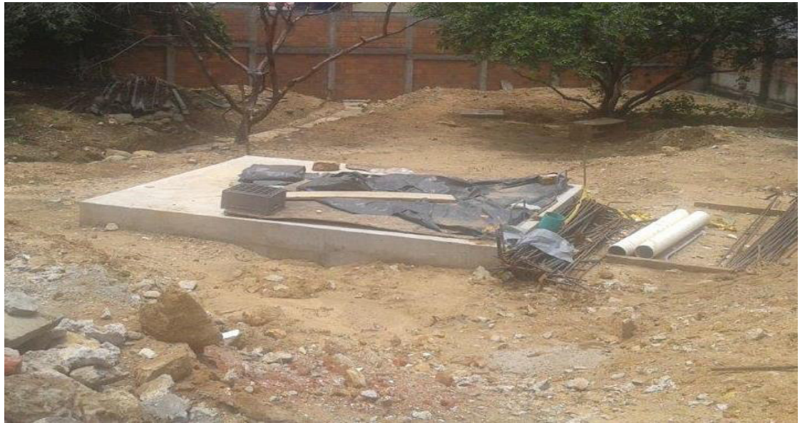
Figura 22. Trampa de aceite en construcción. Fuente: Autor.
