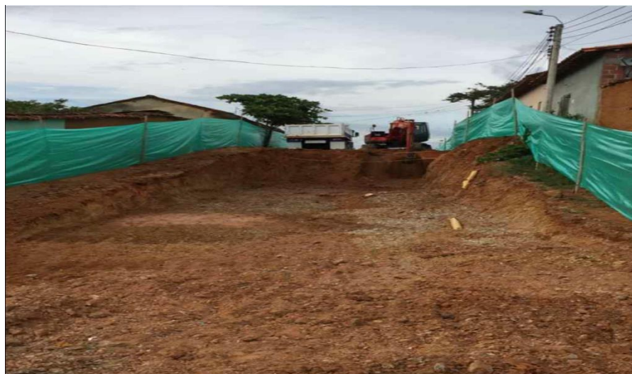
Imagen 33. Seguimiento al cambio de alcantarillado. Fuente: Autor.
