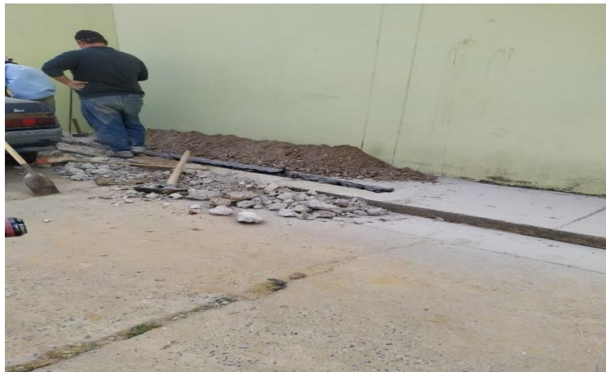
Imagen 7. Visita de inspección a obra de instalación de tubería para servicio de gas natural domiciliario en el barrio El Colegio. Fuente: Autor.
