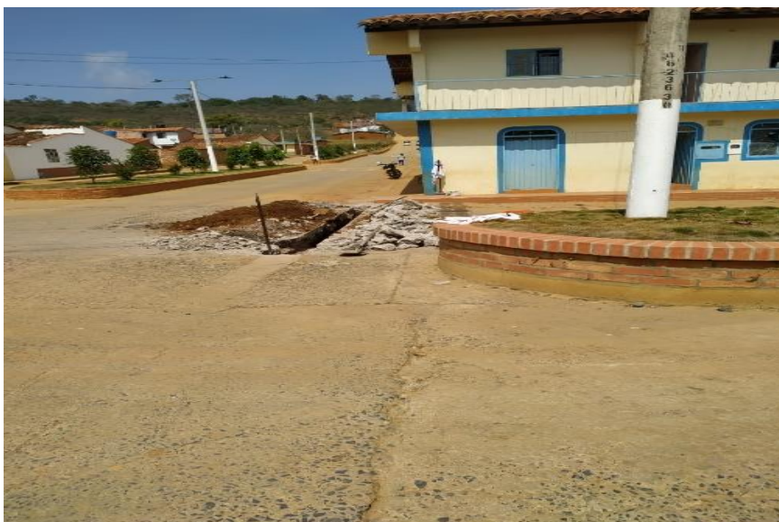
Imagen 8. Visita de inspección a obra de instalación de tubería para servicio de gas natural domiciliario en el barrio El Colegio. Fuente: Autor.
