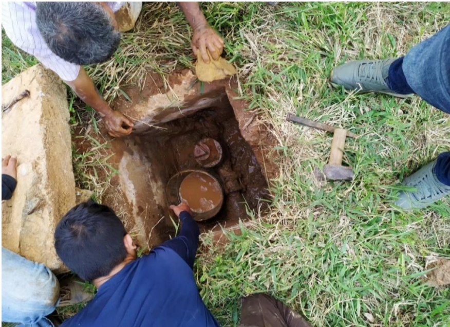
Imagen 31. Revisión de cambio de válvula de distribución de agua. Fuente: Autor.
