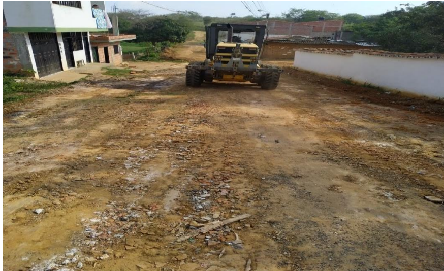
Imagen 32. Seguimiento a nivelación de terreno. Fuente: Autor.
