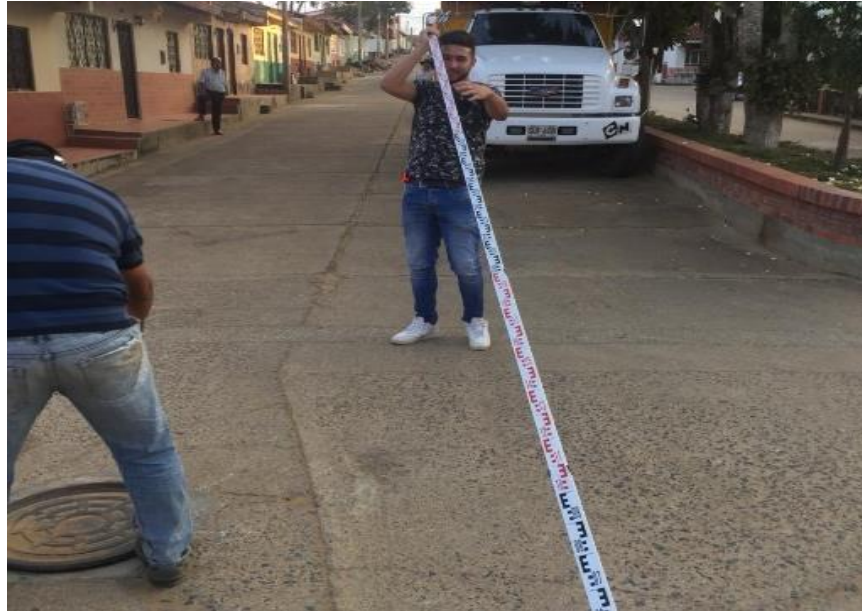
Imagen 10. Revisión pozo de aguas negras barrio Brisas. Fuente: Autor.
