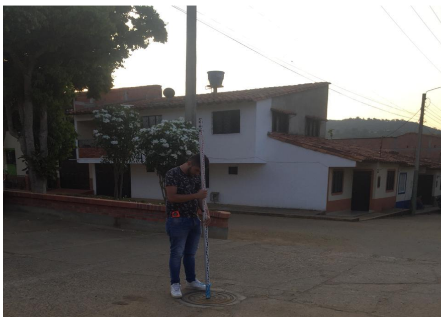
Imagen 9 Revisión pozo de aguas negras barrio Brisas. Fuente: Autor.
