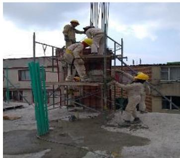
**Imagen 23.** Instalación de formaleta columna del segundo piso.
