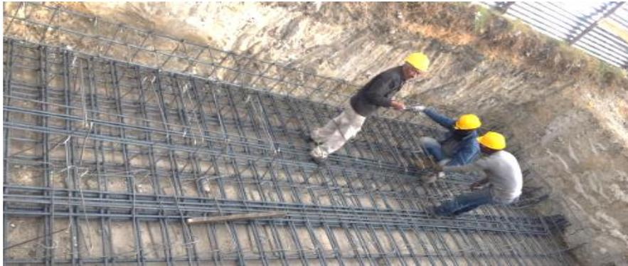
*Imagen 7. Armado de acero de refuerzo para el foso del ascensor.*
