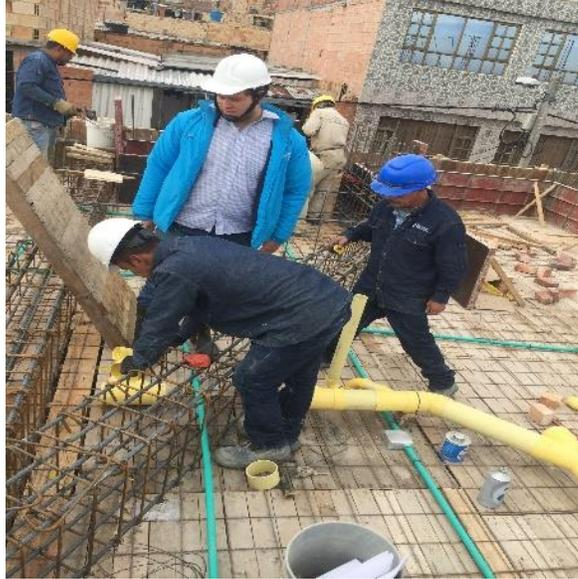
*Imagen 27. Revisión de tuberías sanitarias y eléctricas.*
