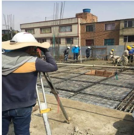
**Imagen 13.** Revisión de nivel para placa flotante.
