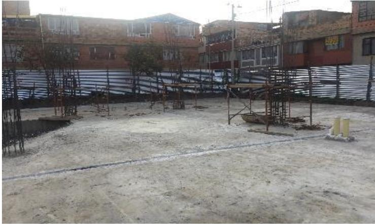
**Imagen 16.** Armado de acero de refuerzo para columnas.
