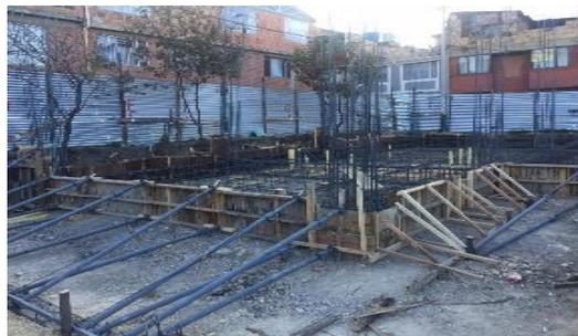
***Imagen 10. Armado de acero de refuerzo en placa flotante.***
