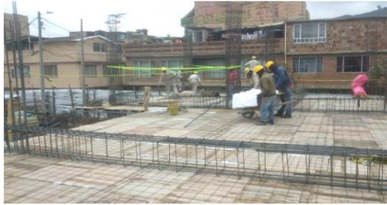
**Imagen 19.** Armado acero de placa flotante del + N 3.25m.
