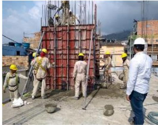
**Imagen 24.** Fundida de columnas y pantallas en el nivel N+3.25 m.
