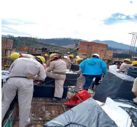
*Imagen 28. Revisión de instalación de casetones.*
