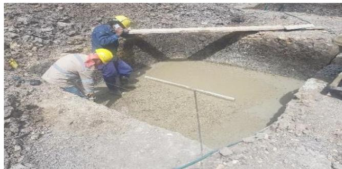
**Imagen 6.** Solado de limpieza de concreto 2000 PSI E: 0.05m.
