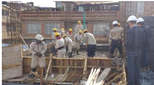
**Imagen 22.** Fundida de concreto del segundo nivel
