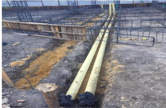
*Imagen 11. Instalación de tubería sanitaria.*
