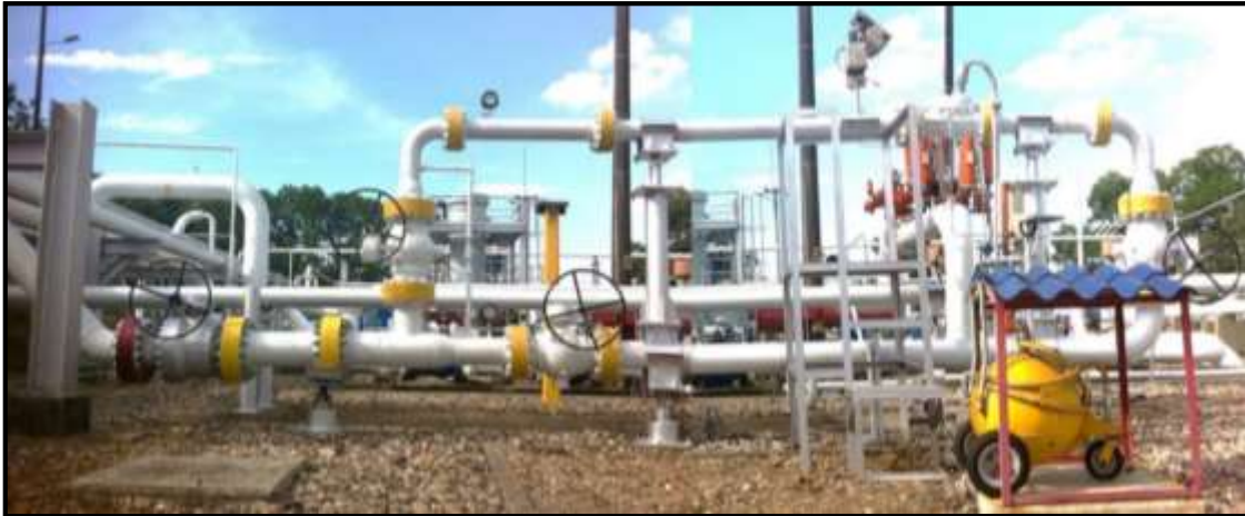
Fuente: Residente Obra, RFM & CIA LTDA
