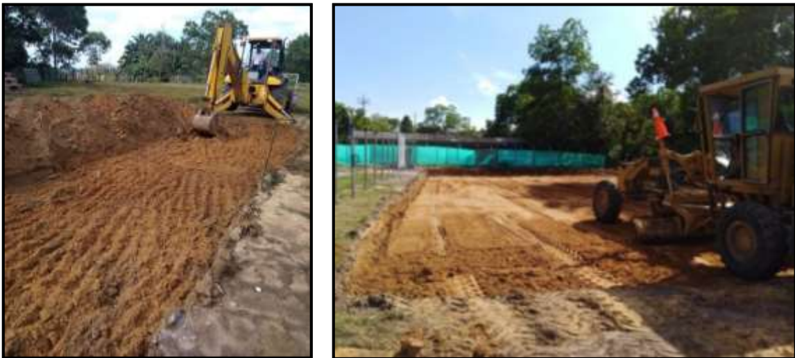
Fuente: Residente Obra, RFM & CIA LTDA.
