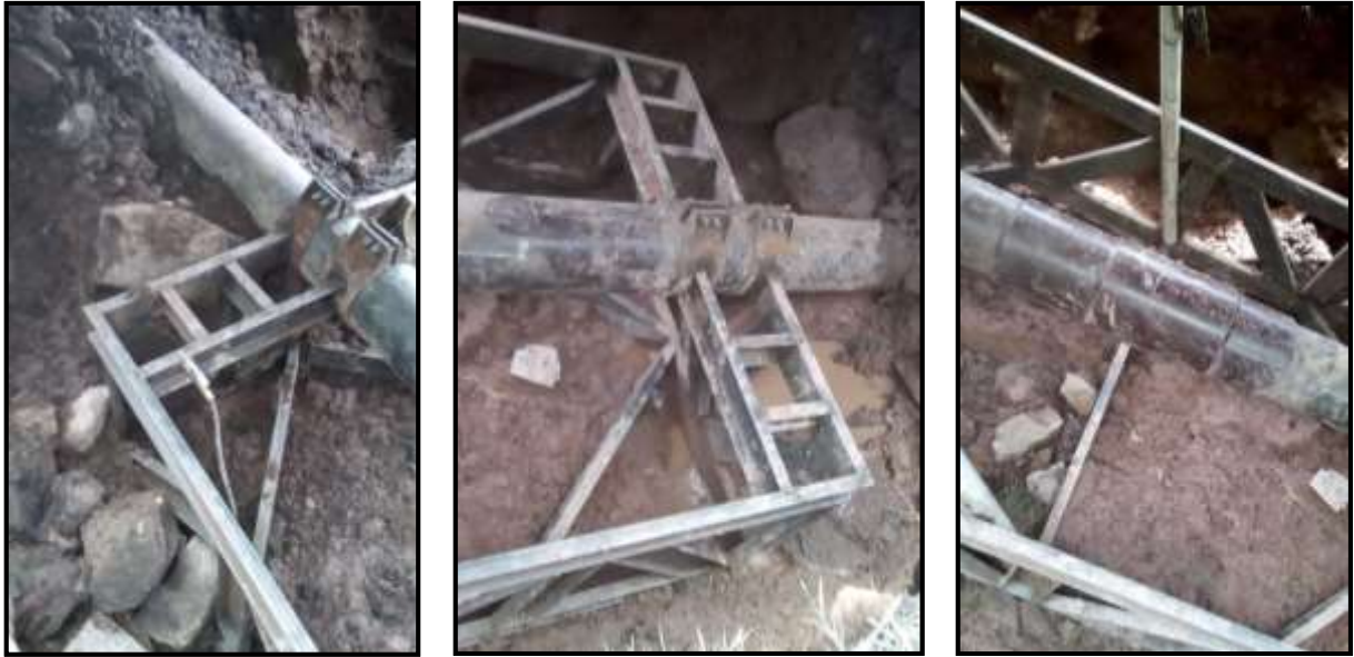
Fuente: Residente Obra, RFM & CIA LTDA
