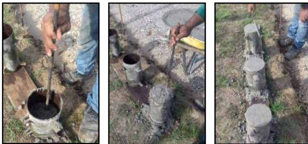
Fuente: Residente Obra, RFM & CIA LTDA
