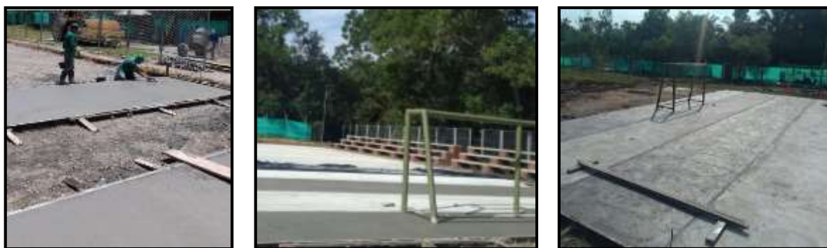
Fotografía 3 Placa de Concreto Fundida Cancha Multifuncional
