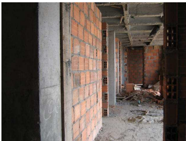
Figura 33– Muros divisorios apartamentos.
