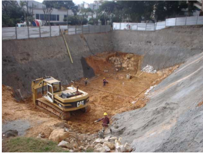
Figura 7 – Panorámica de la Excavación.
