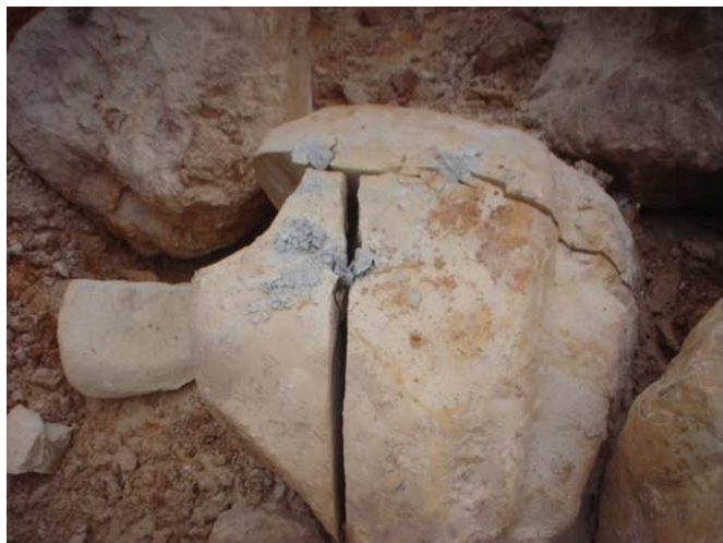
Figura 11 – Roca fracturada con Cras
