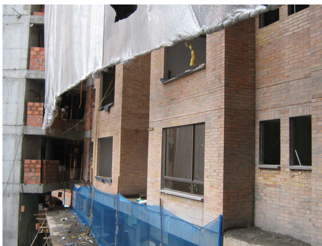
Figura 32– Fachada interior edificio.
