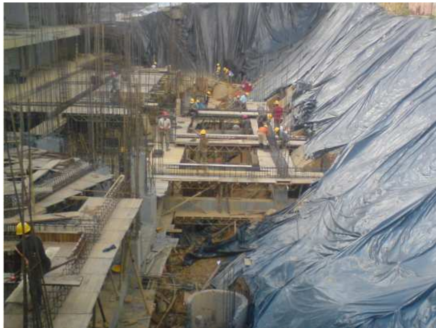
Figura 12 –Lanzamiento de vigas sobre el talud
