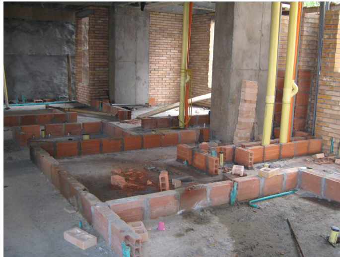
Figura 34– Bajantes sanitarios y de ventilación.
