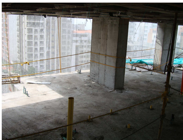
Figura 64- Cerramientos en altura
