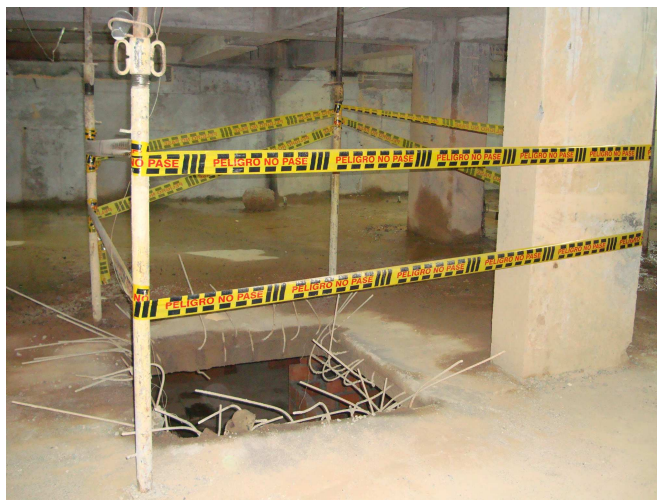
Figura 67- Cerramientos en vacios de placas
