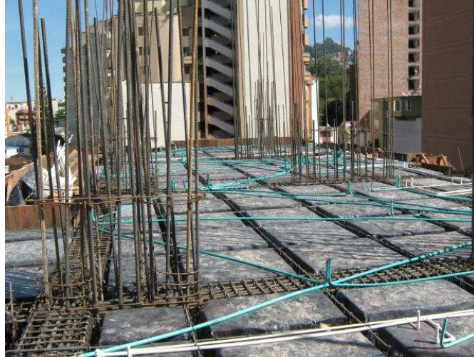
Figura 28– Armada placa aligerada Torre A.
