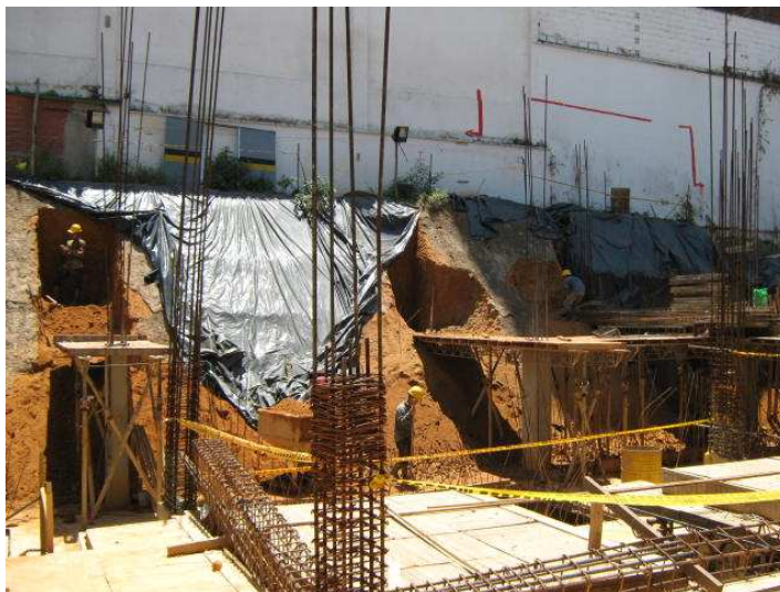
Figura 21 – Excavación por trincheras
