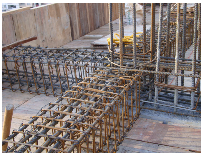
Figura 61– Refuerzo principal placa
