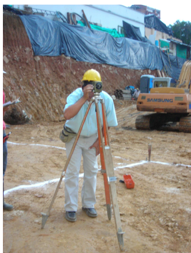
Figura 39– Nivelación del equipo
