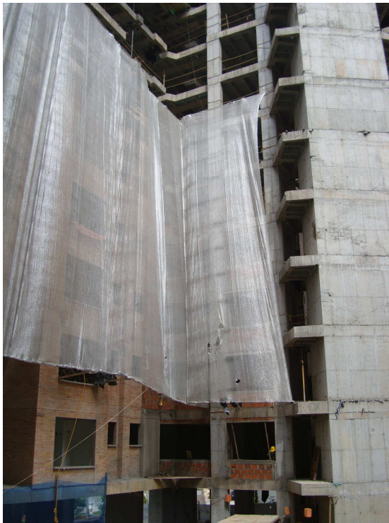
Figura 66- Instalación de alumitex para protección contra material particulado.
