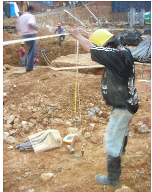
Figura 37– Medición de 10 metros
