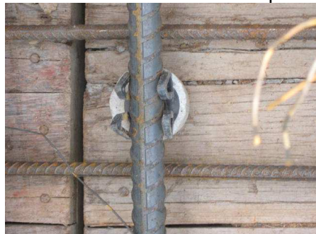
Figuras 30 y 31– Separadores para refuerzo.
