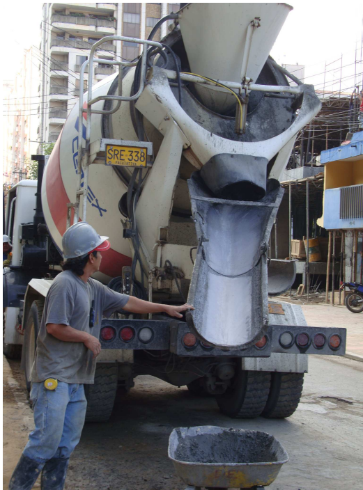
Figura 44– Canal del Mixer húmedo
