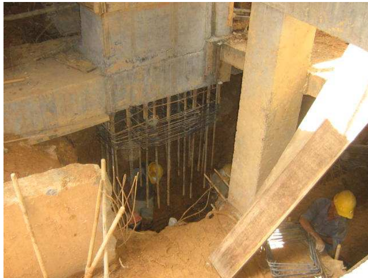
Figura 24– Construcción de columnas verdaderas
