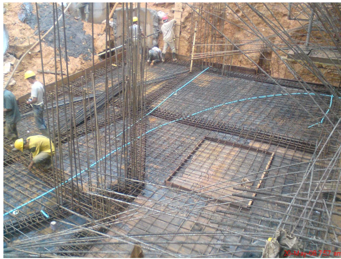
Figura 26– Armada de Placa maciza Sótano Nivel -3 metros
