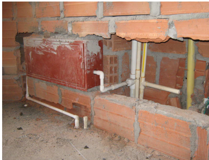
Figura 35– tuberías hidráulicas.
