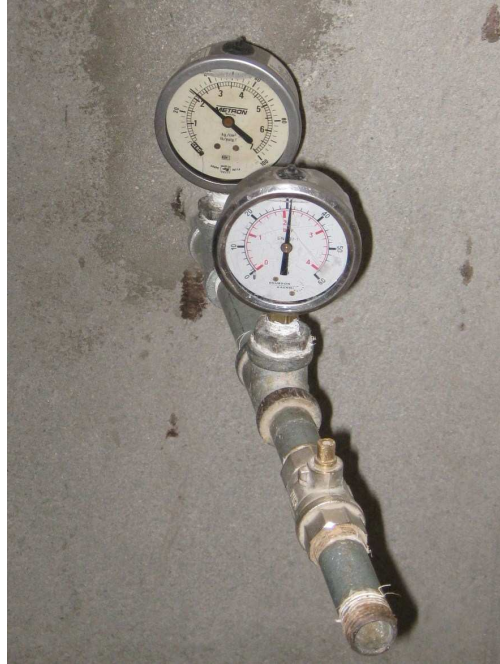
Figura 60– Calibración de manómetros
