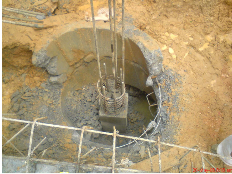
Figura 23 – Caissons con Columna
