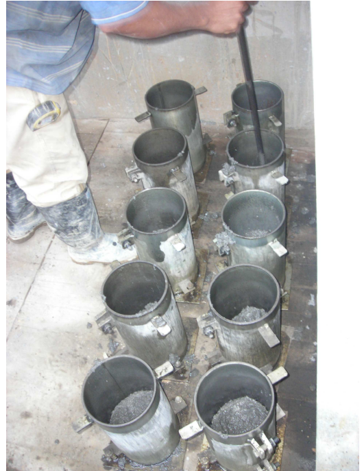
Figura 50– Primera capa de concreto
