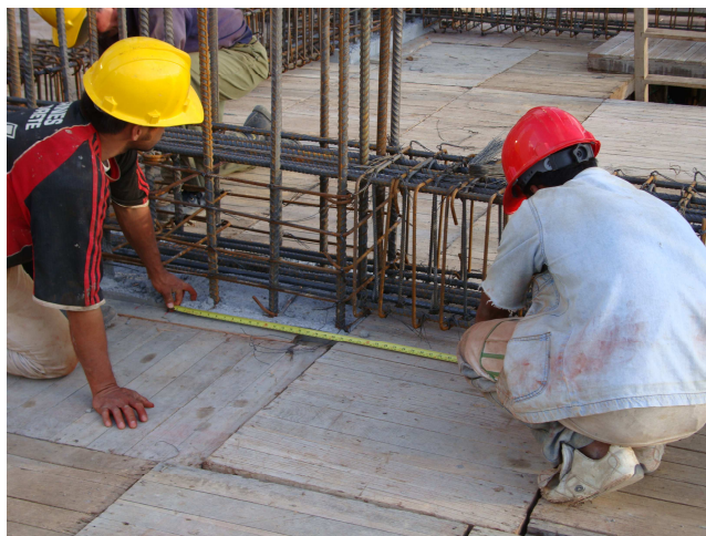
Figura 62– Revisión refuerzo
