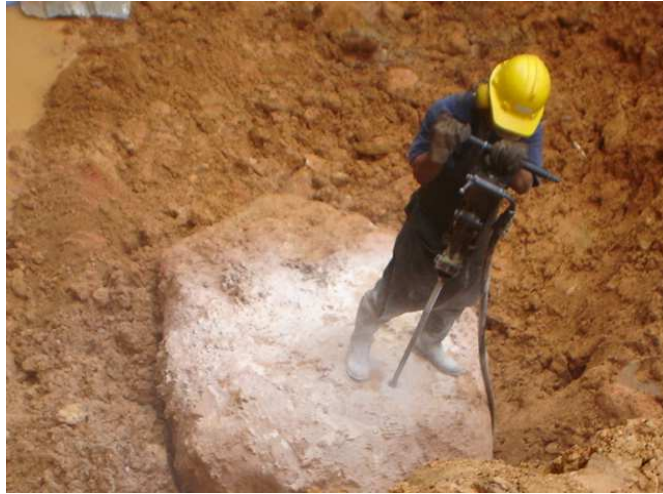
Figura 9– Perforación de la roca.
