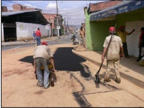
RIEGO DE LIGA Y APLICACIÓN DE MEZCLA ASFALTICA DENSA EN CALIENTE SOBRE LA ZANJA
