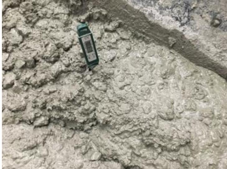
**FIGURA 27. Toma de temperatura al concreto**
