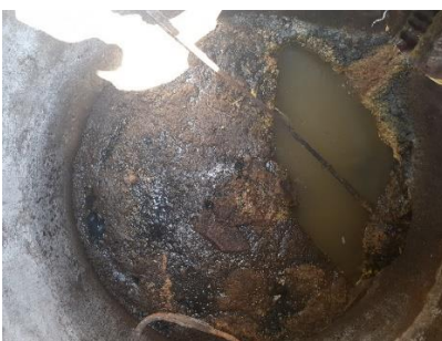
Figura 5. Inspección de pozos
