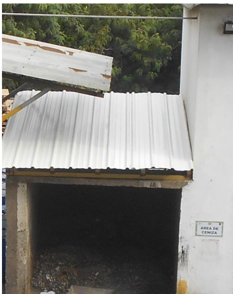
Figura 17. Instalación de techo del cuarto de cenizas
