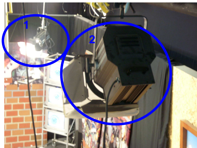
Figura 50. Lámparas del Set #2. 1- Lámpara de 1000W 2- Lámpara de 2000W
