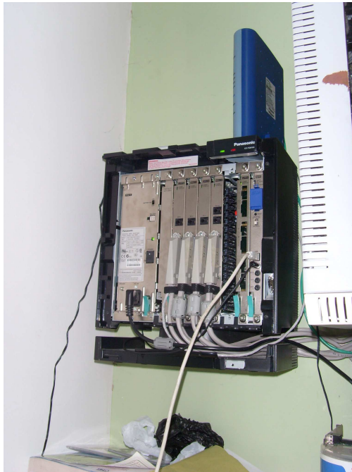
Figura 66. Central Telefónica conectada por puerto USB a PC.
