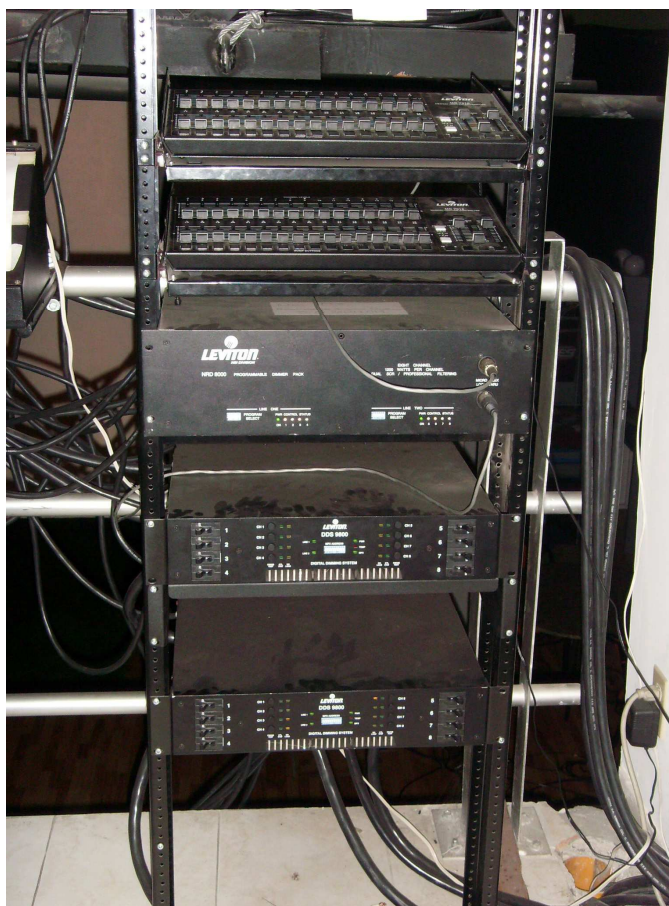
Figura 56. Banco de Dimmers y Cuchillas para controlar el encendido de las Lámparas de los sets.
