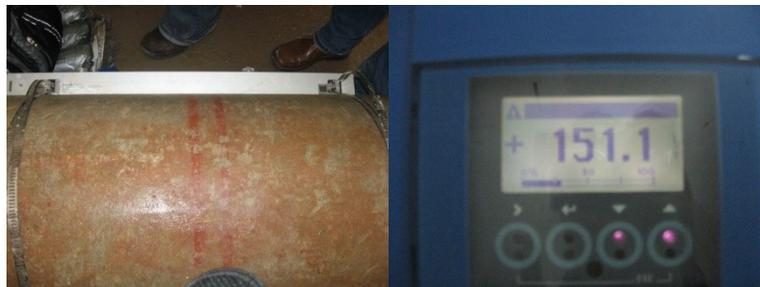
Figura 8. Instalación Medidor de caudal Krohne Optisonic 6300 W
