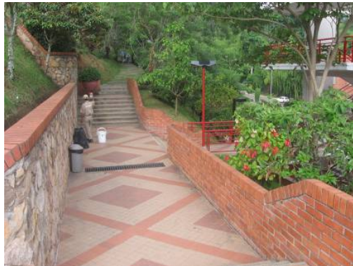
Fotografía 5. Pasillo que comunica el edificio D con el edificio I
