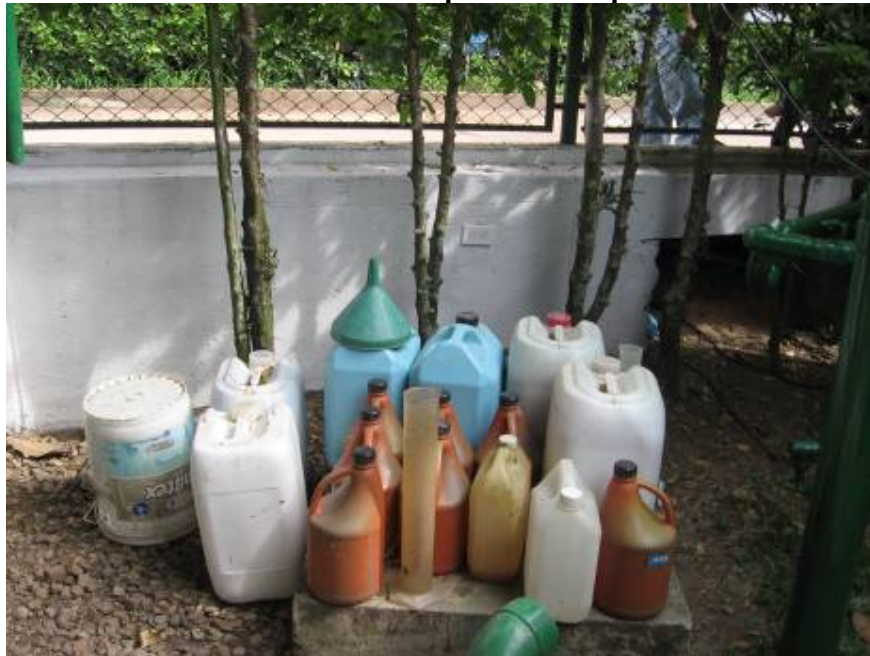
Fotografía 10. Almacenamiento de los productos químicos de la PTAR
