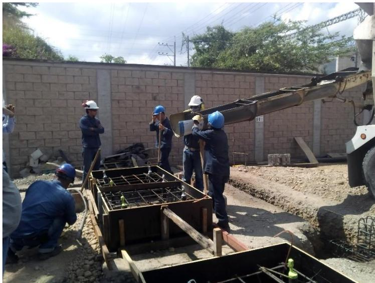
*Ilustración 14 Fundida de cimentación y bases para bombas*
