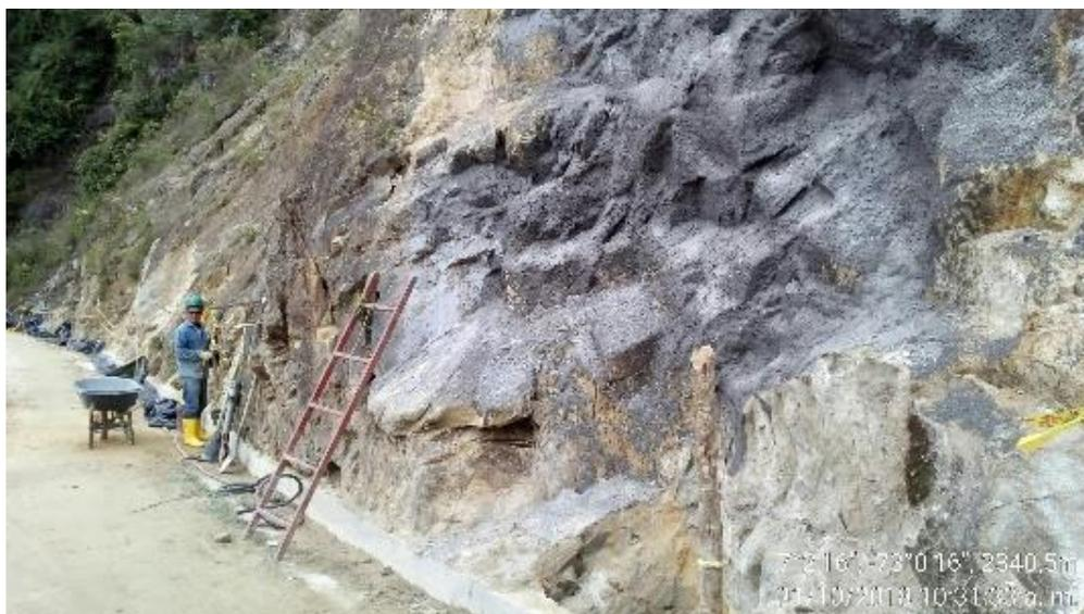
*Ilustración 27 Visita de campo 31 de octubre 2018, Excavaciones para cimentación de trinchos*
