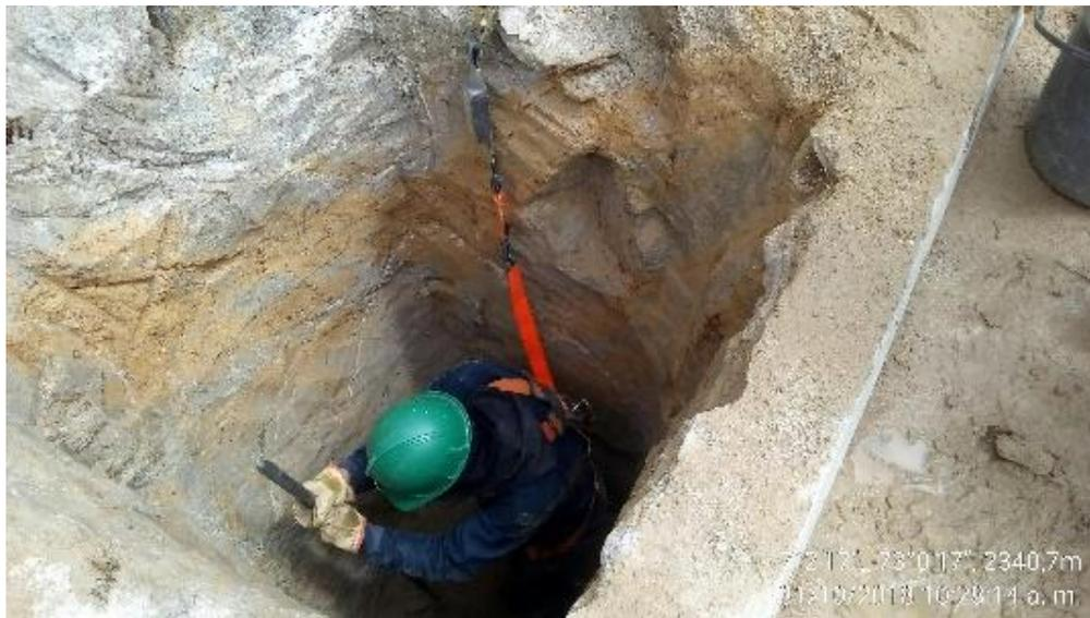
*Ilustración 26 Visita de campo 31 de octubre 2018, Excavaciones para cimentación de trinchos*
