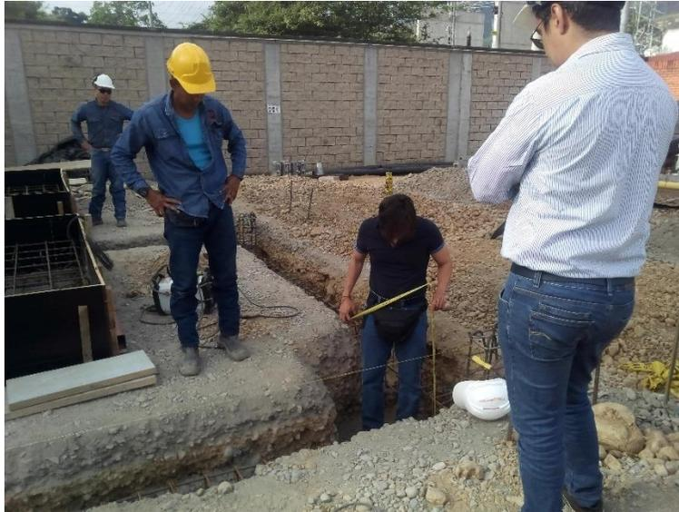
*Ilustración 13 Verificación de dimensiones de zapatas y vigas de cimentación*
