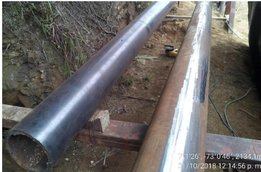
*Ilustración 17 Tubería preparada en campo con nivel de limpieza SP 15 para micropilotes*
