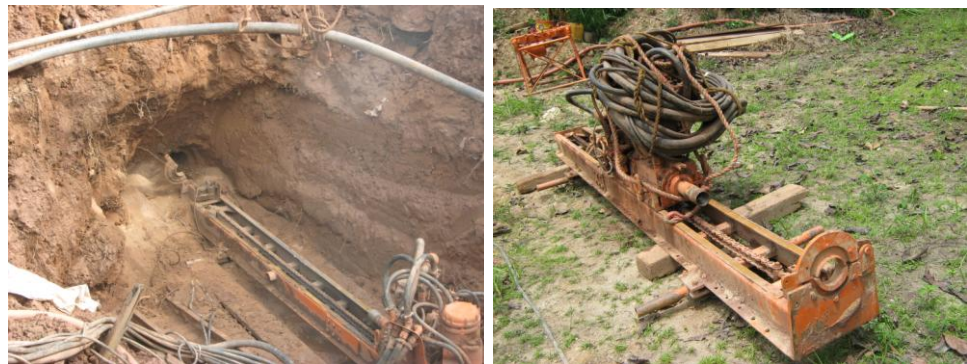
FIGURA 11: Perforacion Horizontal Con Topo
