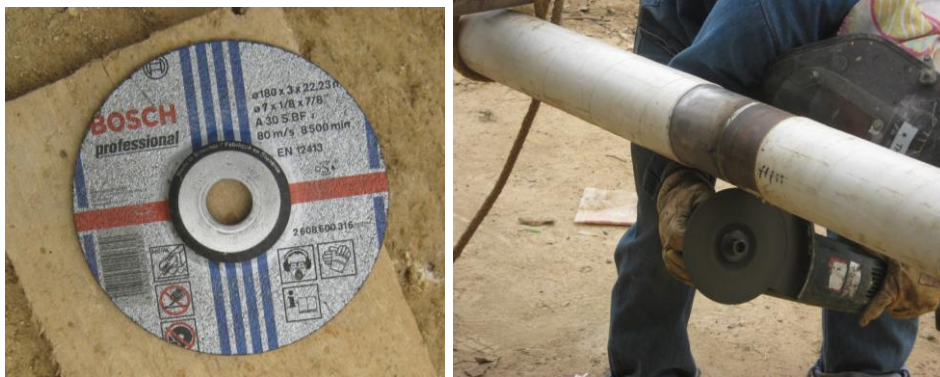
FIGURA 17: Limpieza con disco abrasivo despues del primer pase.
