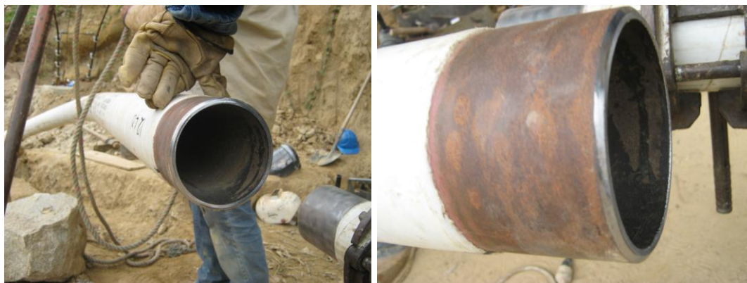
FIGURA 14: Verificación y alistamiento de perfiles para soldadura de juntas.
