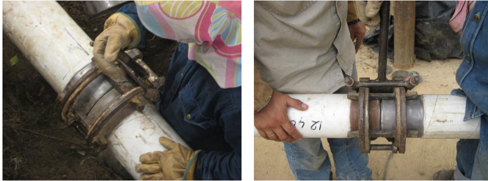
FIGURA 15: Alineamiento de juntas para soldadura
