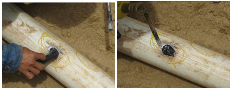
FIGURA 22: Reparación de capa protectora contra la corrosión a la tubería de acero .
