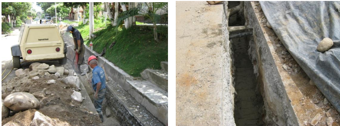
FIGURA 4: Protección del fondo de la zanja para ubicación de tubería.
