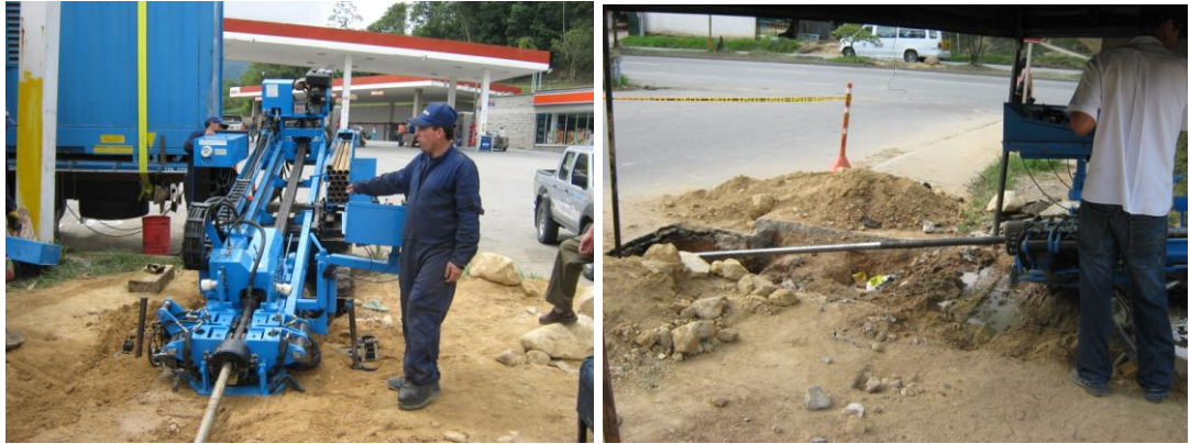
FIGURA 12: Perforacion Horizontal Dirigida
