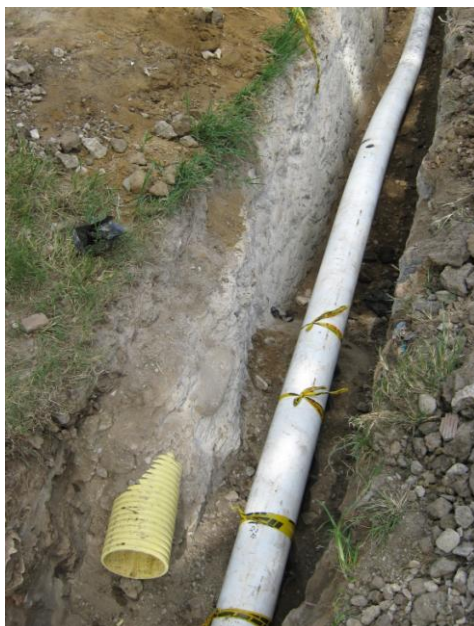
FIGURA 5: Bayoneta a tubería para evasión de obstáculos.
