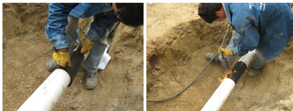
FIGURA 21: Protección de los empalmes realizados.
