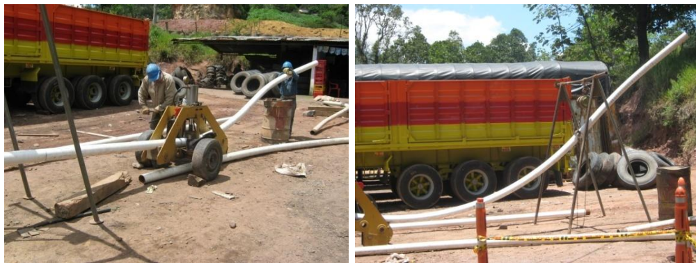
FIGURA 9: Realización de curvas a la tubería.
