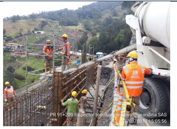
Imagen 96 Vertimiento de concreto para vástago del frente 2
