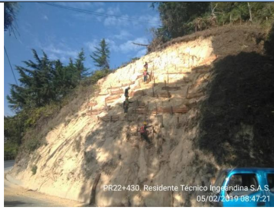
Imagen 62 Construcción de trinchos
