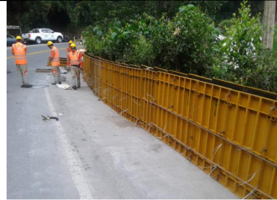
Imagen 55 Formateado de muro - bordillo
