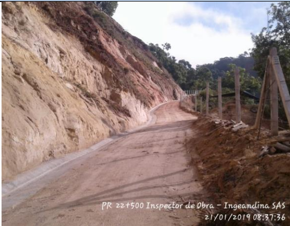
Imagen 64 Construcción de cuneta
