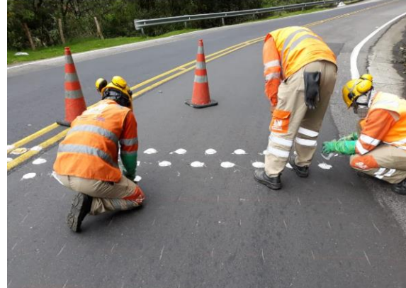
Imagen 42 Instalación de estoperoles
