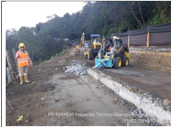
Imagen 101 Proceso de Excavación
