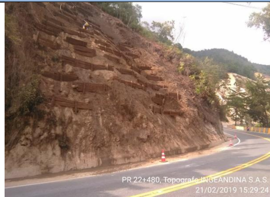
Imagen 63 Aplicación de hidrosiembra
