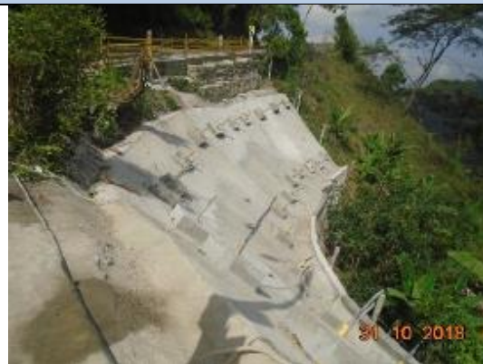
Imagen 53 Vista previa finalización de fundida de la pantalla anclada
