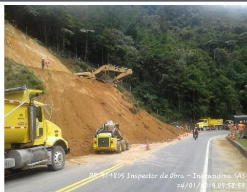
Imagen 80 Conformación de primera terraza
