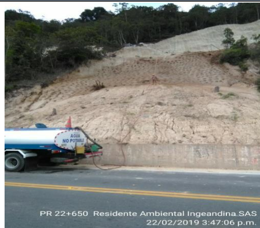
Imagen 75 Riego de material plantado en el talud
