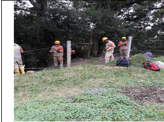
Imagen 48 Cercamiento de predios UF4
