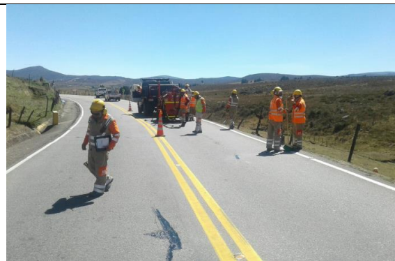
Imagen 45 Actividad de sello fisuras
