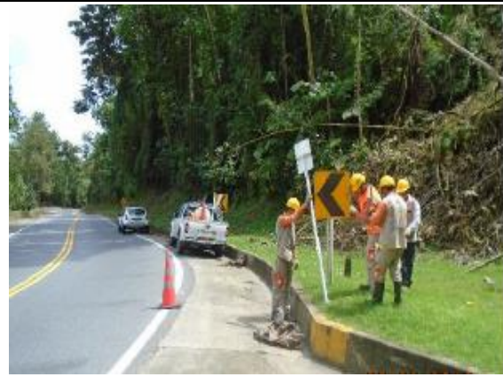
Imagen 38 Instalación y mantenimiento de señales verticales
