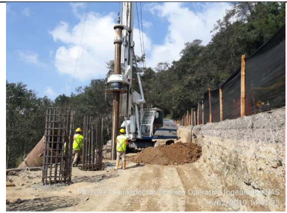
Imagen 102 Perforación de pilotes
