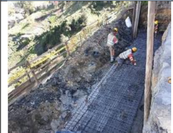
Imagen 89 Acero de refuerzo zarpas frente 1
