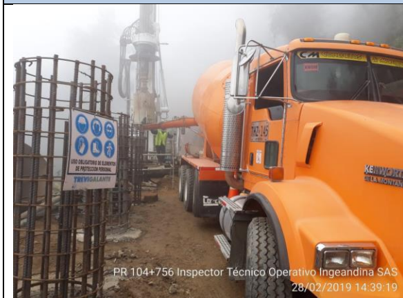
Imagen 103 Fundida de Pilote
