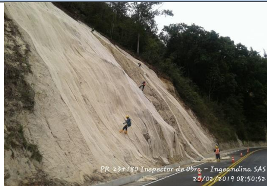
Imagen 78 Instalación de biomanto
