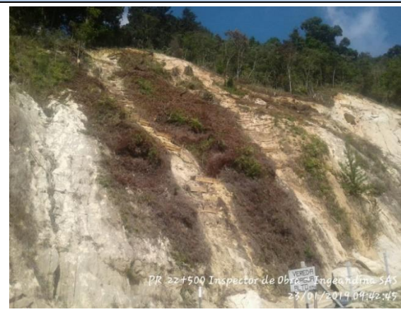
Imagen 65 tala de árboles y construcción de trinchos
