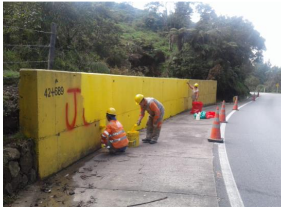
Imagen 41 Demarcación de muros
