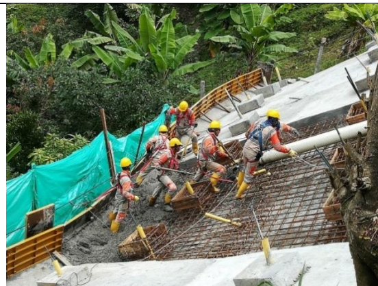
Imagen 51 Fundida de pantalla anclada UF2
