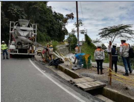
Imagen 52 Fundida de pantalla anclada UF2
