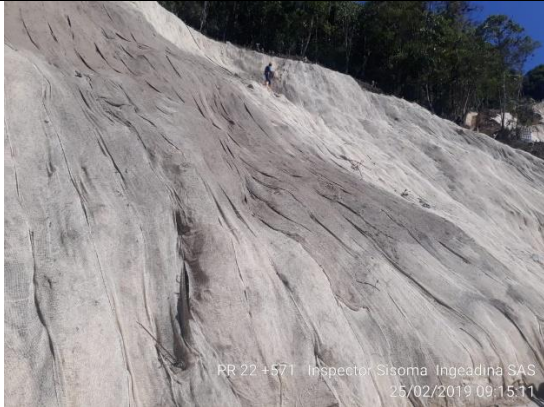
Imagen 66 Instalación de hidrosiembra en biomantos
