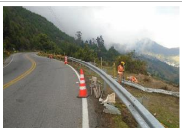
Imagen 34 Mantenimiento y limpieza de defensas metálicas
