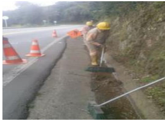
Imagen 36 Mantenimiento y limpieza de drenajes
