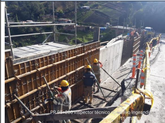
Imagen 95 Instalación de formaleta para los vástagos del frente 2
