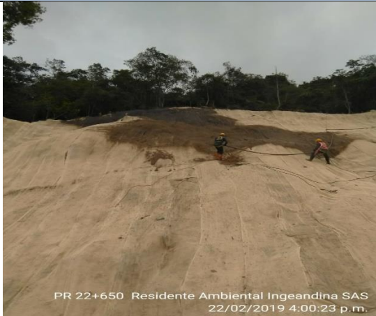
Imagen 74 Proceso de revegetalización de talud con el método de hidrosiembra
