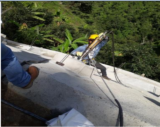
Imagen 56 Tensionamiento de anclajes
