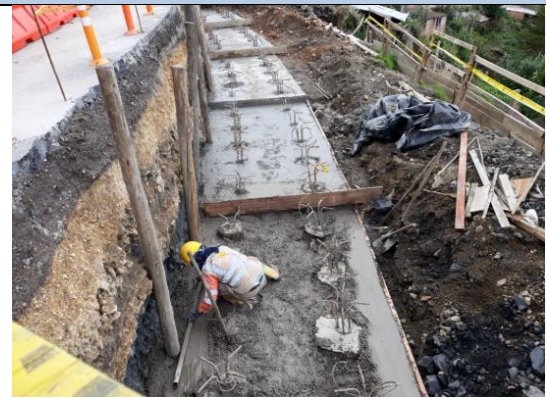
Imagen 88 Fundida de solado frente 1
