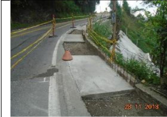
Imagen 54 Construcción de berma-cuneta
