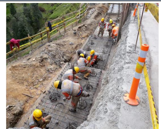
Imagen 90 Acero de refuerzo zarpa frente 2
