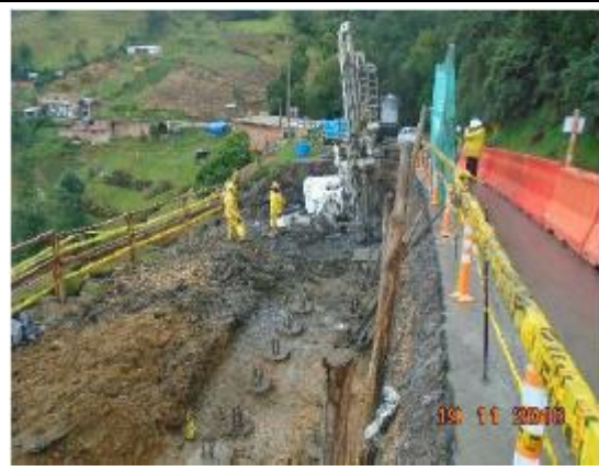
Imagen 86 Perforaciones frente 1 y fundida de micropilotes
