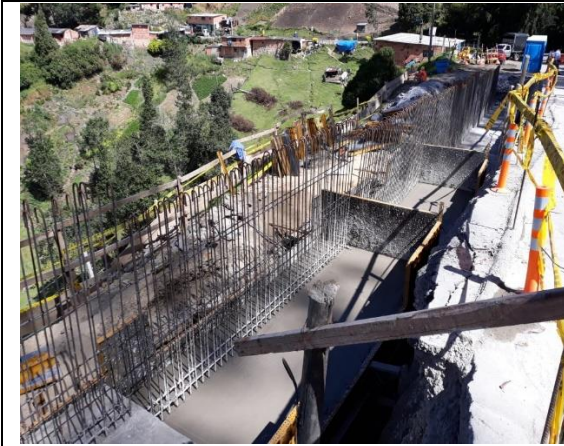
Imagen 91 Vertimiento de concreto para zarpas del frente 2
