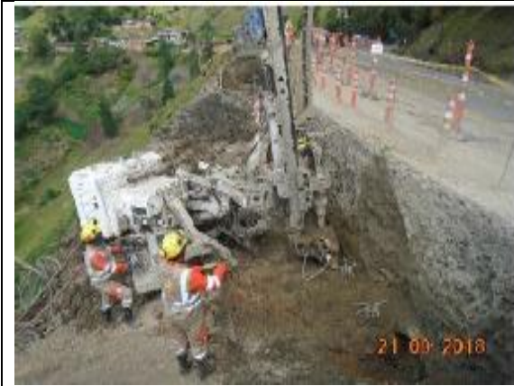
Imagen 85 Perforación de micropilotes frente 1 UF 3
