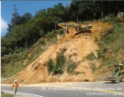
Imagen 79 Excavación de talud
