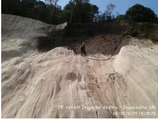
Imagen 72 Procedimiento de hidrosiembra
