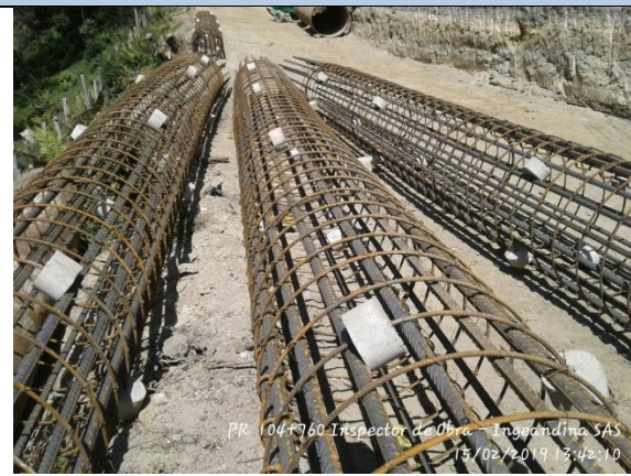
Imagen 104 Acero de refuerzo de los pilotes
