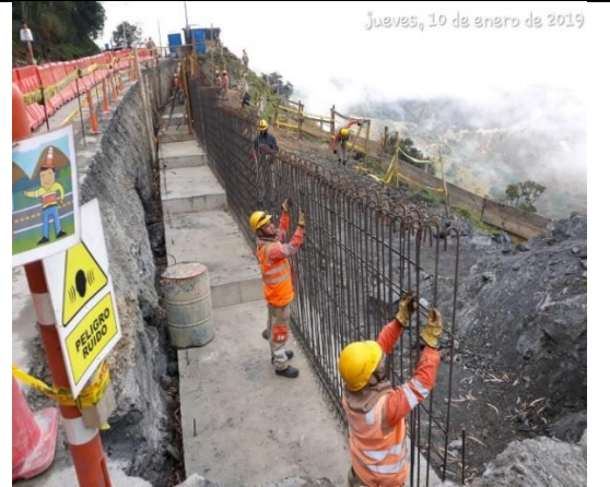
Imagen 92 Instalación de acero de refuerzo de vástagos
