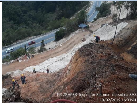
Imagen 76 Instalación de biomanto
