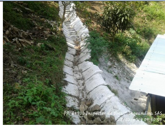
Imagen 57 Construcción de cuneta en sacos de suelo-cemento
