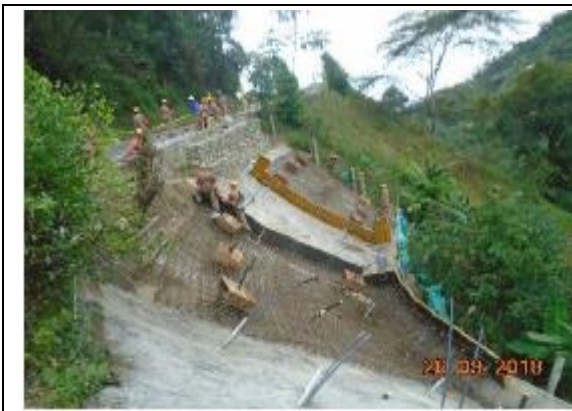
Imagen 50 Armado de acero de refuerzo y formaleta
