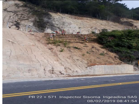
Imagen 67 Construcción de trinchos e instalación de hidrosiembra
