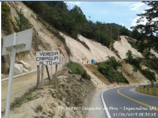
Imagen 70 Sector intervenido con biomanto y posterior instalación de hidrosiembra
