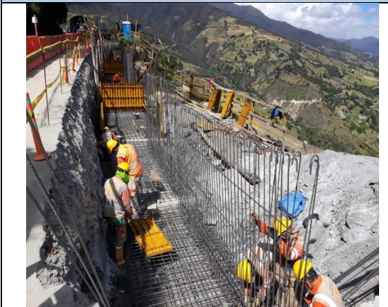
Imagen 93 Instalación de acero de refuerzo y formaleta para las zarpas
