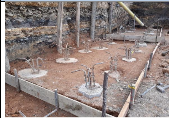
Imagen 87 Formateado de solado frente 1
