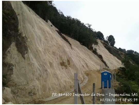
Imagen 73 Finalización de instalación de biomanto
