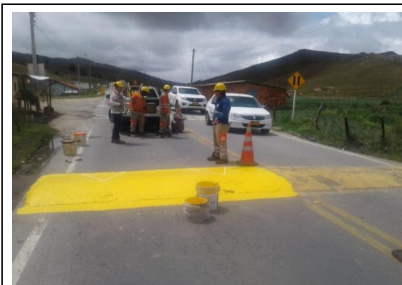
Imagen 33 Demarcación de señalización horizontal
