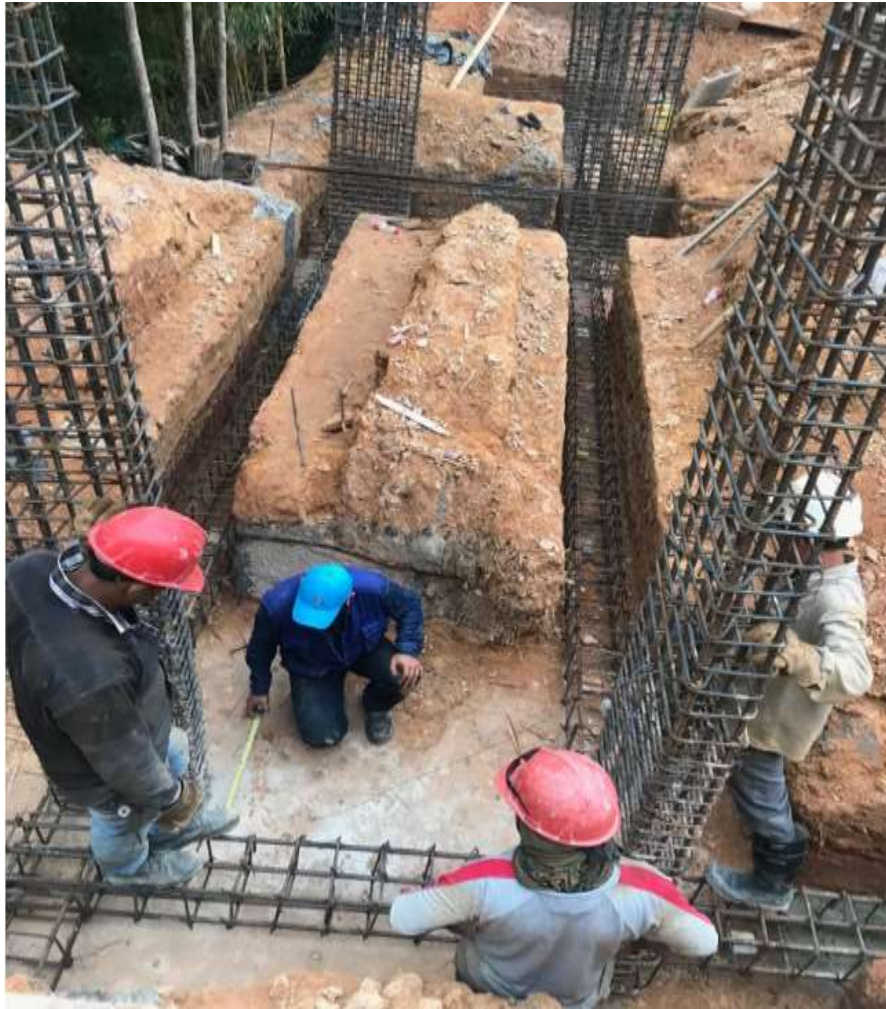
Ilustración 21. Amarre vigas de cimentación y columnas
