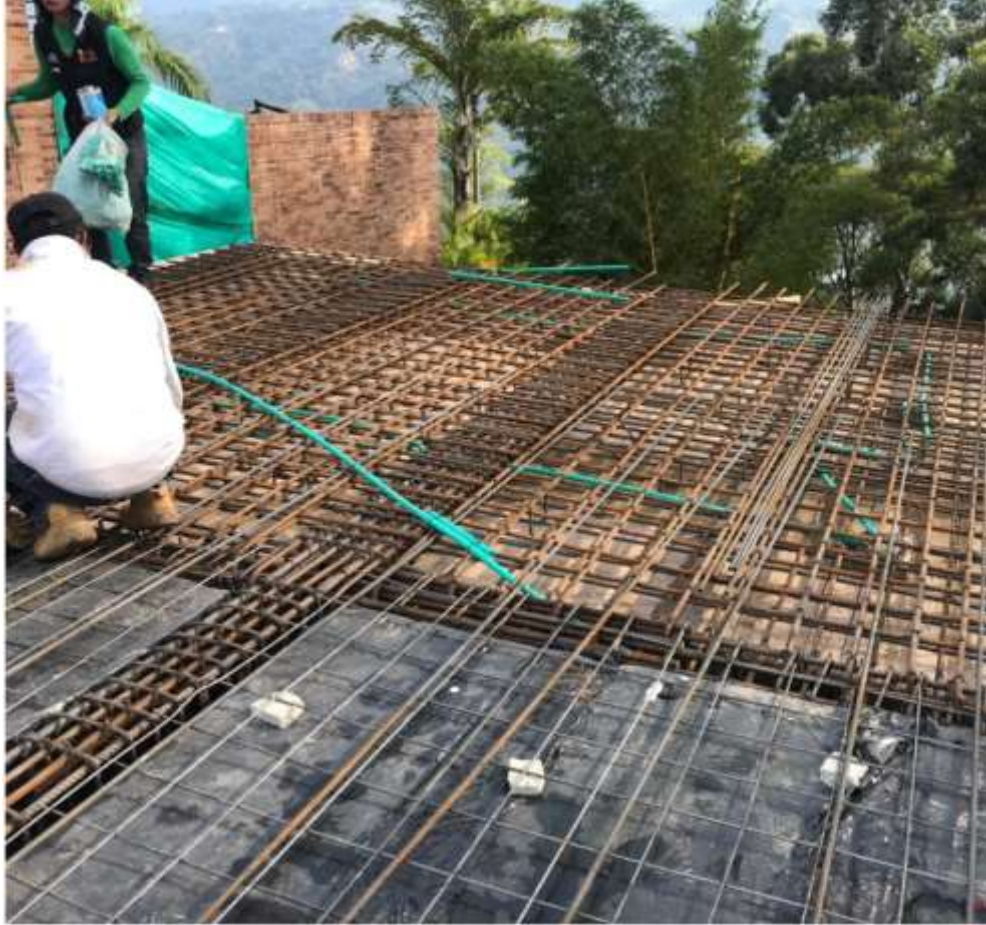
Ilustración 25. Hierros placa volada
