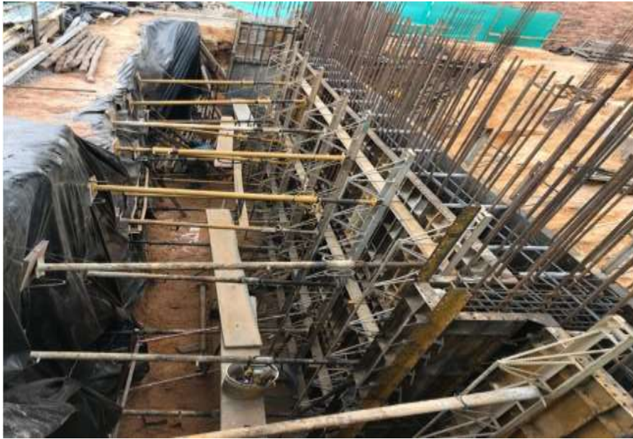
Ilustración 18. Retranque muro de contención
