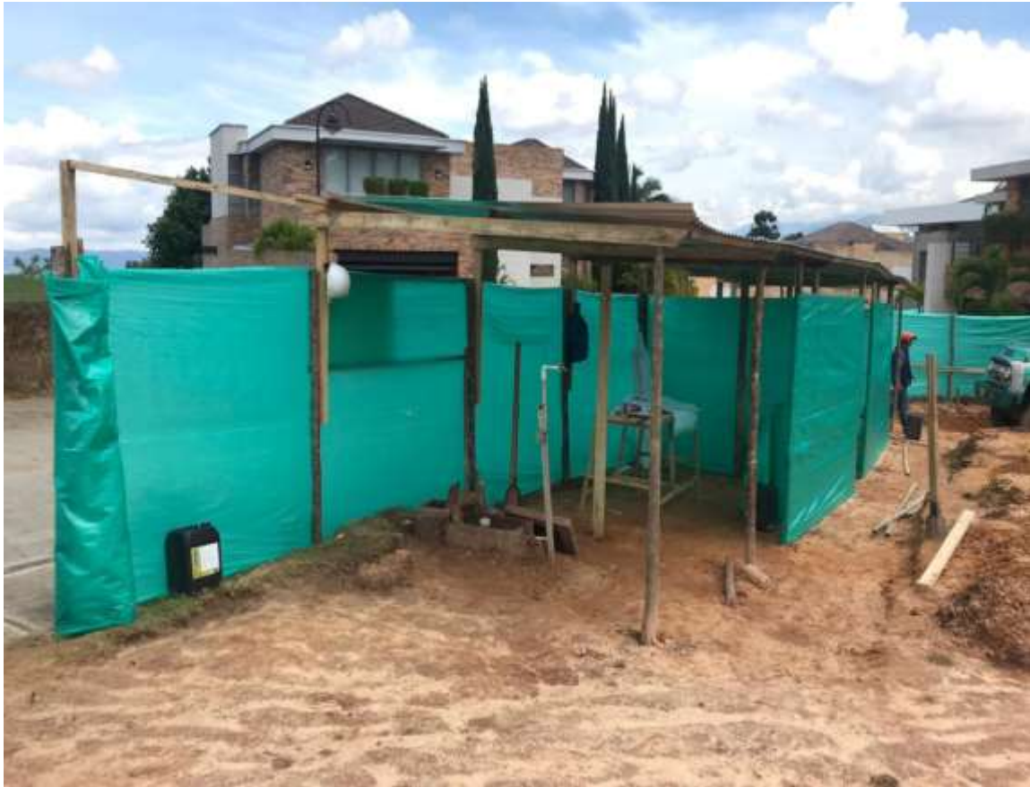
Ilustración 7. Campamento de obra
