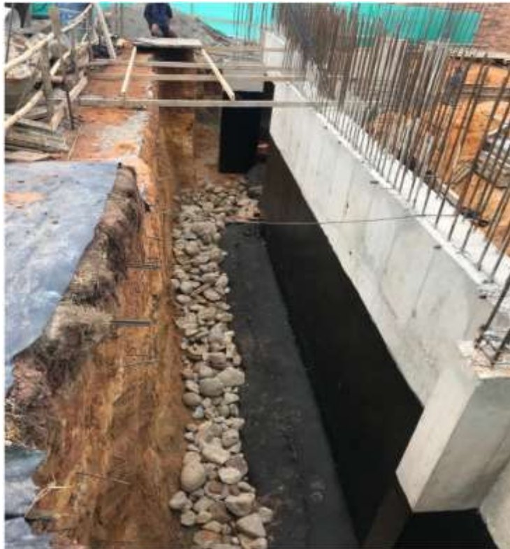
Ilustración 24. Filtro en Geotextil, triturado y piedra
