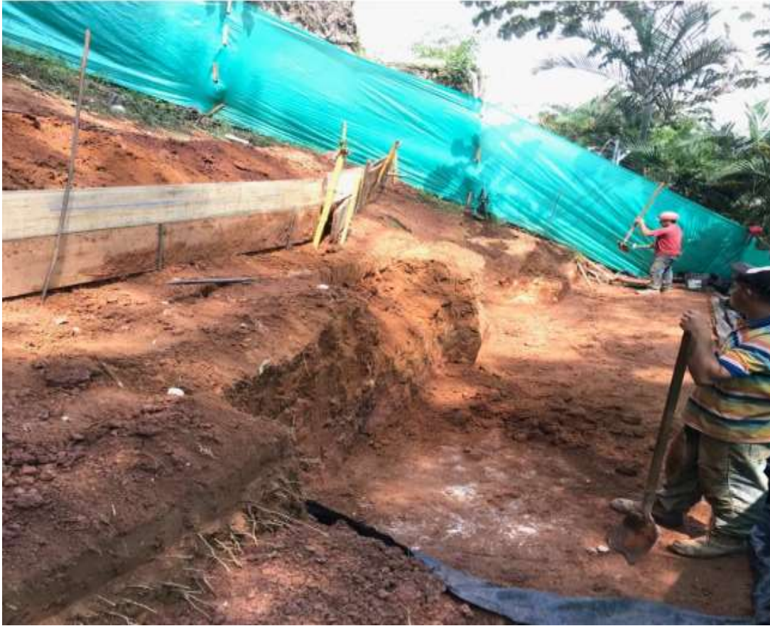
Ilustración 10. Ubicación muro de contención en tierra armada
