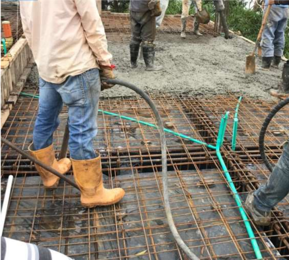
Ilustración 28. Proceso fundida de placa
