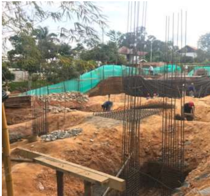
Ilustración 5. Armado de columnas sobre parrillas
