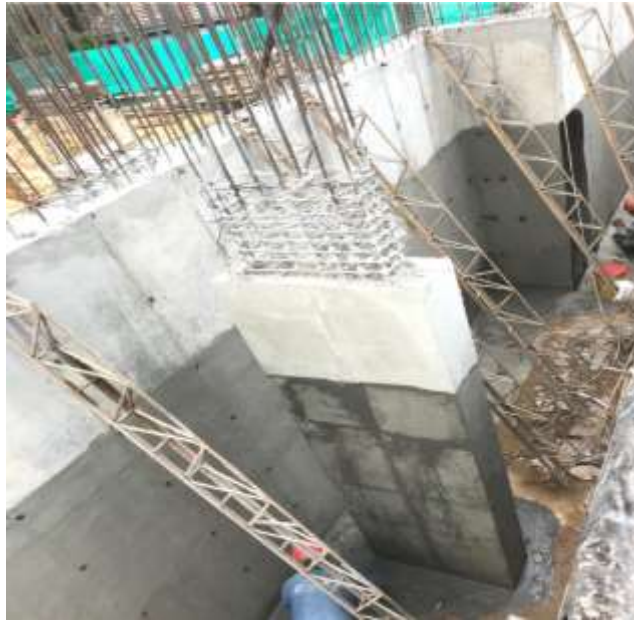
Ilustración 22. Aplicación Sikatop 121
