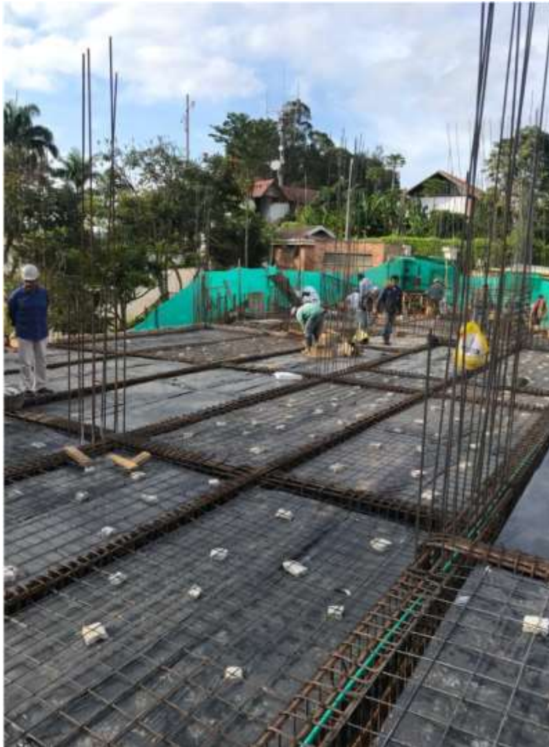
Ilustración 26. Placa aligerada en casetón de icopor
