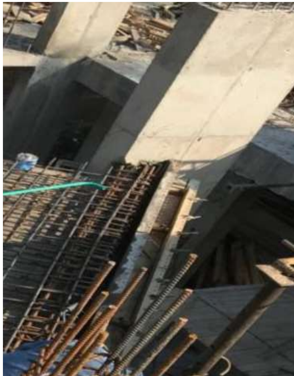
Ilustración 31. Anclajes de una viga a una columna
