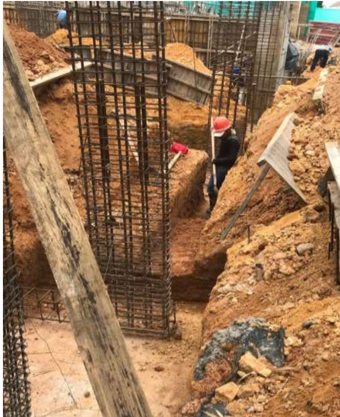
Ilustración 20. Excavación vigas de cimentación
