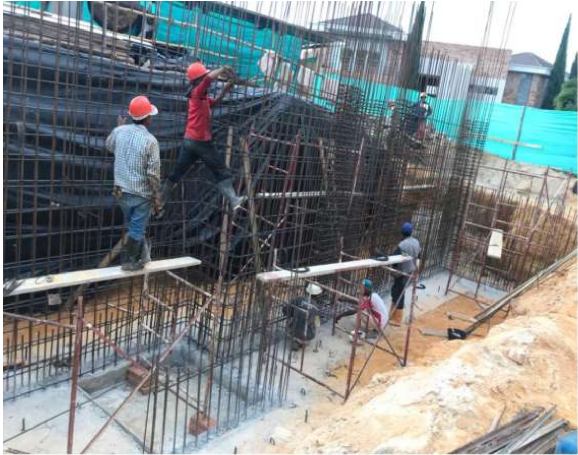
Ilustración 6. Armado de hierros muro de contención
