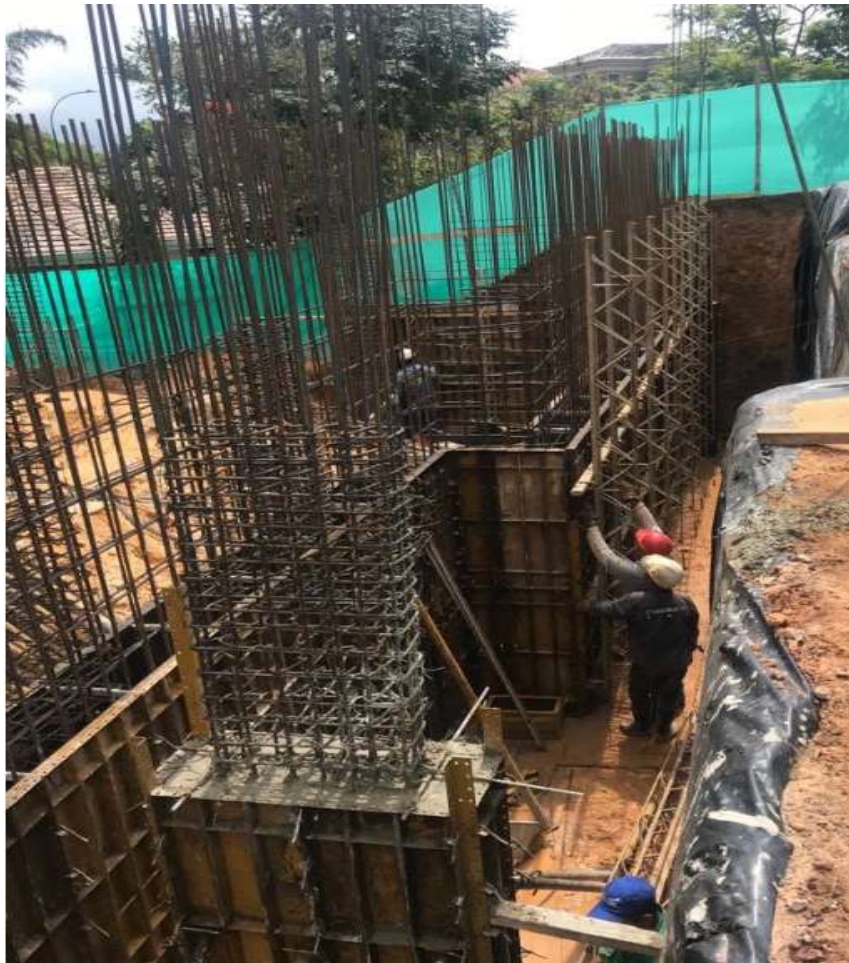
Ilustración 17. Encofrado muro de contención
