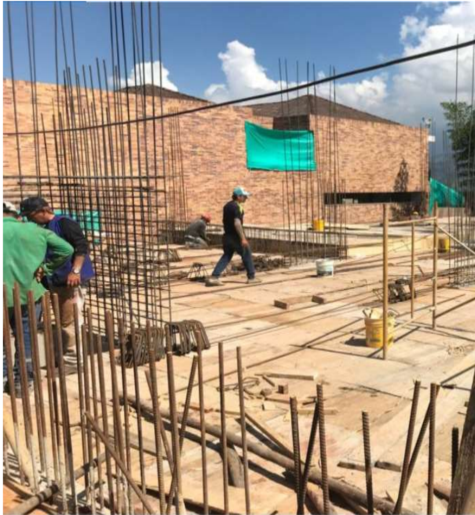
Ilustración 27. Placa armada con tableros de madera
