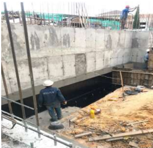
Ilustración 23. Aplicación Emulsión Asfáltica (igol)
