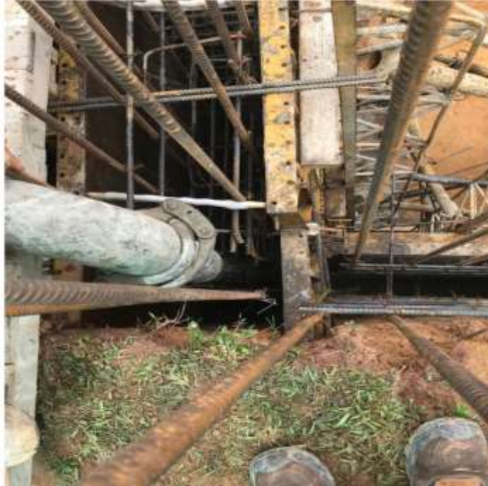
Ilustración 19. Vertimiento de concreto a muro de contención
