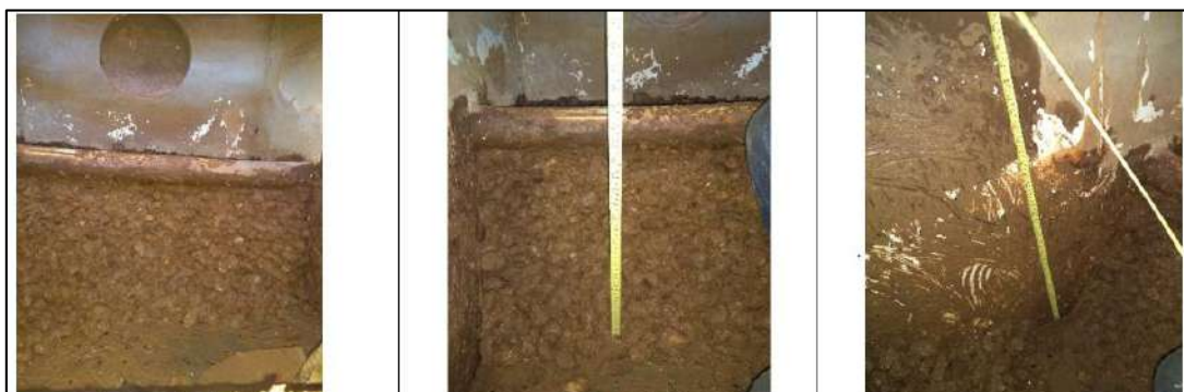
Ilustración 108. Extracción de Grava en el Floculador - Vereda La Aguada Fuente: Propia
