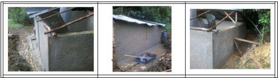
Ilustración 75. Friso Impermeabilizado 2 - Vereda Cerro de la Aurora Fuente: Propia
