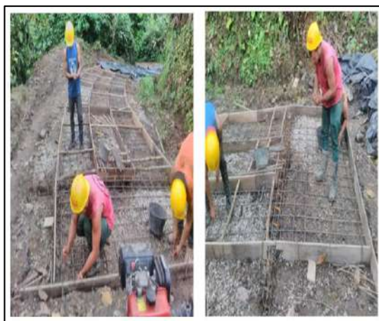
Ilustración 49. Formaleta y Figurado de Acero Rampa – Vereda La Pitala Fuente: Propia
