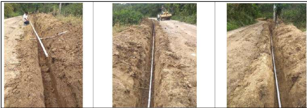
Ilustración 96. Suministro e Instalación Tubería PVC 1 1/2" E.L. RDE 21 3 - Vereda Aguirre Bajo Fuente: Propia
