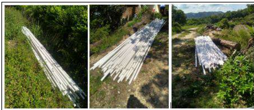
Ilustración 30. Acopio de Material - Vereda Aguirre Bajo Fuente: Propia
