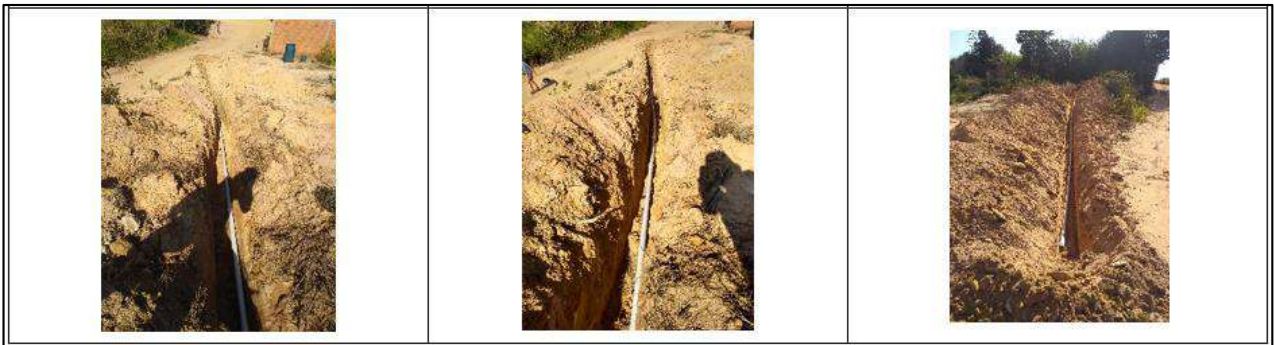
Ilustración 136. Suministro e instalación Tubería PVC 2" 2 – Vereda El Oso Fuente: Propia
