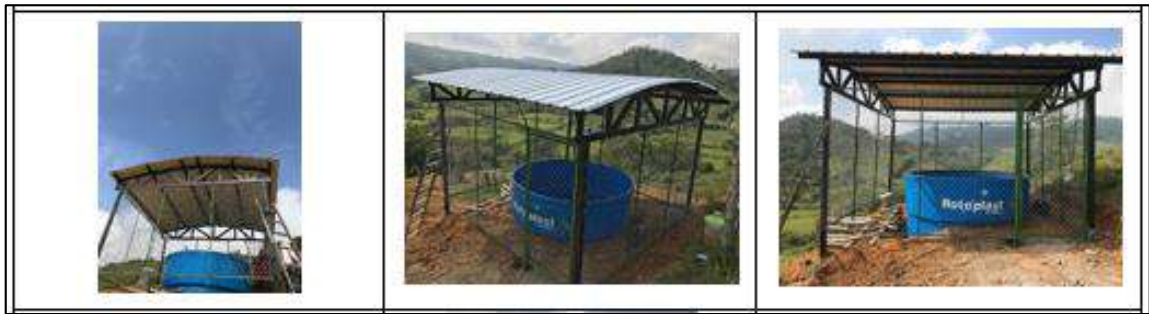
Ilustración 86. Suministro, Instalación y Cubierta Tanque 10.000 lts - Vereda San Joaquín Fuente: Propia
