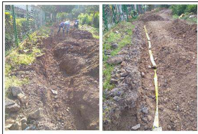
Ilustración 161. Relleno con Material Común - Corregimiento Santo Domingo El Ramo Fuente: Propia
