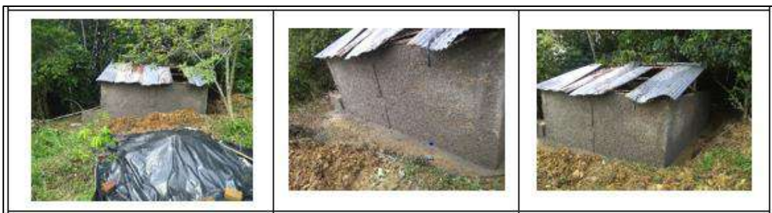
Ilustración 73. Friso Impermeabilizado - Vereda Cerro de la Aurora Fuente: Propia
