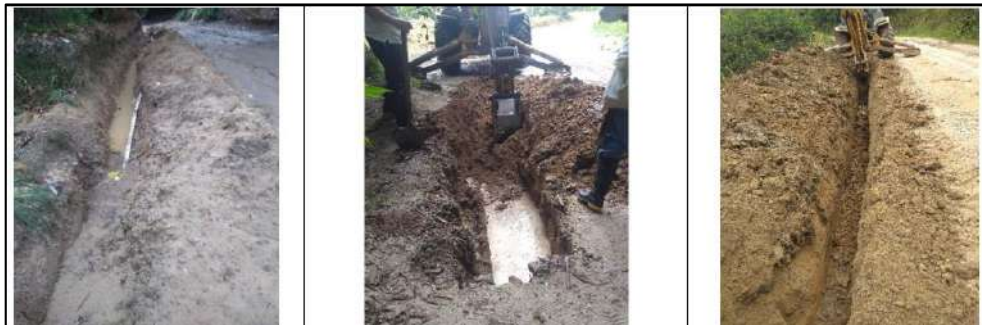
Ilustración 90. Excavaciones en Material Común 2 - Vereda Aguirre Bajo Fuente: Propia
