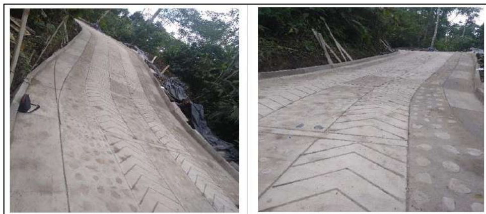
Ilustración 187. Placa Huella (Resultado Final) – Primera Etapa Fuente: Propia
