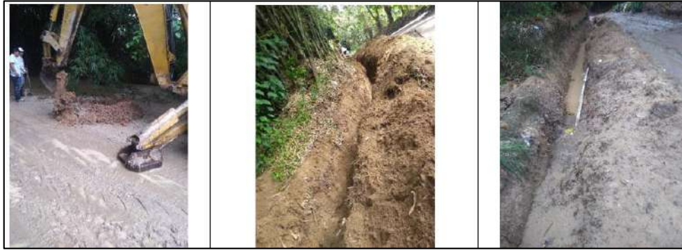
Ilustración 89. Excavaciones en Material Común 1 - Vereda Aguirre Bajo Fuente: Propia
