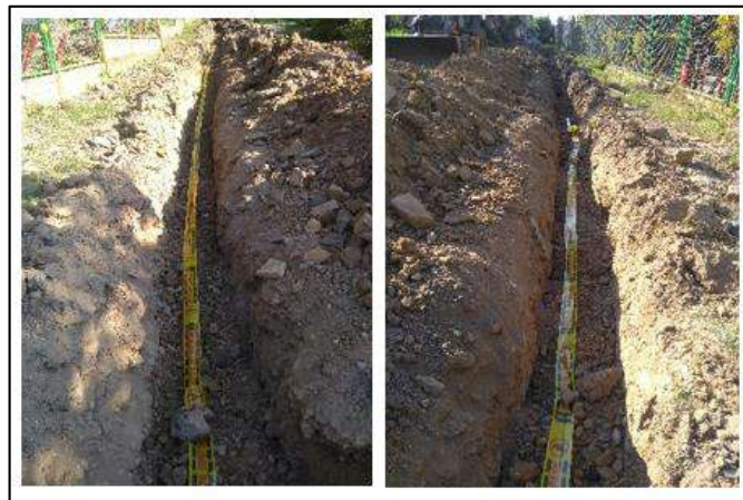
Ilustración 162. Relleno con Material Común 1 - Corregimiento Santo Domingo El Ramo Fuente: Propia
