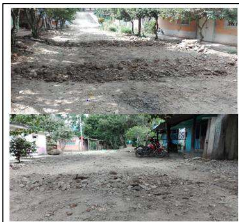
Ilustración 166. Relleno con Material Común 5 - Corregimiento Santo Domingo El Ramo Fuente: Propia
