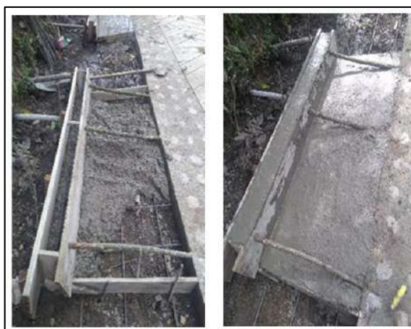
Ilustración 57. Fundida Cunetas – Vereda La Pitala Fuente: Propia
