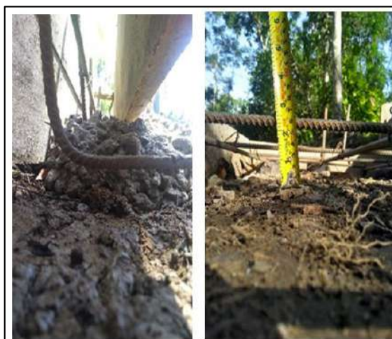
Ilustración 58. Medición Acero Cunetas – Vereda La Pitala Fuente: Propia
