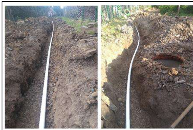
Ilustración 151. Instalación Tubería PVC 2" U.M. 2 - Corregimiento Santo Domingo El Ramo Fuente: Propia
