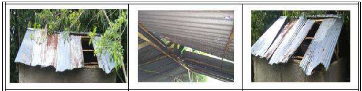
Ilustración 80. Caseta Tanque Almacenamiento - Vereda Cerro de la Aurora Fuente: Propia
