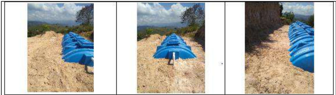
Ilustración 128. Suministro e instalación de tanque (30.000 lts) 5 - Vereda El Oso Fuente: Propia
