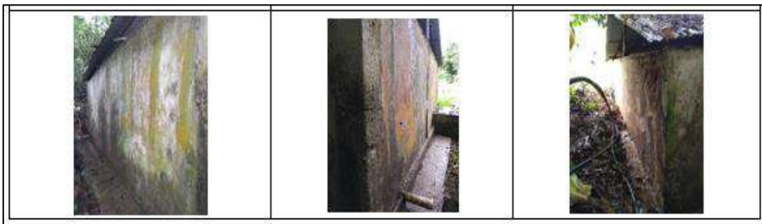
Ilustración 72. Demolición Friso Existente 2 - Vereda Cerro de la Aurora Fuente: Propia
