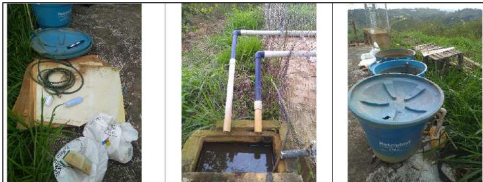
Ilustración 105. Desmonte Equipos - Vereda La Aguada Fuente: Propia
