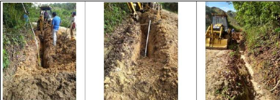
Ilustración 91. Excavaciones en Material Común 3 - Vereda Aguirre Bajo Fuente: Propia
