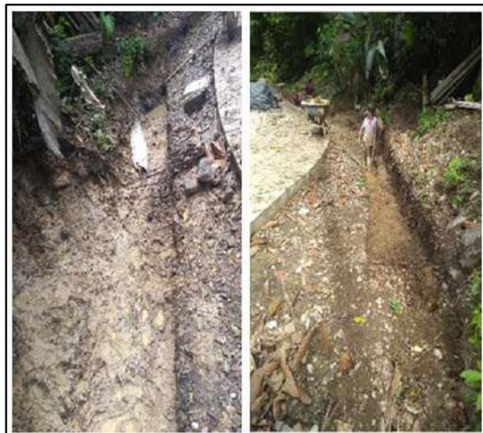
Ilustración 64. Excavación en Roca – Filtro – Vereda La Pitala Fuente: Propia
