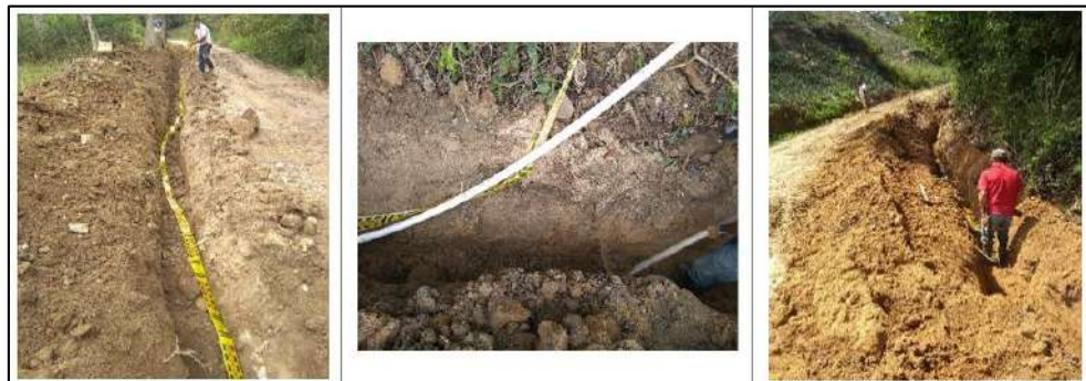
Ilustración 98. Suministro e Instalación Tubería PVC 1 1/2" E.L. RDE 21 5 - Vereda Aguirre Bajo Fuente: Propia
