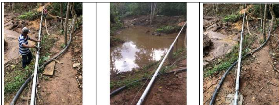
Ilustración 121. Adecuaciones de la Comunidad - Instalación de Tubería de Succión - Vereda Altos de Palo Negro Fuente: Propia
