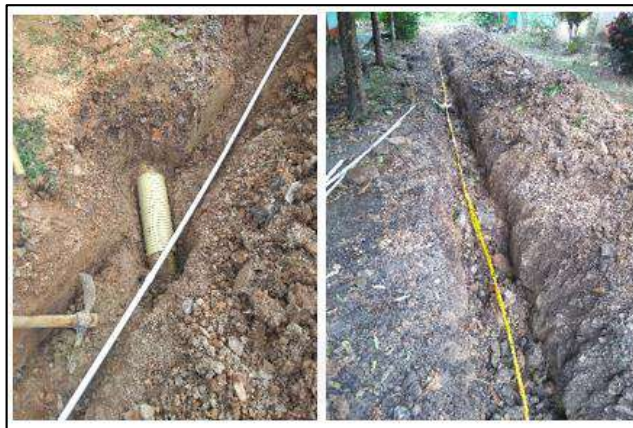
Ilustración 157. Instalación Tubería PVC 1" U.M. 2 - Corregimiento Santo Domingo El Ramo Fuente: Propia
