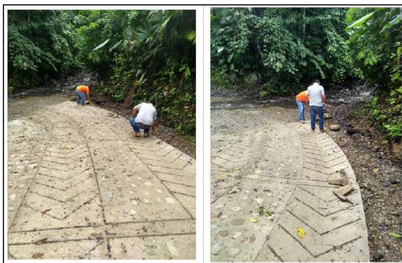
Ilustración 177. Visita de Inspección – Proyecto N°1 Fuente: Propia
