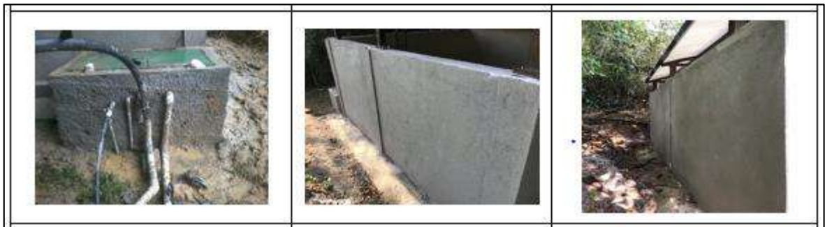
Ilustración 77. Friso Impermeabilizado 4 - Vereda Cerro de la Aurora Fuente: Propia
