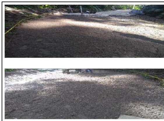
Ilustración 44. Colocación del Material Afirmado – Vereda La Pitala Fuente: Propia
