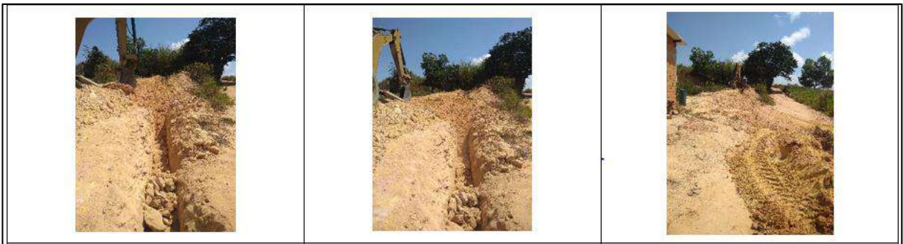
Ilustración 138. Relleno en Material Común – Vereda El Oso Fuente: Propia
