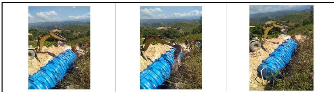
Ilustración 132. Excavaciones en Material Común 1 - Vereda El Oso Fuente: Propia
