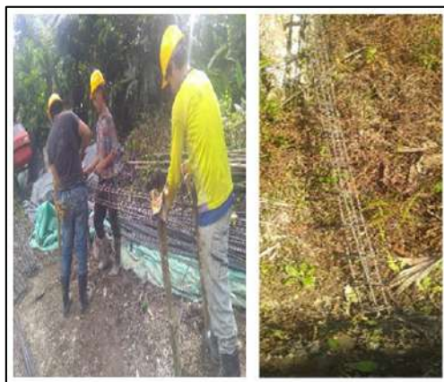
Ilustración 38. Figurado de Acero (Amarre) – Vereda La Pitala Fuente: Propia
