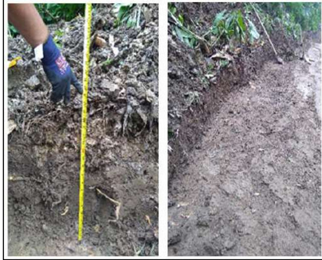
Ilustración 40. Excavaciones en Roca – Vereda La Pitala Fuente: Propia
