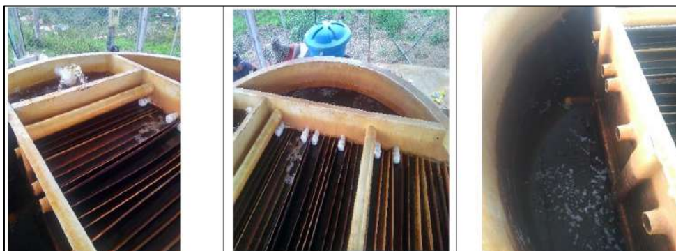
Ilustración 116. Funcionamiento del Tanque - Vereda La Aguada Fuente: Propia
