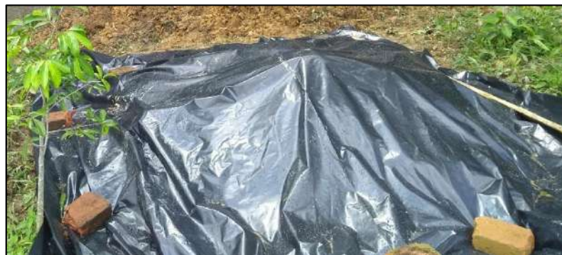
Ilustración 29. Protección de Material - Vereda Cerro de la Aurora Fuente: Propia
