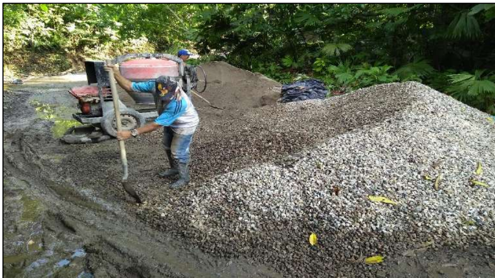
Ilustración 27. Acopio de Material (Triturado y Arena) – Segunda Etapa Fuente: Propia
