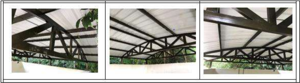
Ilustración 82. Caseta Tanque Almacenamiento 2 - Vereda Cerro de la Aurora Fuente: Propia
