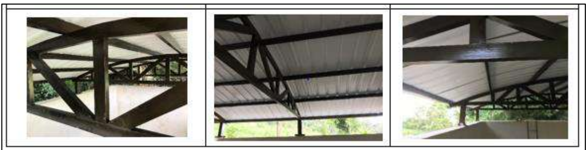
Ilustración 81. Caseta Tanque Almacenamiento 1 - Vereda Cerro de la Aurora Fuente: Propia
