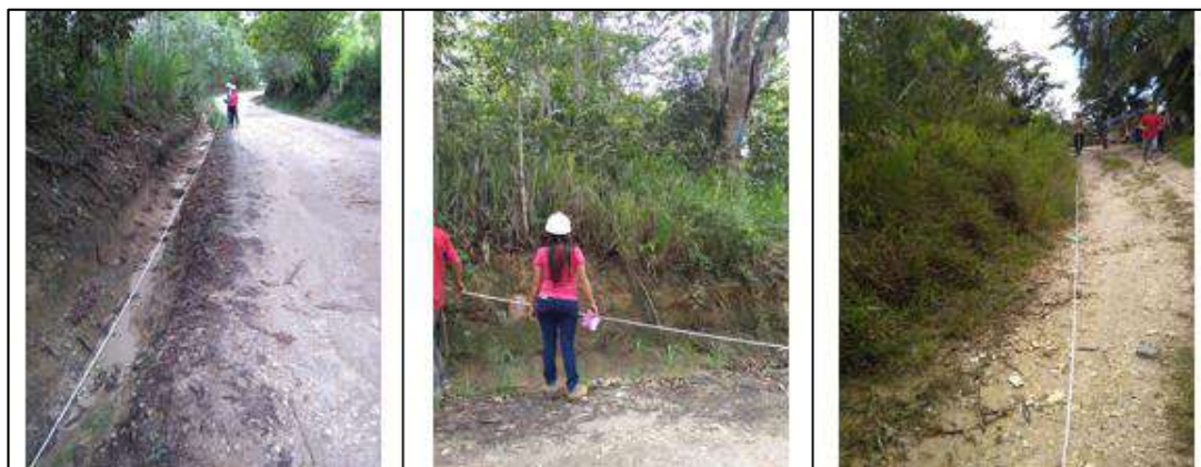
Ilustración 178. Visita de Inspección – Vereda Aguirre Bajo Fuente: Propia
