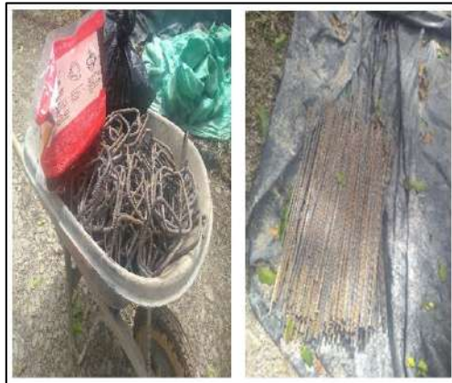
Ilustración 37. Figurado de Acero (Corte) – Vereda La Pitala Fuente: Propia
