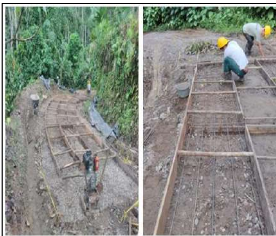
Ilustración 47. Formaleta para Huellas – Vereda La Pitala Fuente: Propia
