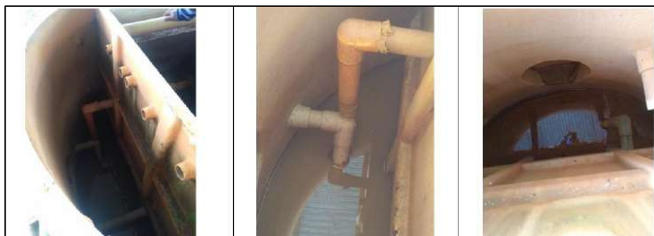
Ilustración 107. Limpieza Interna del Tanque - Vereda La Aguada Fuente: Propia
