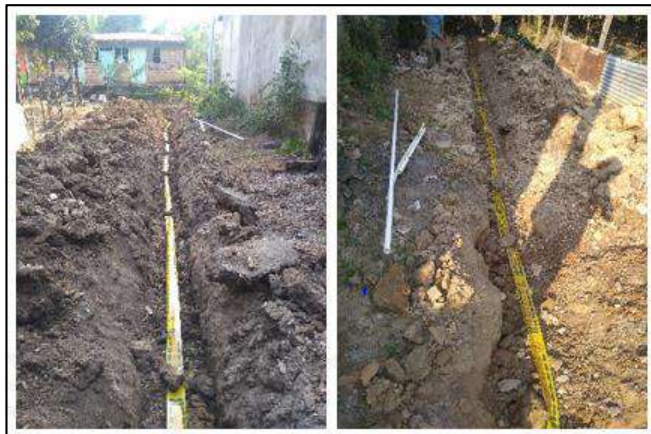
Ilustración 158. Instalación Tubería PVC 1" U.M.3 - Corregimiento Santo Domingo El Ramo Fuente: Propia
