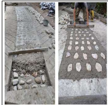
Ilustración 60. Adecuación Piedra Placa Centro– Vereda La Pitala Fuente: Propia
