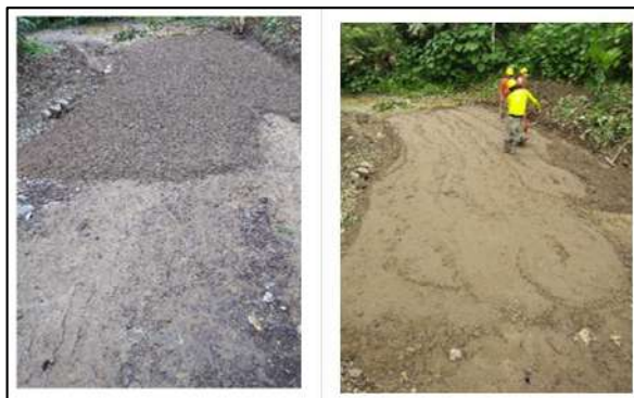
Ilustración 45. Compactación del Material Afirmado – Vereda La Pitala Fuente: Propia
