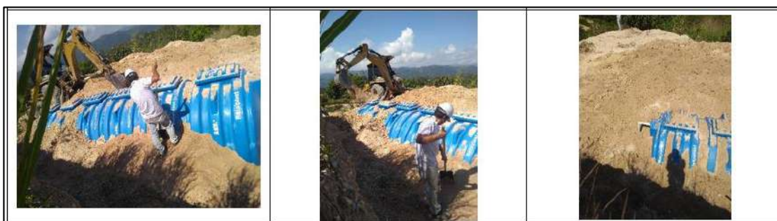
Ilustración 133. Excavaciones en Material Común 2 - Vereda El Oso Fuente: Propia
