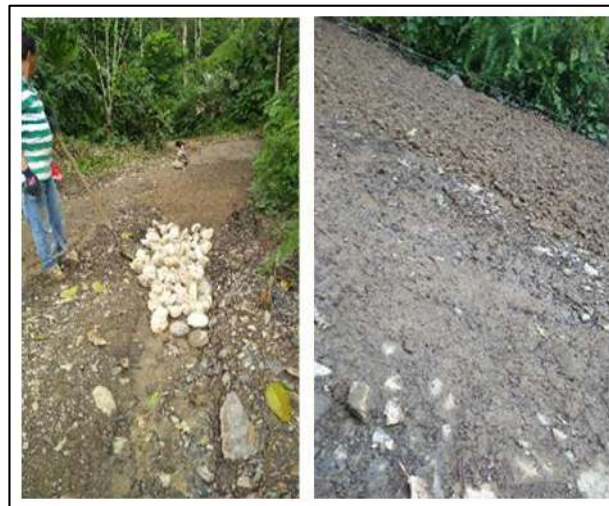
Ilustración 43. Relleno con Material Común – Vereda La Pitala Fuente: Propia
