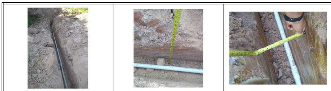
Ilustración 134. Suministro e instalación Tubería PVC 2" – Vereda El Oso Fuente: Propia
