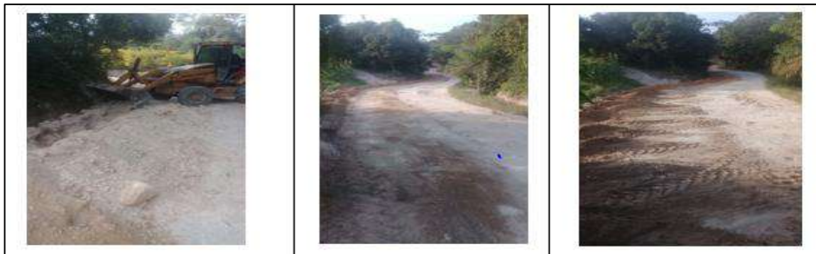
Ilustración 192. Recibo de Obra - Vereda Aguirre Bajo Fuente: Propia
