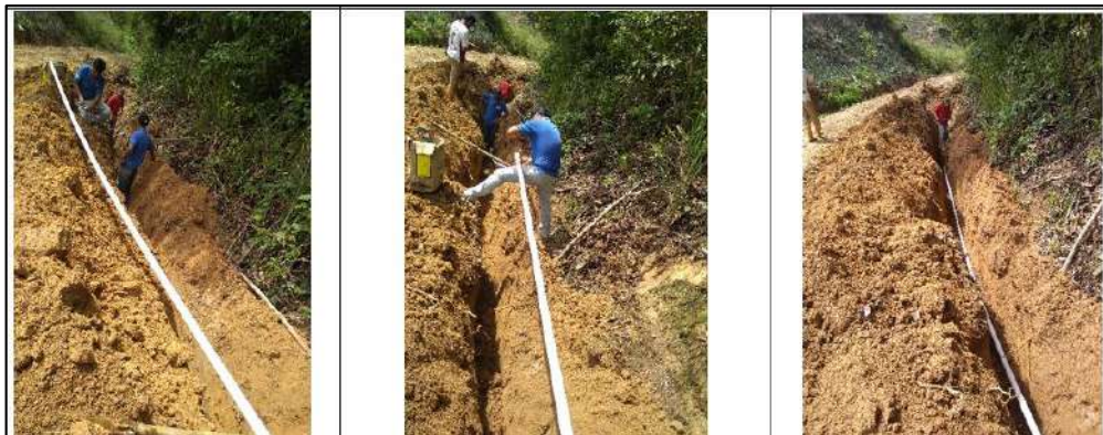
Ilustración 99. Suministro e Instalación Tubería PVC 1 1/2" E.L. RDE 21 6 - Vereda Aguirre Bajo Fuente: Propia
