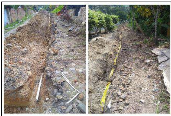
Ilustración 163. Relleno con Material Común 2 - Corregimiento Santo Domingo El Ramo Fuente: Propia
