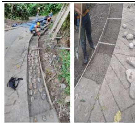
Ilustración 61. Fundida Sobrancho Tramos Curva – Vereda La Pitala Fuente: Propia
