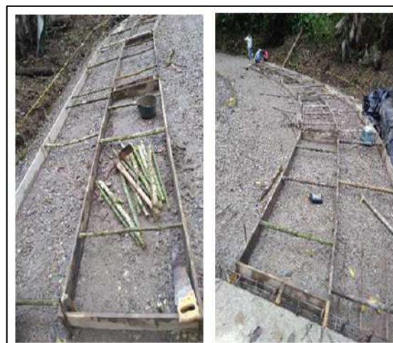
Ilustración 53. Formaleta Placa Centro y Sobreanchos– Vereda La Pitala Fuente: Propia
