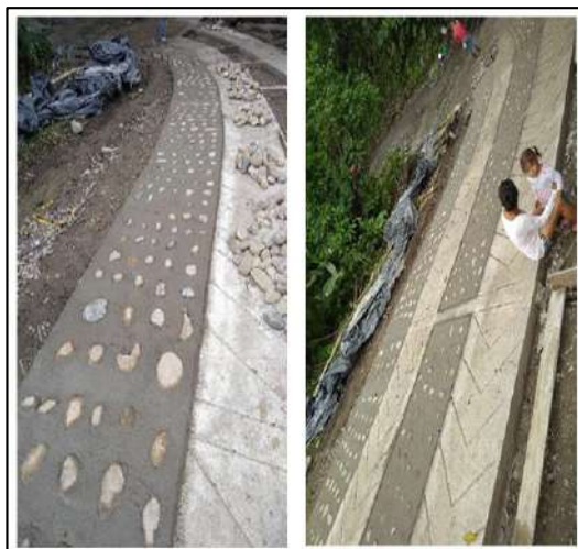
Ilustración 62. Fundida Sobreancho Tramo Recto – Vereda La Pitala Fuente: Propia
