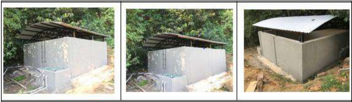
Ilustración 190. Recibo de Obra - Vereda Cerro de la Aurora Fuente: Propia
