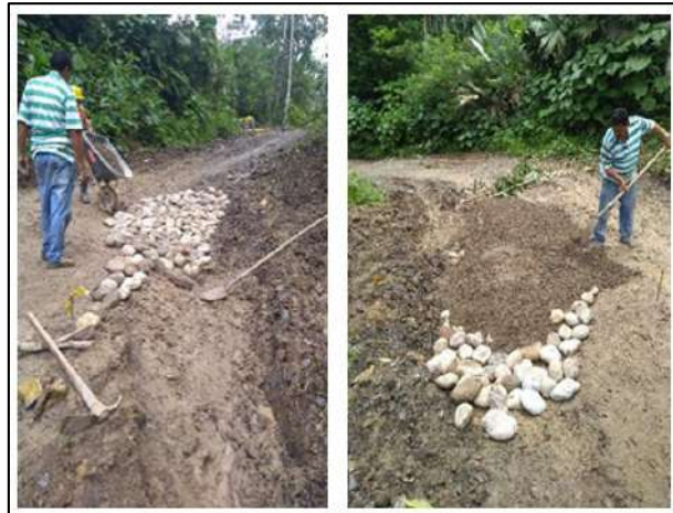
Ilustración 42. Relleno con Roca – Vereda La Pitala Fuente: Propia
