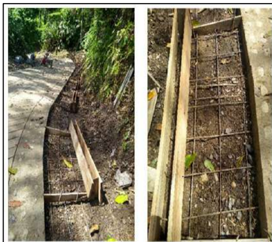
Ilustración 51. Formaleta y Figurado de Acero Cunetas – Vereda La Pitala Fuente: Propia
