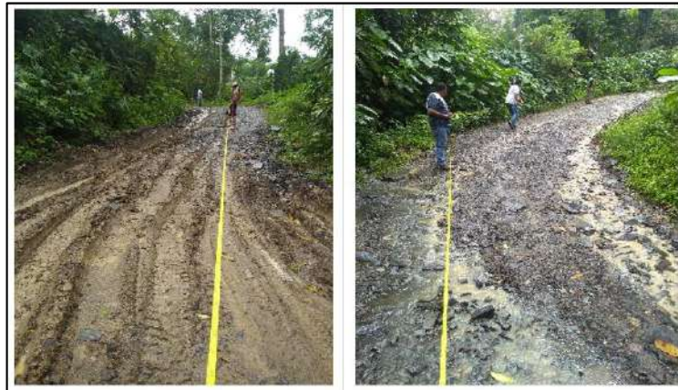
Ilustración 36. Localización y Replanteo – Vereda La Pitala Fuente: Propia
