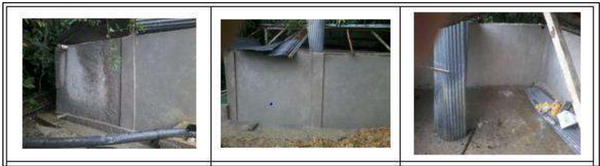
Ilustración 76. Friso Impermeabilizado 3 - Vereda Cerro de la Aurora Fuente: Propia
