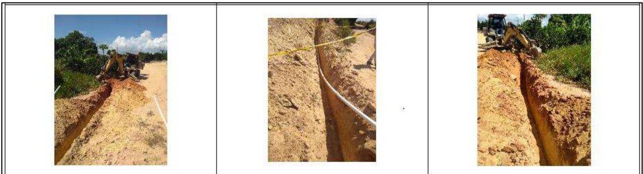
Ilustración 137. Suministro e instalación Tubería PVC 2" 3 – Vereda El Oso Fuente: Propia
