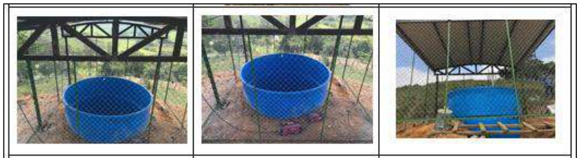
Ilustración 88. Suministro, Instalación y Cubierta Tanque 10.000 lts 2 - Vereda San Joaquín Fuente: Propia
