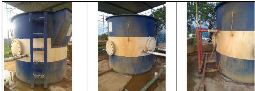
Ilustración 104. Estado Inicial Tanque de Almacenamiento - Vereda La Aguada Fuente: Propia
