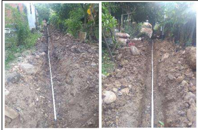
Ilustración 155. Instalación Tubería PVC 1" U.M. - Corregimiento Santo Domingo El Ramo Fuente: Propia
