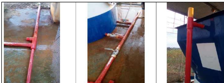
Ilustración 111. Remodelación Tubería Conexión Tanque 1 - Vereda La Aguada Fuente: Propia
