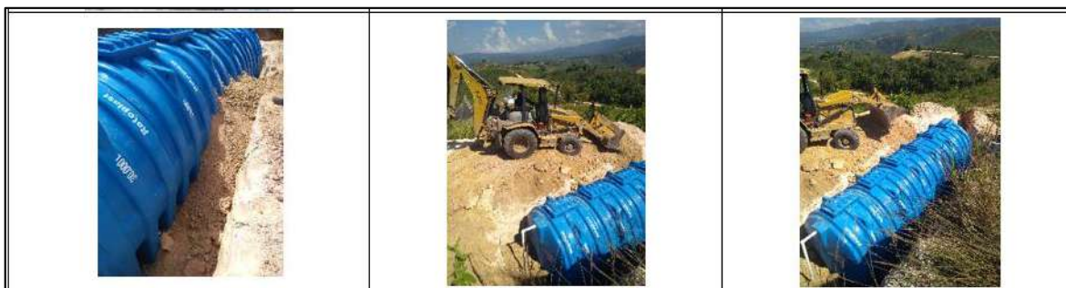
Ilustración 131. Excavaciones en Material Común - Vereda El Oso Fuente: Propia
