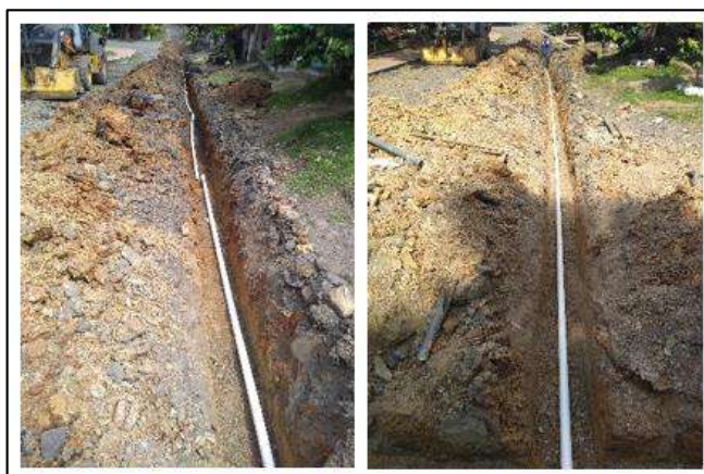
Ilustración 153. Instalación Tubería PVC 2" U.M. 4 - Corregimiento Santo Domingo El Ramo Fuente: Propia
