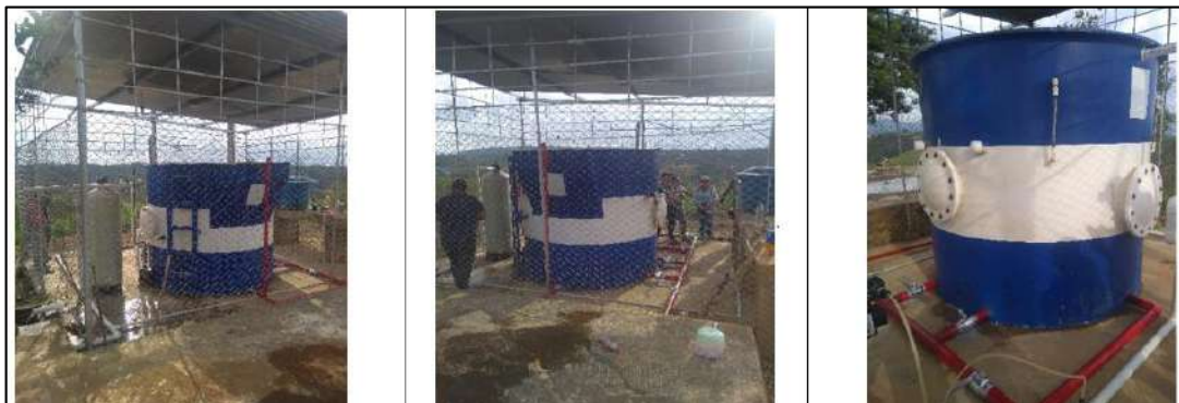
Ilustración 194. Estado Final Mantenimiento PTAP Fuente: Propia
