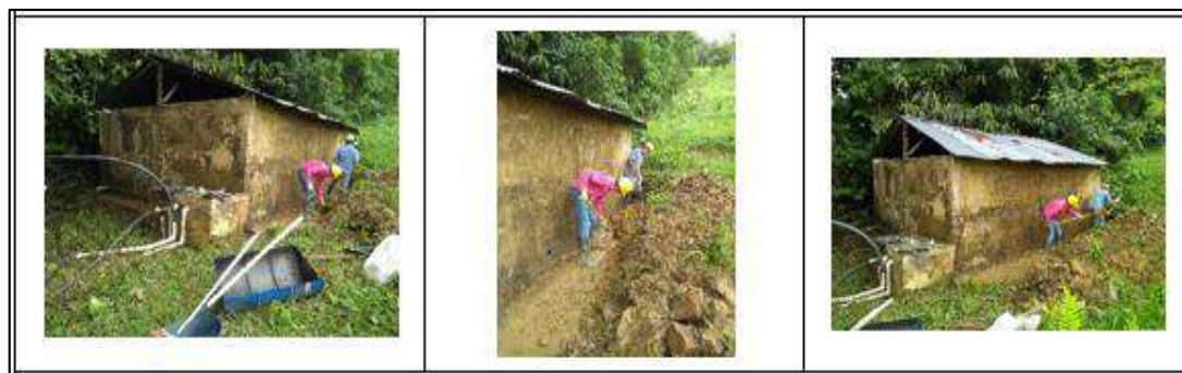
Ilustración 69. Excavaciones en Material Común - Vereda Cerro de la Aurora Fuente: Propia
