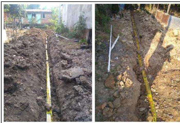
Ilustración 165. Relleno con Material Común 4 - Corregimiento Santo Domingo El Ramo Fuente: Propia
