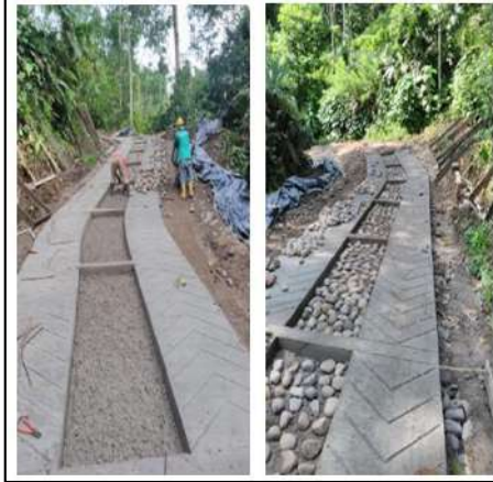
Ilustración 59. Fundida Placa Centro – Vereda La Pitala Fuente: Propia
