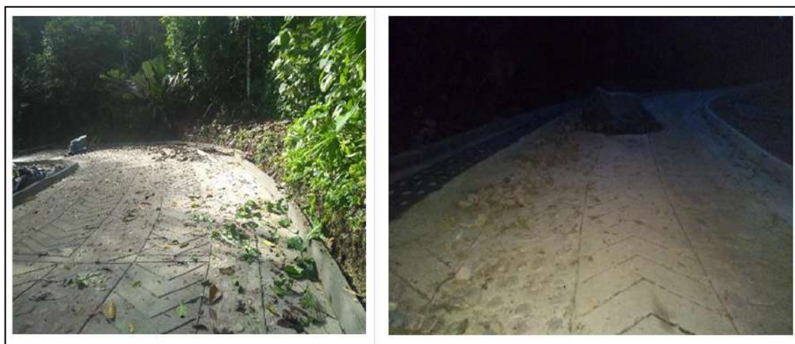
Ilustración 189. Placa Huella (Resultado Final) - Segunda Etapa Fuente: Propia
