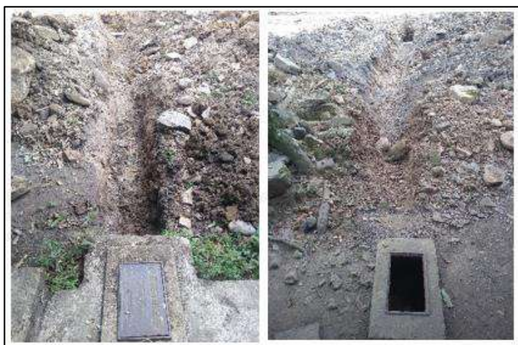
Ilustración 148. Excavación en Material Común 3 - Corregimiento Santo Domingo El Ramo Fuente: Propia
