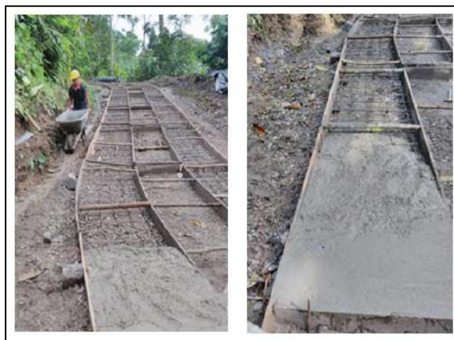
Ilustración 55. Fundida Huellas – Vereda La Pitala Fuente: Propia
