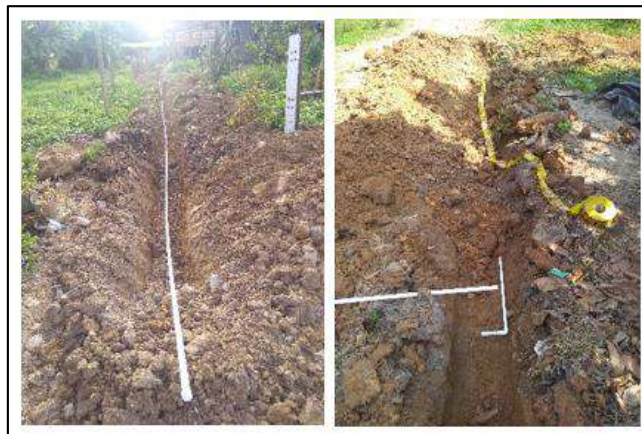
Ilustración 156. Instalación Tubería PVC 1" U.M. 1 - Corregimiento Santo Domingo El Ramo Fuente: Propia
