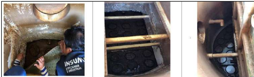
Ilustración 110. Limpieza Fondo Tanque - Vereda La Aguada Fuente: Propia
