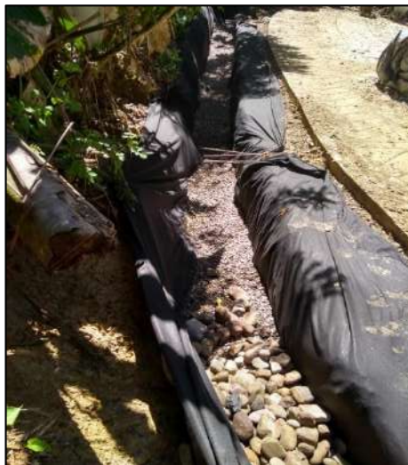
Ilustración 19. Construcción Obra Adicional (Filtro) Fuente: Propia
