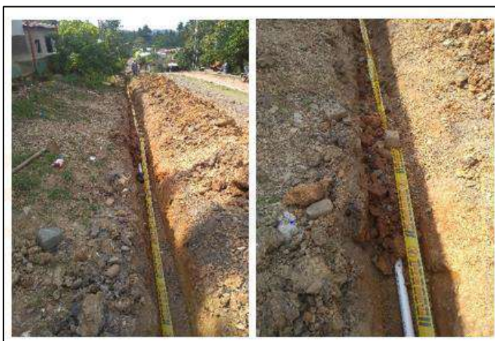
Ilustración 164. Relleno con Material Común 3 - Corregimiento Santo Domingo El Ramo Fuente: Propia
