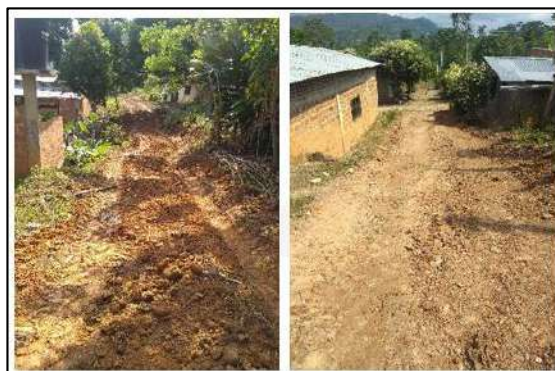
Ilustración 167. Relleno con Material Común 6 - Corregimiento Santo Domingo El Ramo Fuente: Propia
