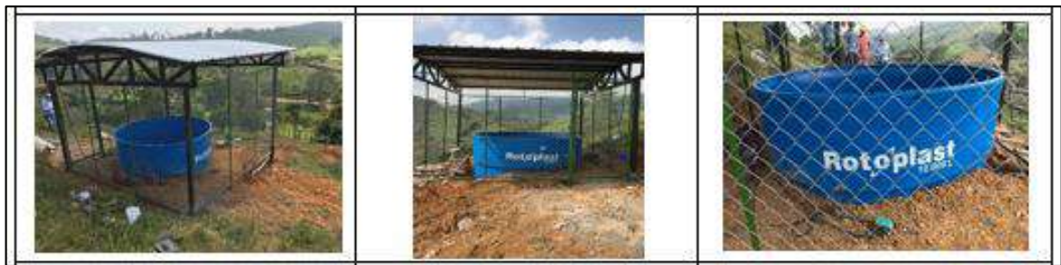
Ilustración 87. Suministro, Instalación y Cubierta Tanque 10.000 lts 1 - Vereda San Joaquín Fuente: Propia
