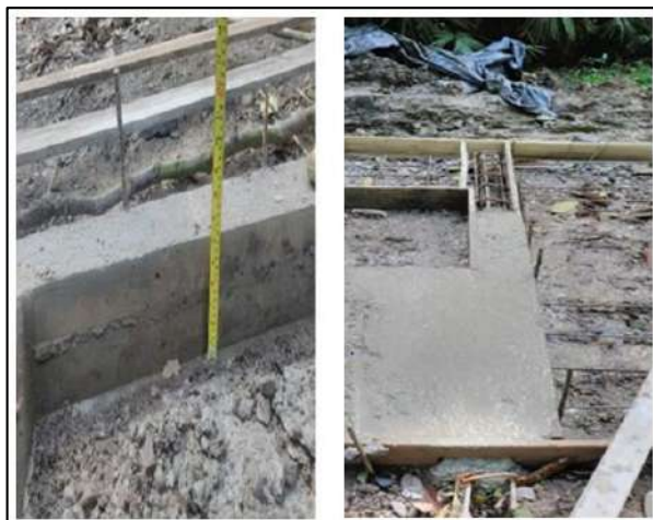
Ilustración 56. Fundida y Medición Vigas Riostras – Vereda La Pitala Fuente: Propia
