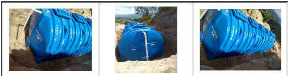
Ilustración 124. Suministro e instalación de tanque (30.000 lts) 1 - Vereda El Oso Fuente: Propia
