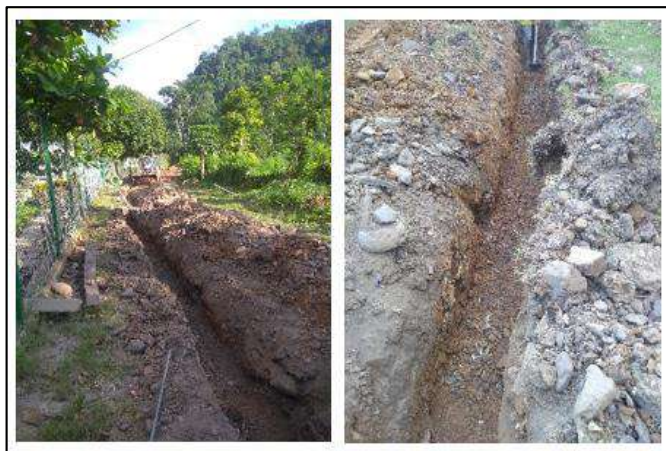
Ilustración 146. Excavación en Material Común 2 - Corregimiento Santo Domingo El Ramo Fuente: Propia
