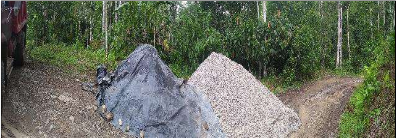
Ilustración 26. Acopio de Material (Triturado y Arena) – Primera Etapa Fuente: Propia
