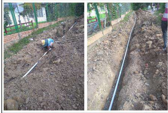
Ilustración 149. Instalación Tubería PVC 2" U.M. - Corregimiento Santo Domingo El Ramo Fuente: Propia
