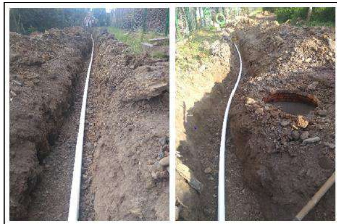
Ilustración 150. Instalación Tubería PVC 2" U.M. 1 - Corregimiento Santo Domingo El Ramo Fuente: Propia
