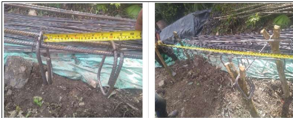
Ilustración 39. Medición de Vigas Riostras – Vereda La Pitala Fuente: Propia
