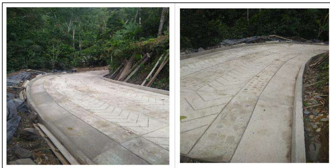
Ilustración 188. Placa Huella (Resultado Final) – Primera Etapa Fuente: Propia
