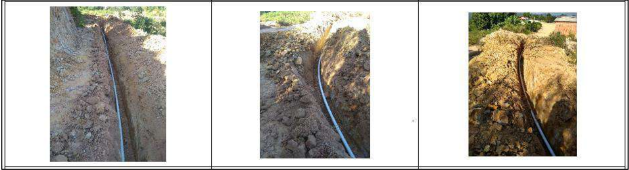
Ilustración 135. Suministro e instalación Tubería PVC 2" 1 – Vereda El Oso Fuente: Propia
