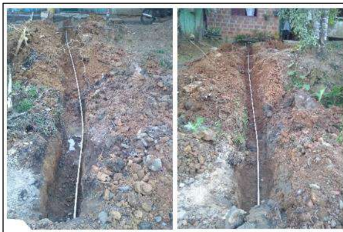
Ilustración 159. Instalación Tubería PVC 1" U.M. - Corregimiento Santo Domingo El Ramo Fuente: Propia
