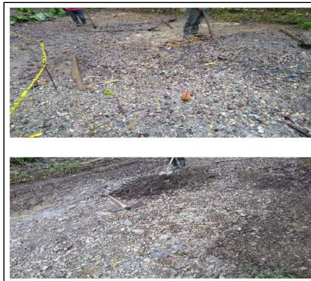
Ilustración 41. Excavaciones en Material Común – Vereda La Pitala Fuente: Propia
