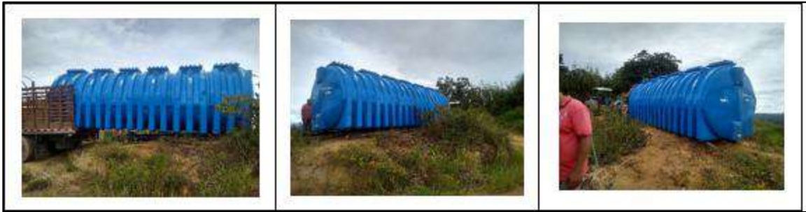
Ilustración 123. Suministro e instalación de tanque (30.000 lts) - Vereda El Oso Fuente: Propia
