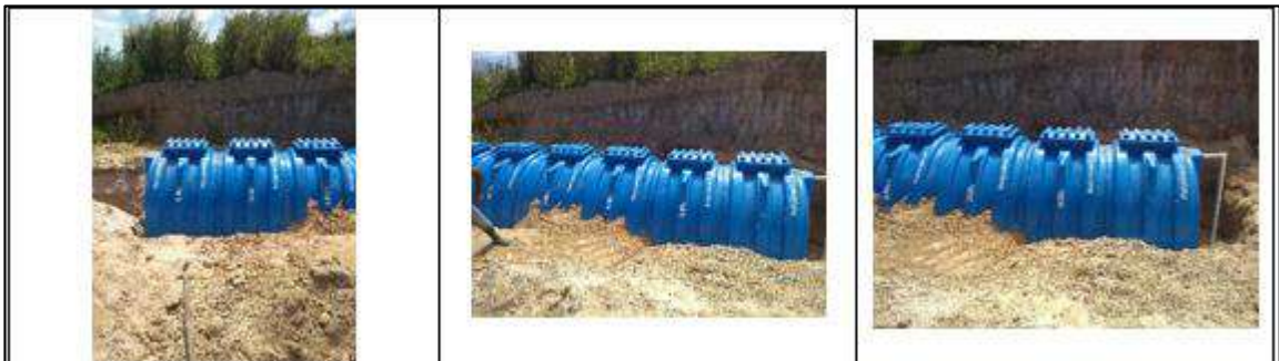
Ilustración 125. Suministro e instalación de tanque (30.000 lts) 2 - Vereda El Oso Fuente: Propia
