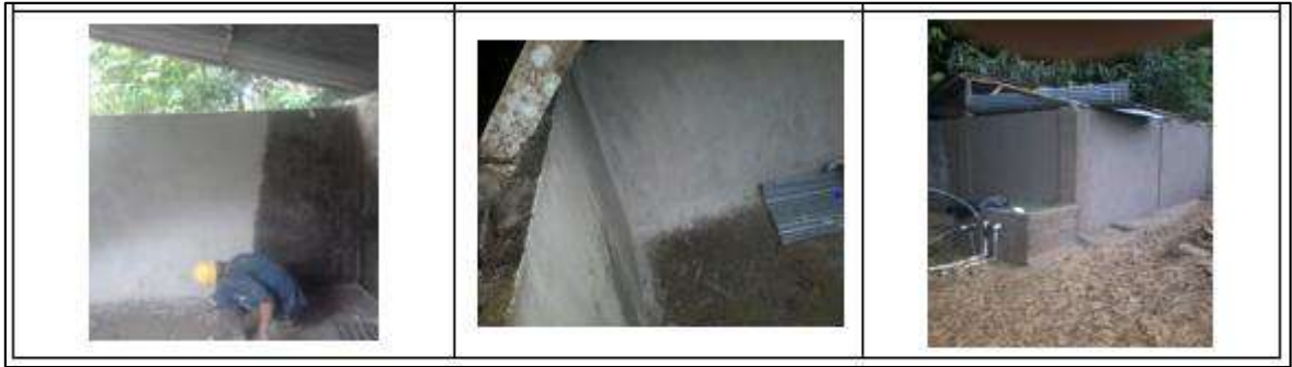
Ilustración 74. Friso Impermeabilizado 1 - Vereda Cerro de la Aurora Fuente: Propia
