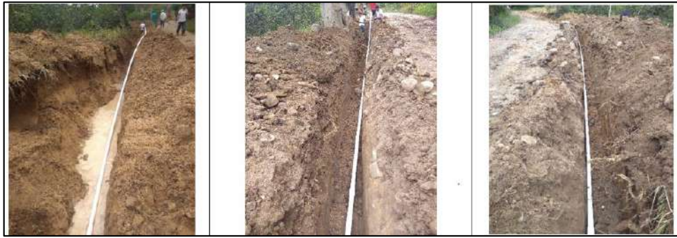
Ilustración 95. Suministro e Instalación Tubería PVC 1 1/2" E.L. RDE 21 2 - Vereda Aguirre Bajo Fuente: Propia
