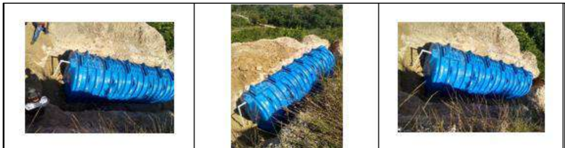
Ilustración 126. Suministro e instalación de tanque (30.000 lts) 3 - Vereda El Oso Fuente: Propia
