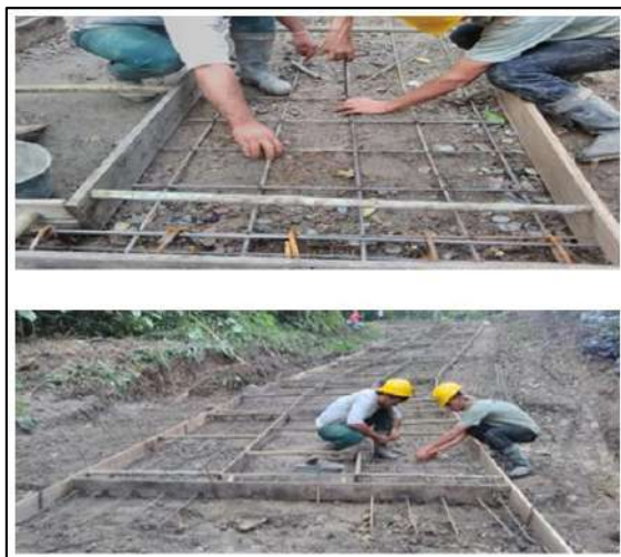
Ilustración 48. Figurado de Acero para Huellas – Vereda La Pitala Fuente: Propia
