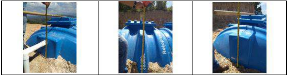
Ilustración 127. Suministro e instalación de tanque (30.000 lts) 4 - Vereda El Oso Fuente: Propia
