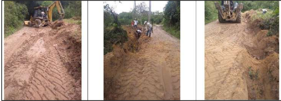
Ilustración 92. Relleno con Material Común 1 - Vereda Aguirre Bajo Fuente: Propia
