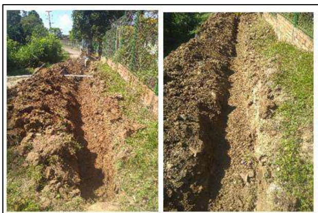
Ilustración 144. Excavación en Material Común - Corregimiento Santo Domingo El Ramo Fuente: Propia
