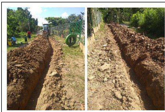
Ilustración 145. Excavación en Material Común 1 - Corregimiento Santo Domingo El Ramo Fuente: Propia
