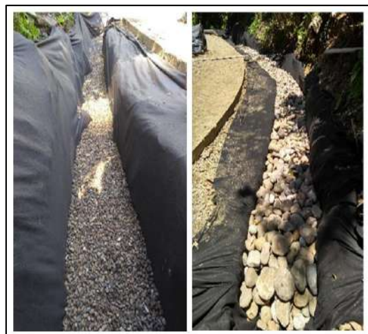
Ilustración 66. Geotextil, Gravilla, Bolo – Filtro – Vereda La Pitala Fuente: Propia
