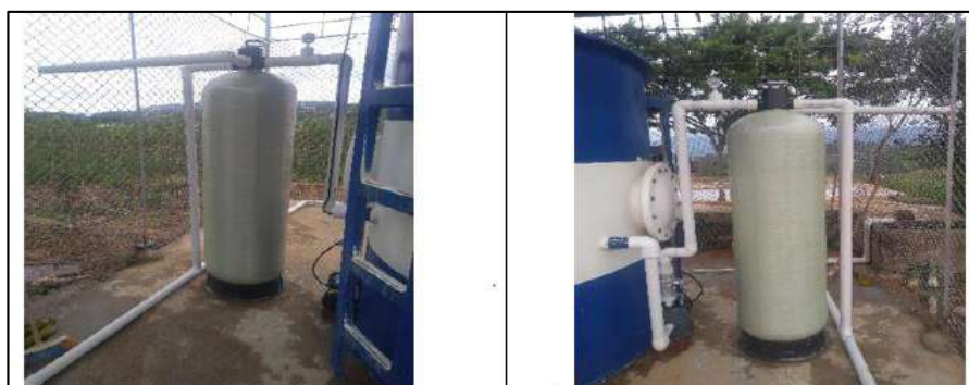
Ilustración 113. Instalación Filtro Nuevo - Vereda La Aguada Fuente: Propia
