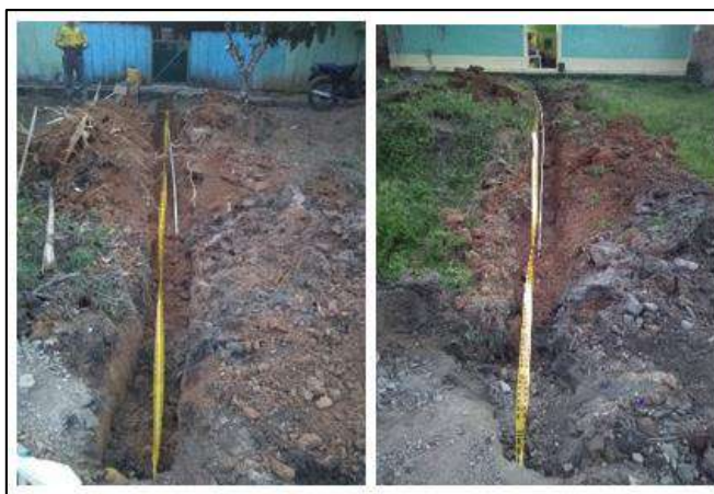
Ilustración 160. Instalación Tubería PVC 1" U.M.1 - Corregimiento Santo Domingo El Ramo Fuente: Propia
