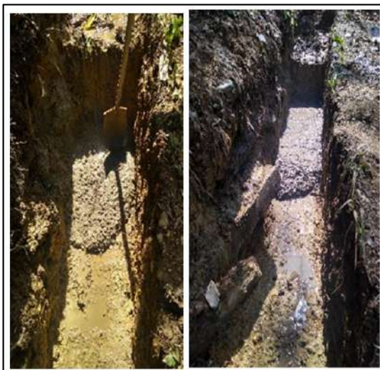
Ilustración 65. Concreto Clase F – Filtro – Vereda La Pitala Fuente: Propia
