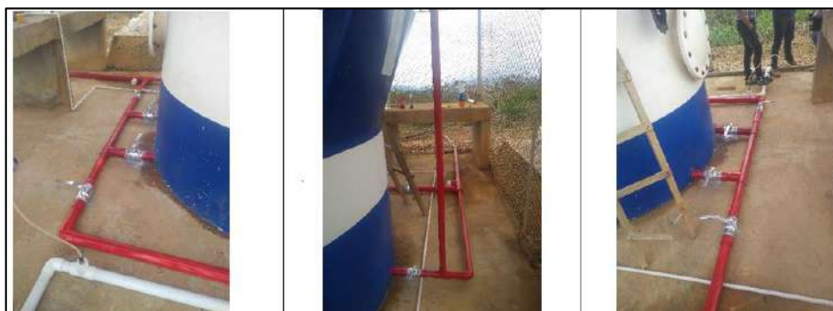
Ilustración 112. Remodelación Tubería Conexión Tanque 2 - Vereda La Aguada Fuente: Propia
