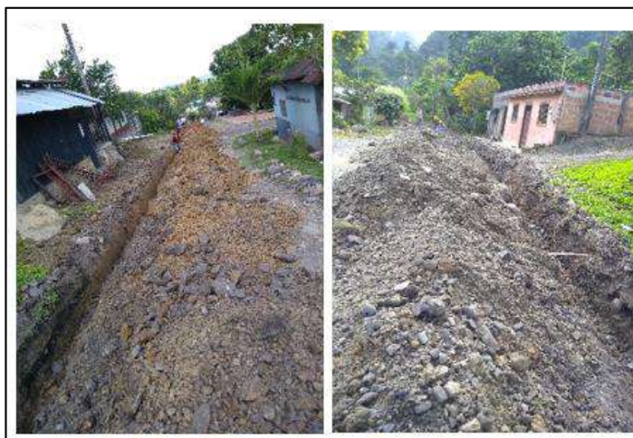
Ilustración 147. Excavación en Material Común 3 - Corregimiento Santo Domingo El Ramo Fuente: Propia
