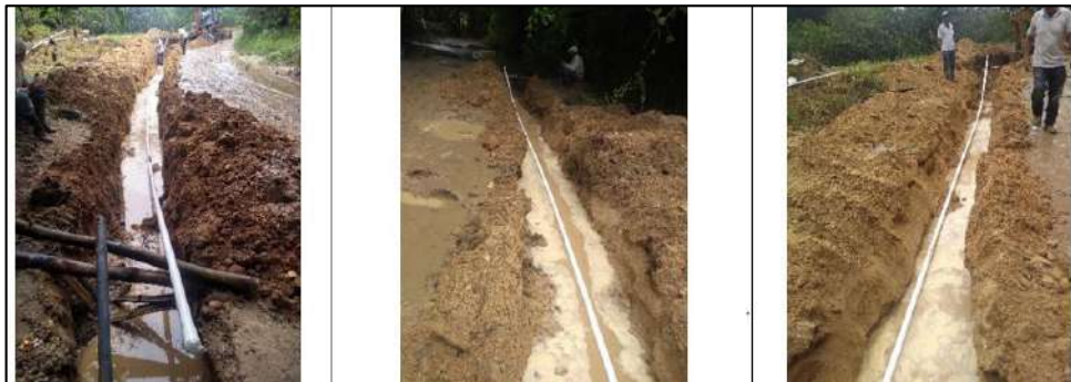
Ilustración 94. Suministro e Instalación Tubería PVC 1 1/2" E.L. RDE 21 1 - Vereda Aguirre Bajo Fuente: Propia
