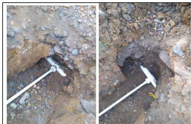
Ilustración 154. Instalación Accesorios para Tubería PVC 2" U.M. - Corregimiento Santo Domingo El Ramo Fuente: Propia
