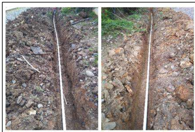
Ilustración 152. Instalación Tubería PVC 2" U.M. 3 - Corregimiento Santo Domingo El Ramo Fuente: Propia
