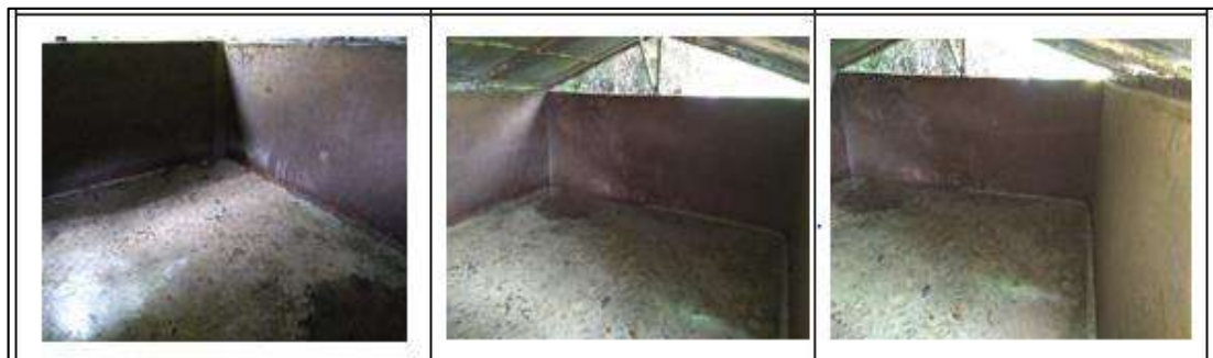
Ilustración 71. Demolición Friso Existente 1 - Vereda Cerro de la Aurora Fuente: Propia
