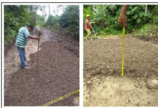
Ilustración 46. Medición del Material Afirmado – Vereda La Pitala Fuente: Propia
