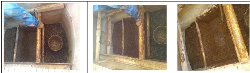
Ilustración 106. Limpieza del Floculador - Vereda La Aguada Fuente: Propia
